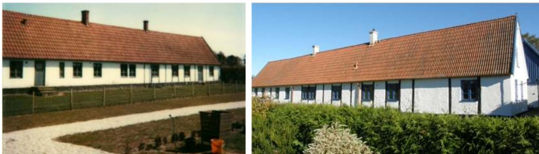
Kontors- och förrådsbyggnaden "2:an". Till vänster fotografi från 1980 då den användes som scoutgård. Två dörrar i västra fasaden har sedan dess murats igen. På bilden syns också en del av kvarter F. Sedan dess har nya gravar tillkommit i kvarteret och en hög tujabäck avgränsar kvarteret mot gården, västra fasaden är numera en sluten baksida.
