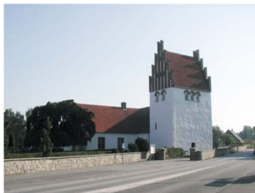
Numera ligger öppningen mot norr i stil med den södra och muren har anpassats för att få plats med en parkering längs med Flyngevägen. Båda grindöppningarna har breddats för att anpassas till biltransporter. Vy från nordväst i oktober månad.
