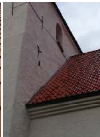
Utbytt plåt efter åtgärderna.
