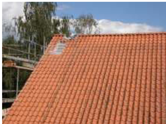
Borttagen skorsten under pågående renovering.
