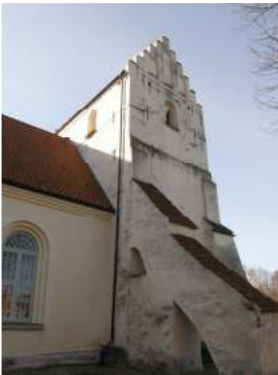
Norra sidan av tornet med stödbenet före.
