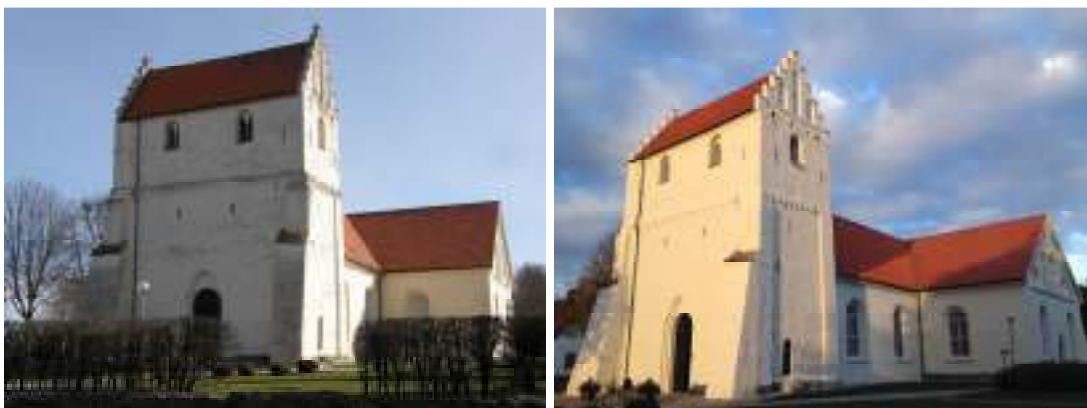
Sydvästra fasaden på kyrkan före och efter åtgärderna.
