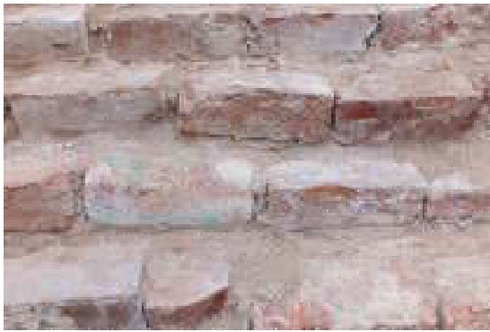
Återavända tegelstenar i stödbenet. Stenen med färgrester plockades bort och förvaras inne i kyrkan.
