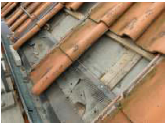
Förbrukad undertakslagning.
