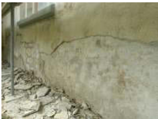
Södra långhusväggen efter putsborttagningen.
