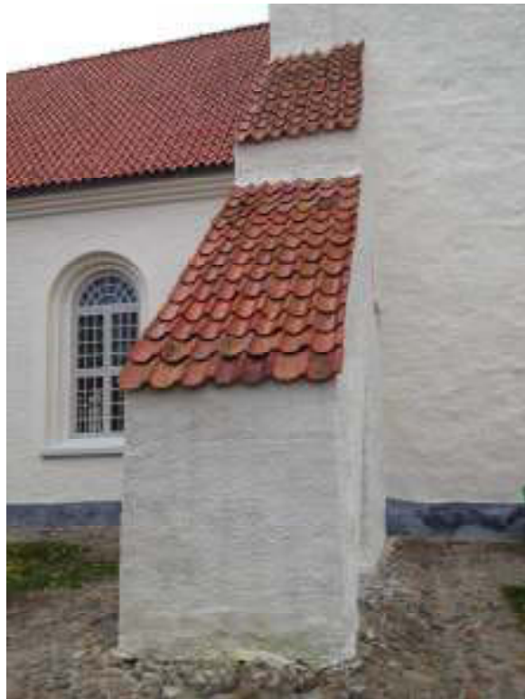
Under nypåläggningen av teglet. T.b. Strävbågen efter åtgärderna. Notera rinnmärkena, samt missfärgningar vid grunden.
