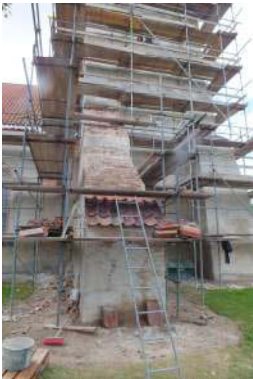
Under nypåläggningen av teglet. T.b. Strävbågen efter åtgärderna. Notera rinnmärkena, samt missfärgningar vid grunden.
