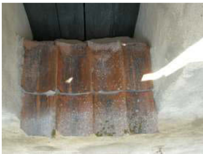
Torngluggarna före och efter tätningen vid tornluckan.
