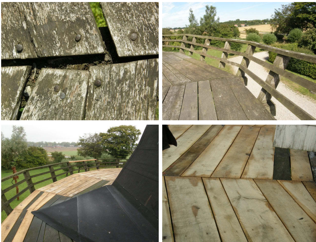
Övre bilderna visar segelbanans gångbrädor och räcke innan renoveringen. De undre bilderna visar de nya brädorna och även en del av räcket. Efter en tid kommer färgen på det nya virket att förändras och likna det gamla.
