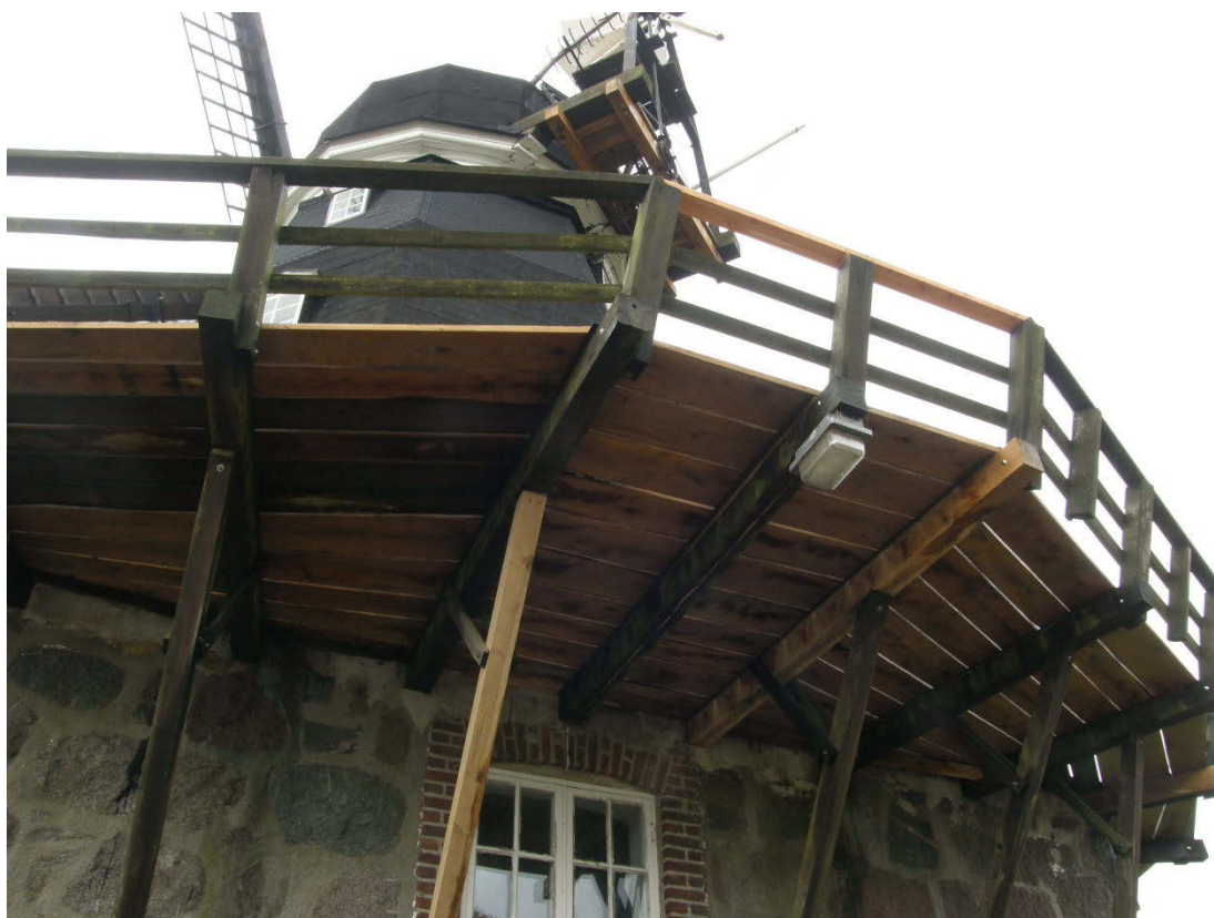
Segelbanan underifrån efter renoveringen.
