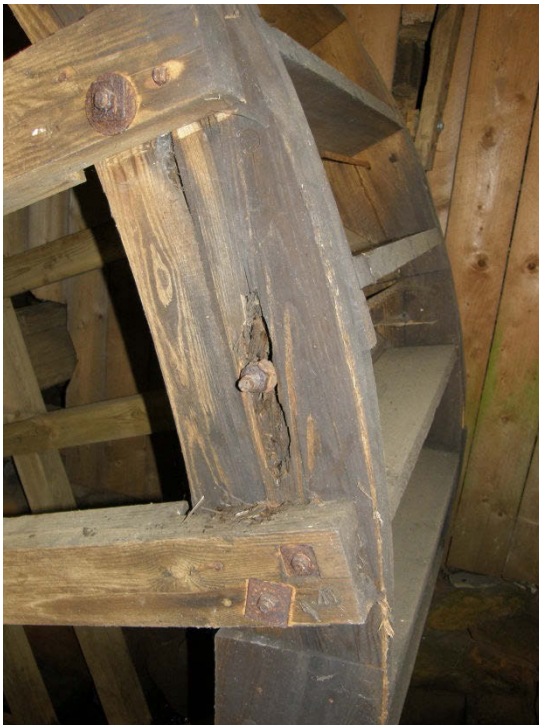
Ovan till vänster: Innan kvarnhjulsfundamentet åtgärdats. Nedan till vänster: Rötskada på kvarnhjulet.
