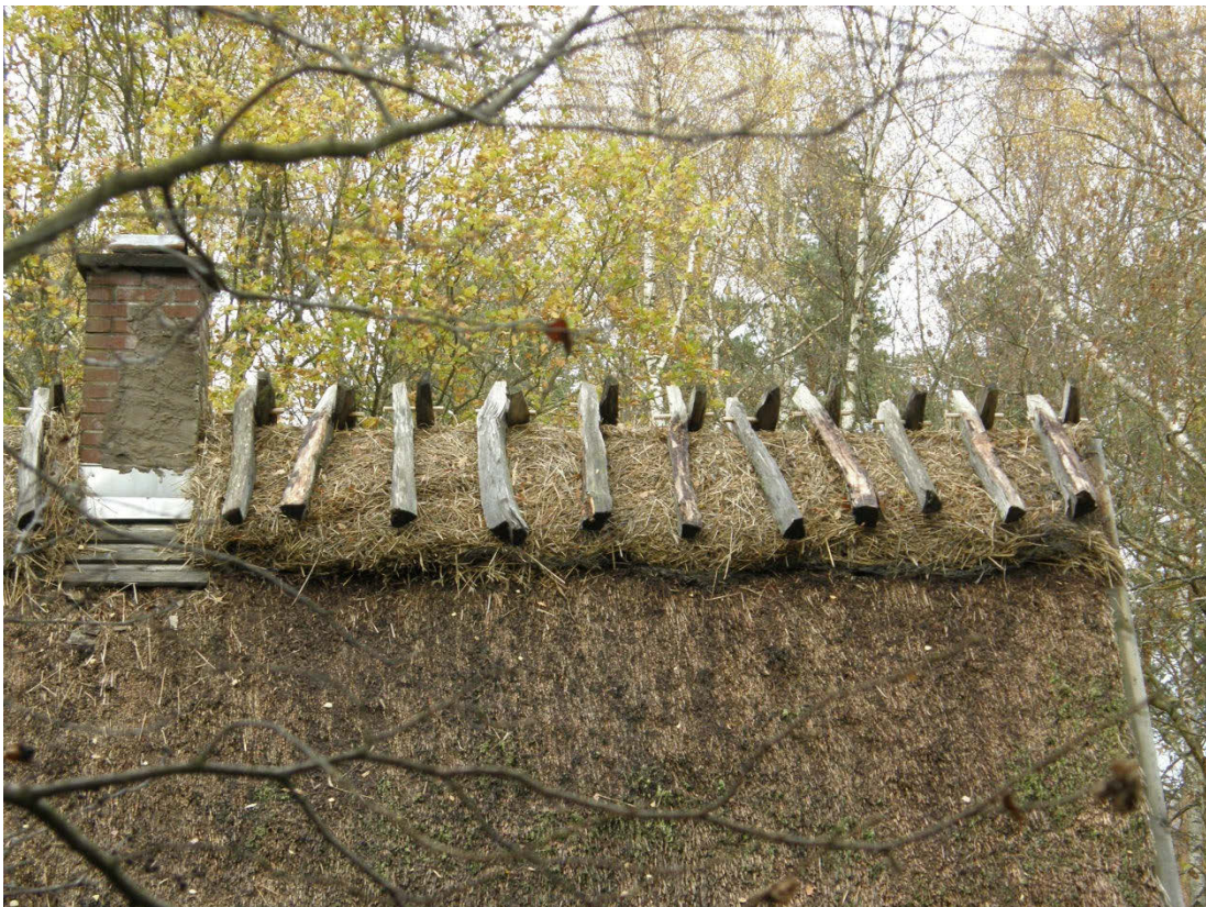
Övan: Båda byggnaderna omryggade. Nedan: Detalj av bostadhusets omryggade tak.
