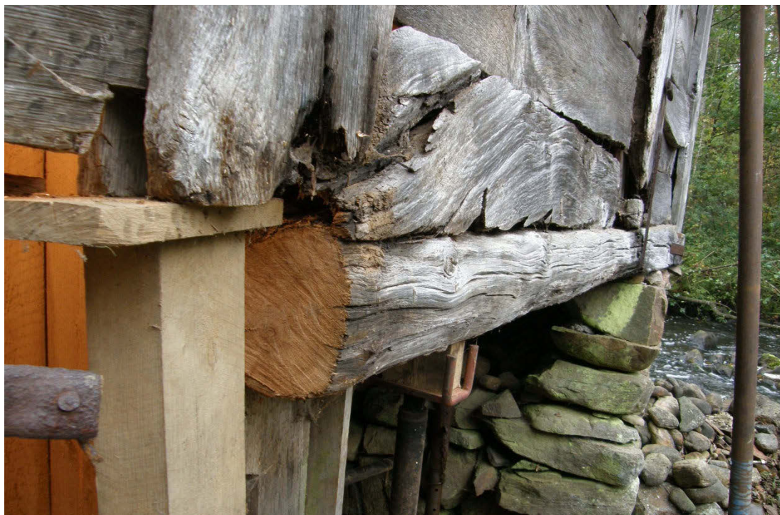
Pågående arbete, väggen är öppnad för att lättare komma åt kvarnhjulet, fotträ och båle stöttat. Märk byggnadens lutning.
