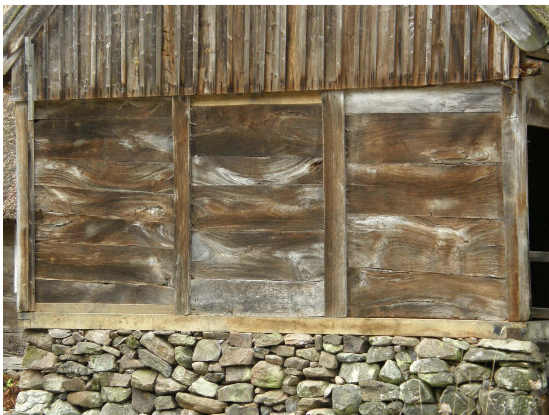
Södväggen med omlavad stensockel och renoverade bålstolpar och båleplank.
