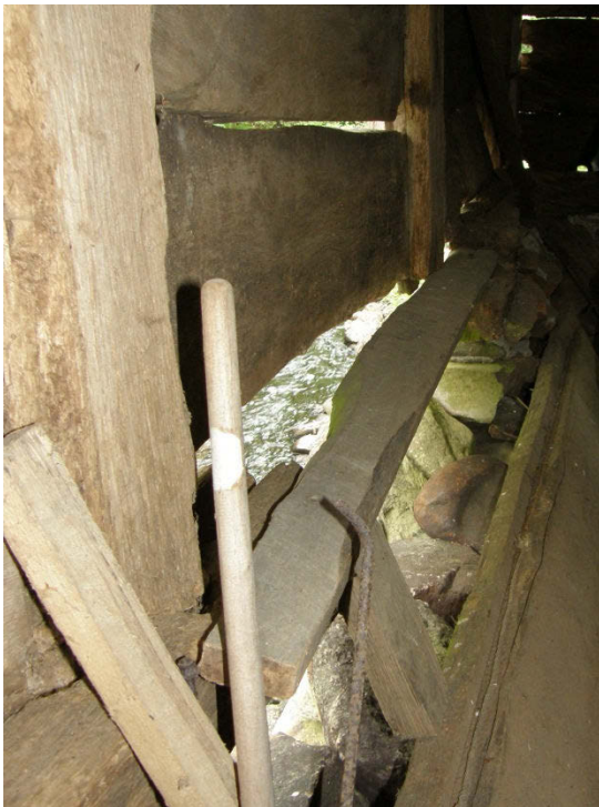
Övan till vänster: Stensockel, fotträ och bälte innan åtgärd. Nedan till vänster: Söderväggen innan renoveringen.
