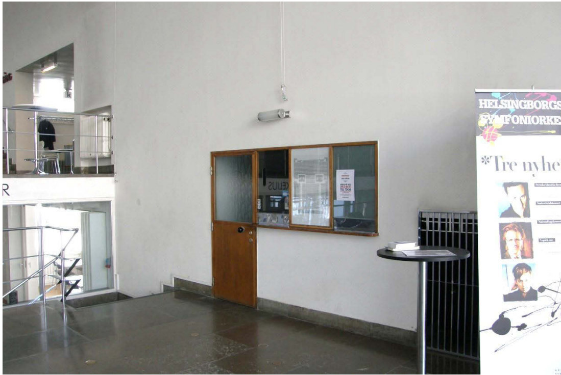
Parti vid biljettlucka på norra sidan före renoveringen.
