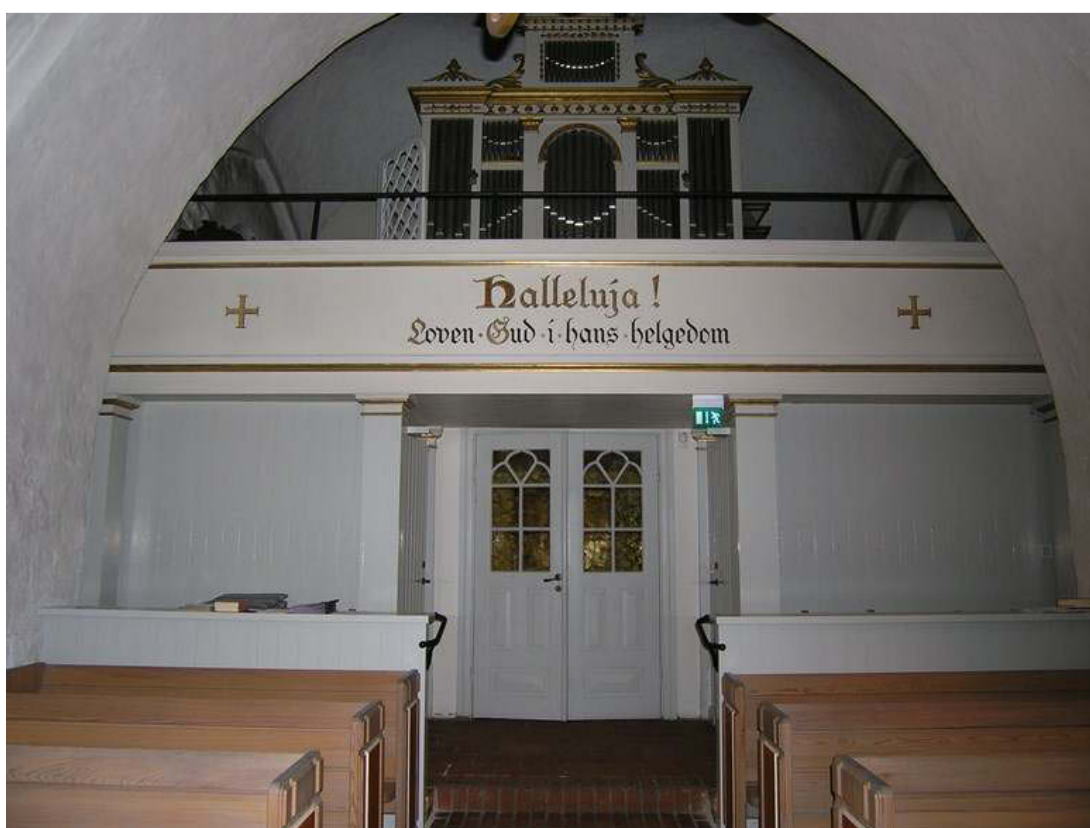
Pågående rivning och uppbyggnad av läktarunderbyggnad i långhuset. Nedan den färdigställda läktarunderbyggnaden. Murade barriärer ersatta med träskrank och nya handledare av rundjörn.
