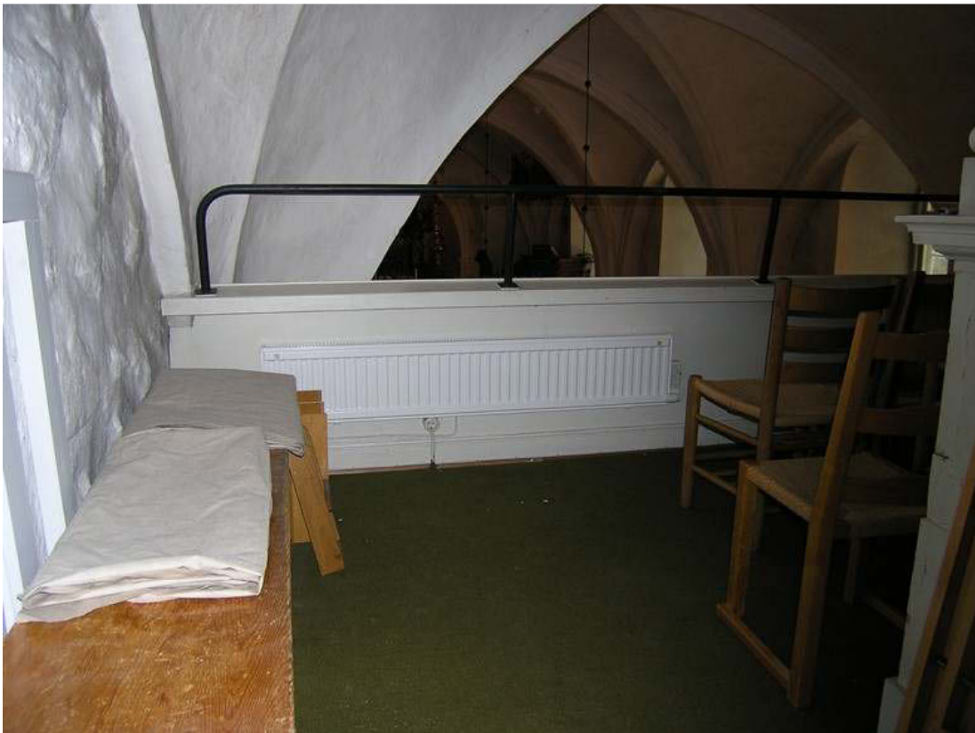
I vapenhuset har det tidigare klarlackade innertaket målats med linoljefärg och till höger syns den nya hatthyllan. Nedan en bild på den nyinstallerade radiatorm på baksidan av långhusets läktarbarriär. Syftet är att denna skall motverka kallras ner på vaktmästarens sittplats.
