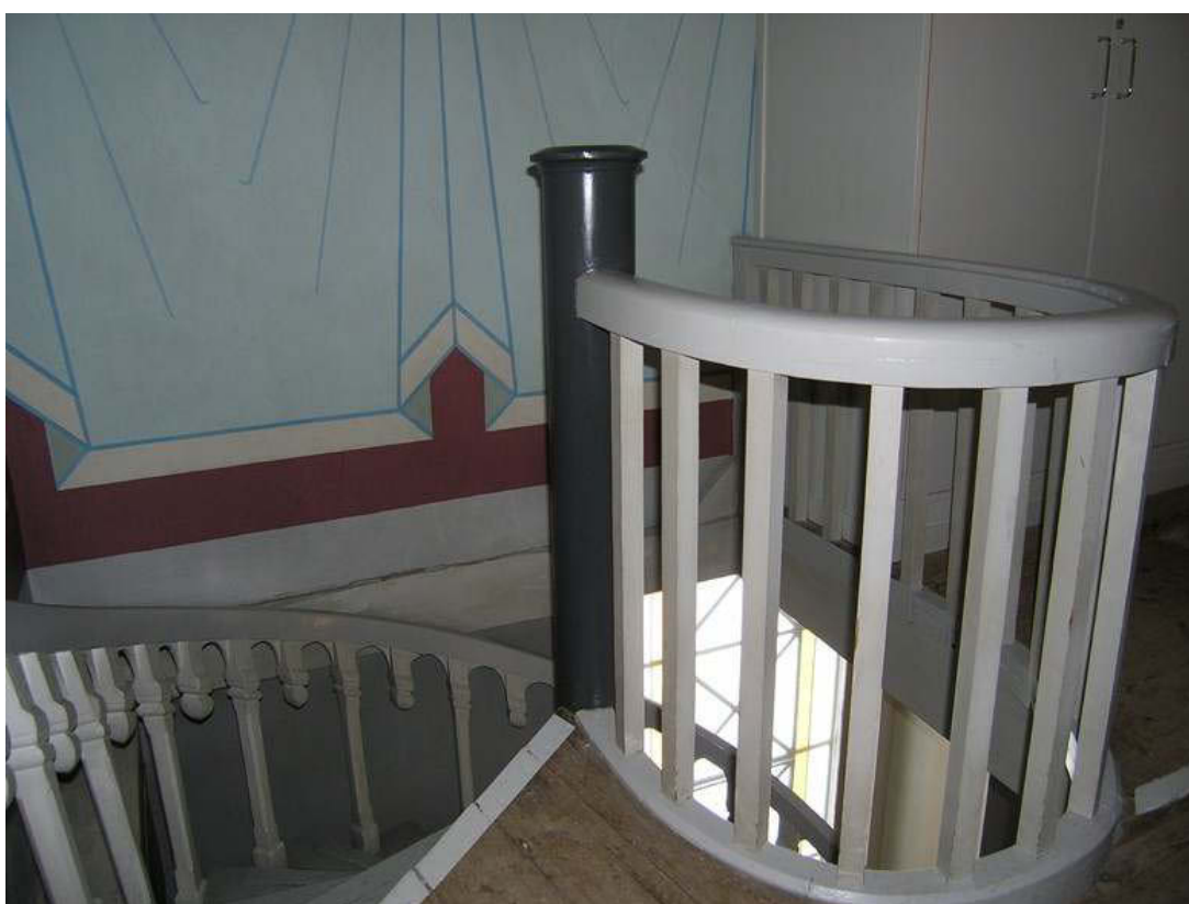
Spiraltrapporna i sidoskeppens norra och södra ändar har delvis målat; spindel i mörket grå kulör och handledare i ljus grå.
