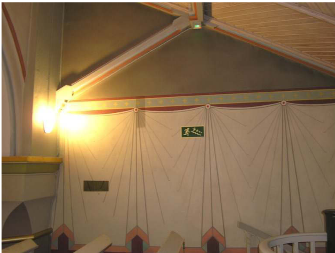
Den mörkt gröna rutan till vänster i bild är den originalmålning som framkom när ett elskåp demonterades. I bildens övre del syns en del av utrymningslarmet samt utrymningsskylt.
