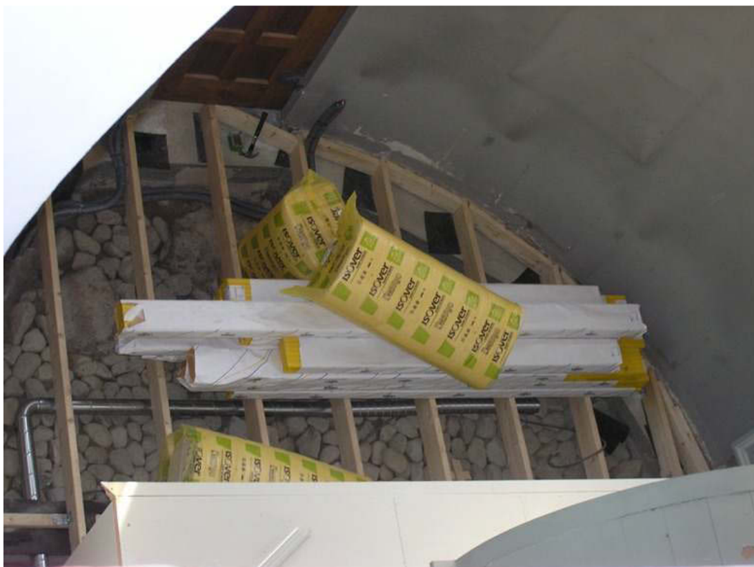
Pågående renovering av golv i sakristia. Grunden isolerad med flatsten, trossbotten isolerad med glasfiberull och ett nytt trögolv från siljansgolv. I grunden är en avfuktare monterad.
