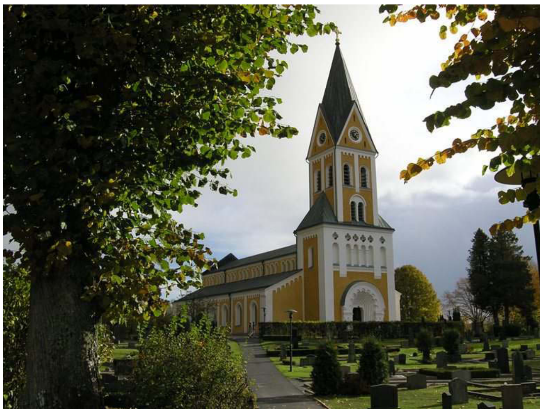
Bräkne-Hoby kyrka efter avslutad fasadrenovering, hösten 2012.
