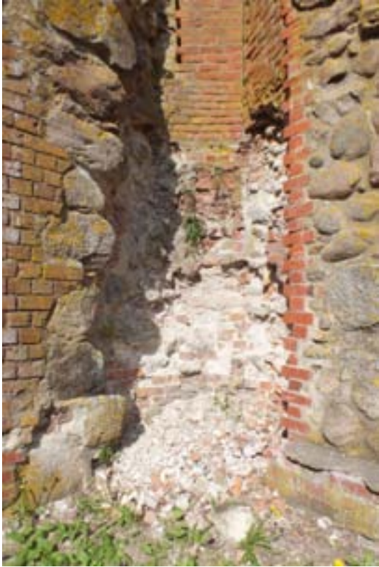
Till vänster: Murnisken vid västra gaveln vittrar i stor omfattning. Till höger: i valvet över västra porten syns en del bortfallna stenar. Nedan t.v. syns en spricka i fogbruket mellan fönsteröppningarna i tredje plan. Nedan: sydvästra hörnet.
