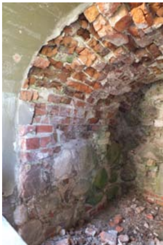
Till vänster: Spricka i östra murnischen med skador i omfattning samt i det murade valvet. Nedan till vänster: skador i omfattning till södra källaren. Till höger syns valvet i södra murens västra källare.
