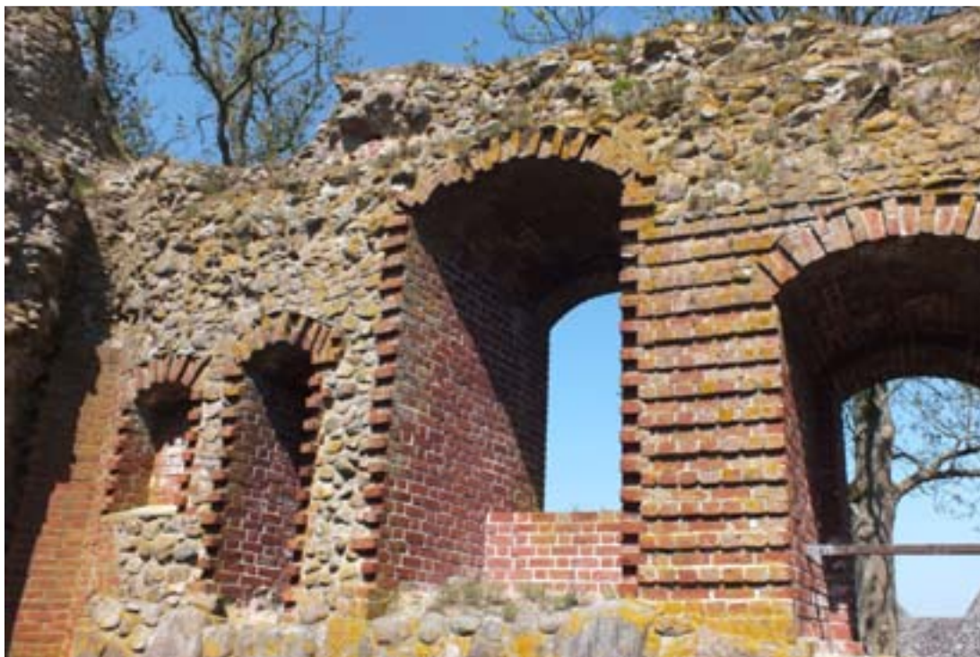
Norra muren, övre parti mot väster. En hel del växtlighet finns på murens insida och muravsatser.
