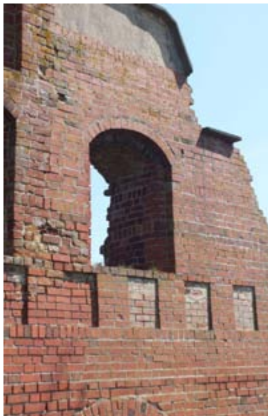
Till vänster: ett nytt murskal ligger utanpå ett äldre murverk. Fogarna har vittrat i stor omfattning och stenar har börjat lossna. Till höger syns gavelns övre södra hörn. Under betongavtäckningen syns en svag spricka.
