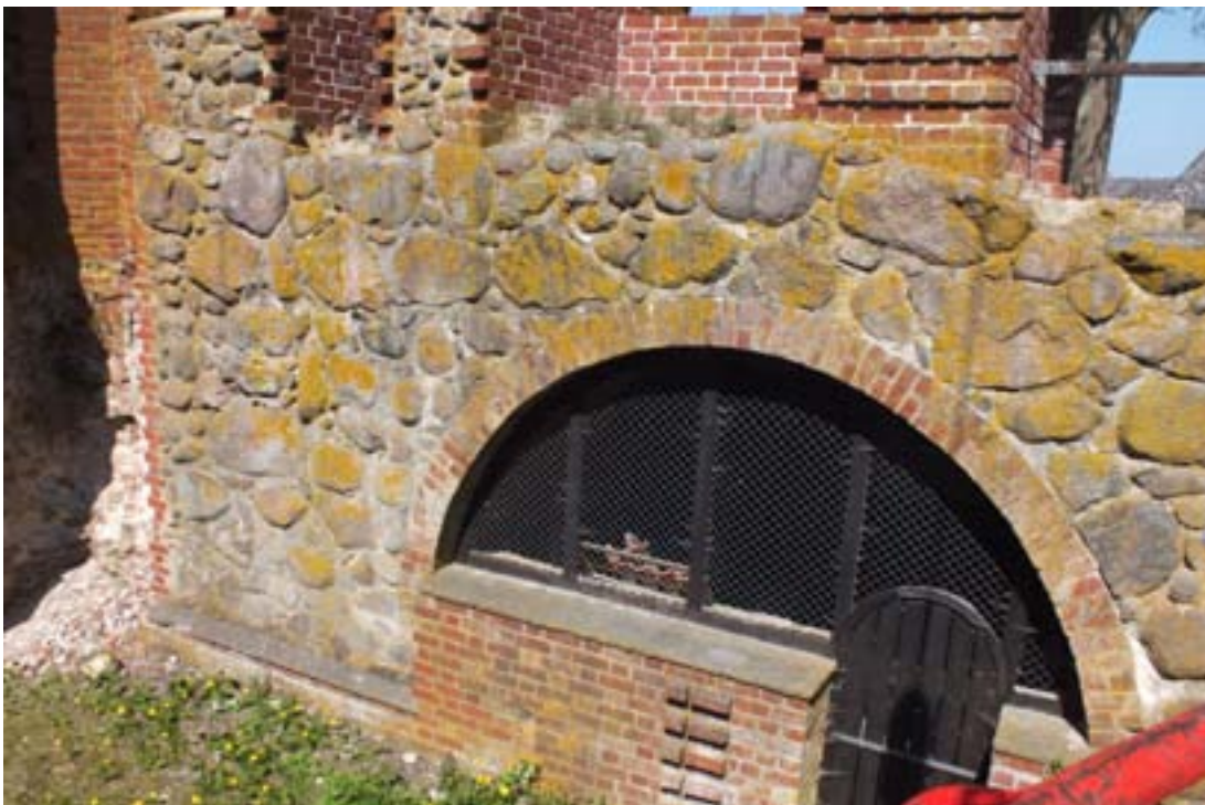
Norra murens västra del.
