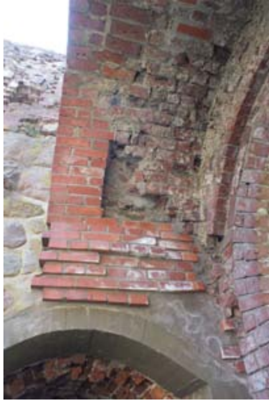
Till vänster: Murnisken vid västra gaveln vittrar i stor omfattning. Till höger: i valvet över västra porten syns en del bortfallna stenar. Nedan t.v. syns en spricka i fogbruket mellan fönsteröppningarna i tredje plan. Nedan: sydvästra hörnet.
