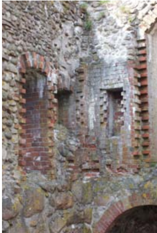
Till vänster: Murnisken vid västra gaveln vittrar i stor omfattning. Till höger: i valvet över västra porten syns en del bortfallna stenar. Nedan t.v. syns en spricka i fogbruket mellan fönsteröppningarna i tredje plan. Nedan: sydvästra hörnet.
