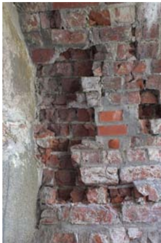
Till vänster: Spricka i östra murnischen med skador i omfattning samt i det murade valvet. Nedan till vänster: skador i omfattning till södra källaren. Till höger syns valvet i södra murens västra källare.
