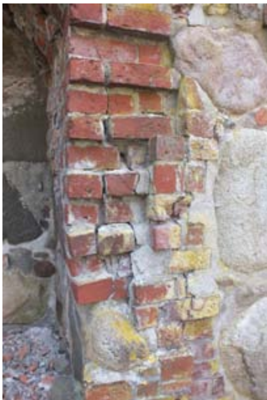
Till vänster: Spricka i östra murnischen med skador i omfattning samt i det murade valvet. Nedan till vänster: skador i omfattning till södra källaren. Till höger syns valvet i södra murens västra källare.
