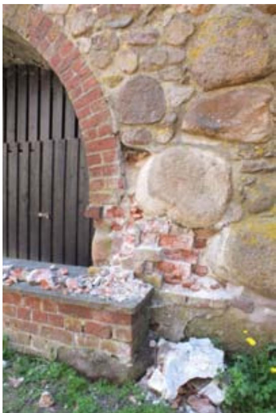
Till vänster: Spricka i östra murnischen med skador i omfattning samt i det murade valvet. Nedan till vänster: skador i omfattning till södra källaren. Till höger syns valvet i södra murens västra källare.
