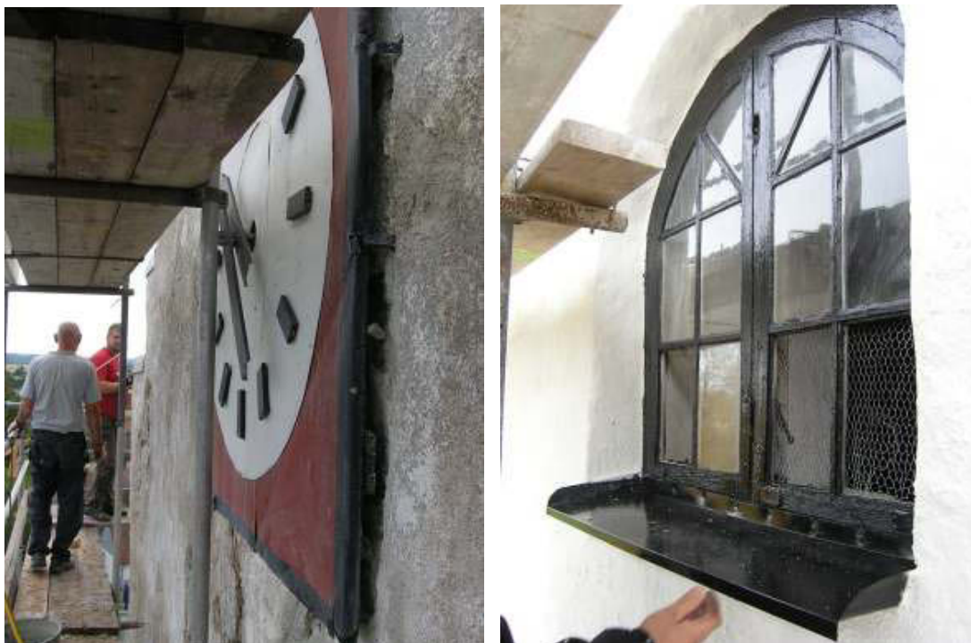
Bilden t.v. visar urtavlan med utbytta visare samt markörer för timmar. T.v. ett av de nyrenoverade fönstren.
