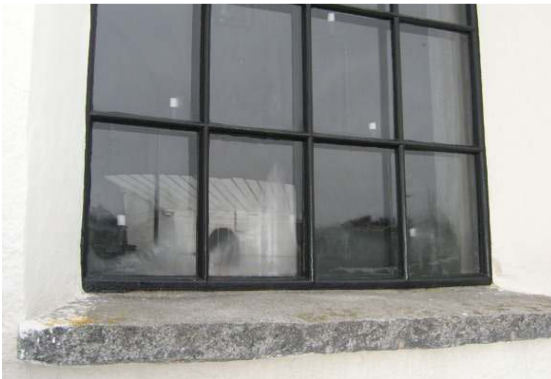
Den övre bilden visar kyrkans norra och västra fasader efter färdigställd renovering. Den nedre bilden visar ett av de ommålade gutjärnsfönstren på norra fasaden.
