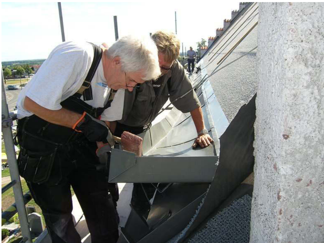
Bilden ovan visar taken med Vapo-zink underlagspapp. Den nedre bilden visar tillverkning av fotränna till länghuset.
