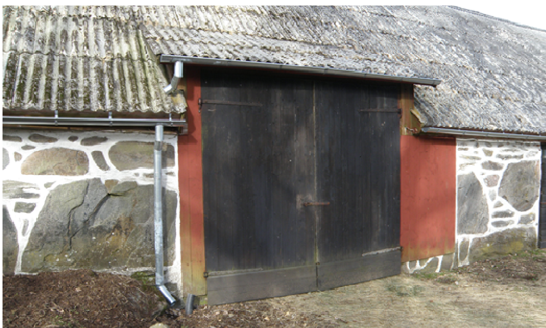
Fig. 16. Östra längans östra fasad. Hängrännanorna i anslutning till den större porten.
