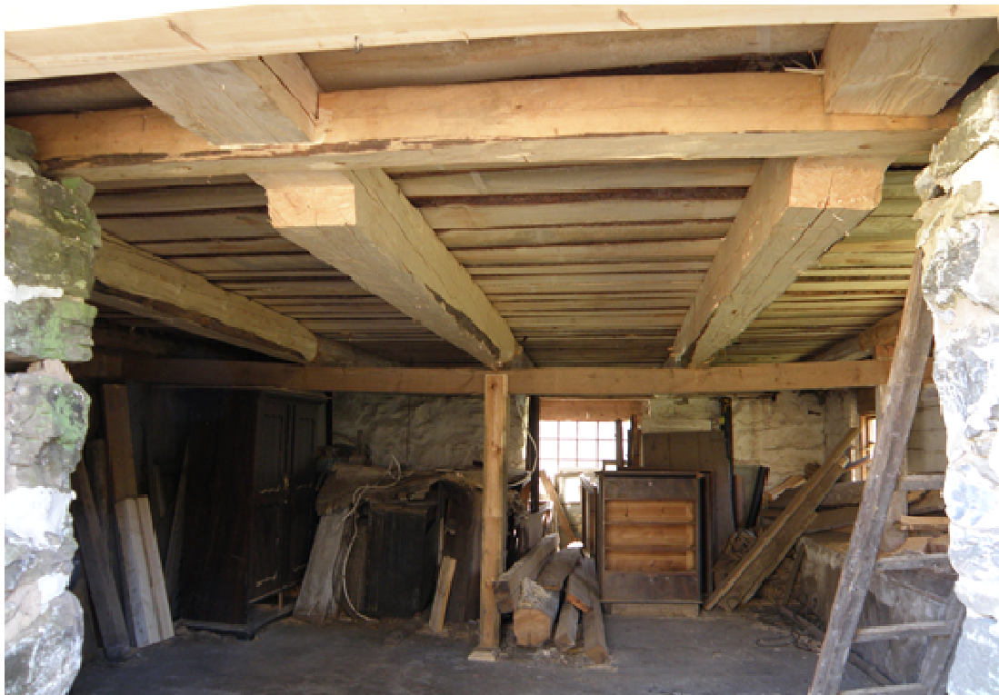
Fig. 11. Nya bjälkar i Hönsbuset.
