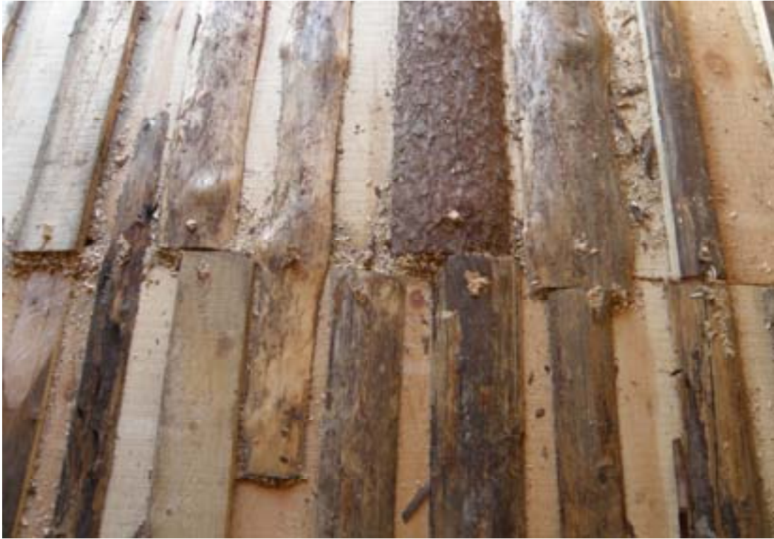
Fig. 13. Nytt golv av granbakar. Notera dubben som fixerar de underliggande plankorna.
