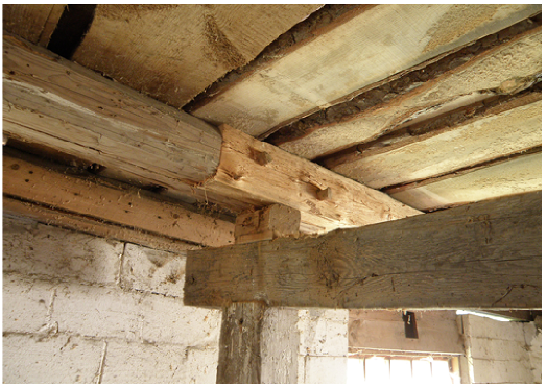
Fig. 12. Den södra bjälken pallades upp på bärlinan likt tidigare utförande.
