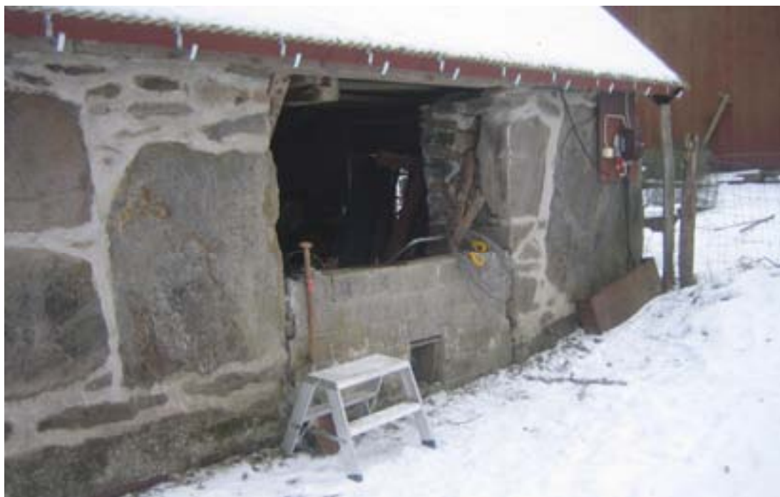
Fig. 8. Innan nedtagningen av cementblocken. Foto Olof Andersson.
