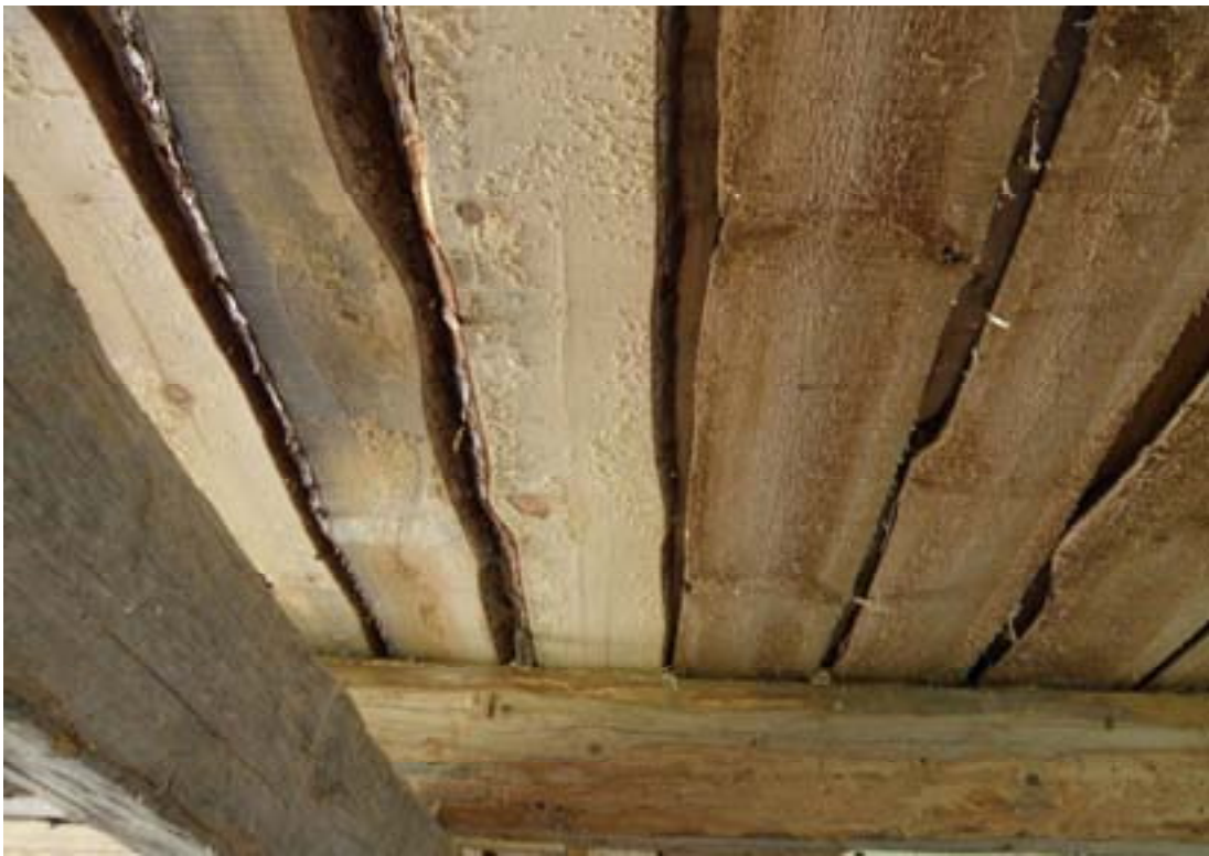
Fig. 14. Nytt golv underifrån.
