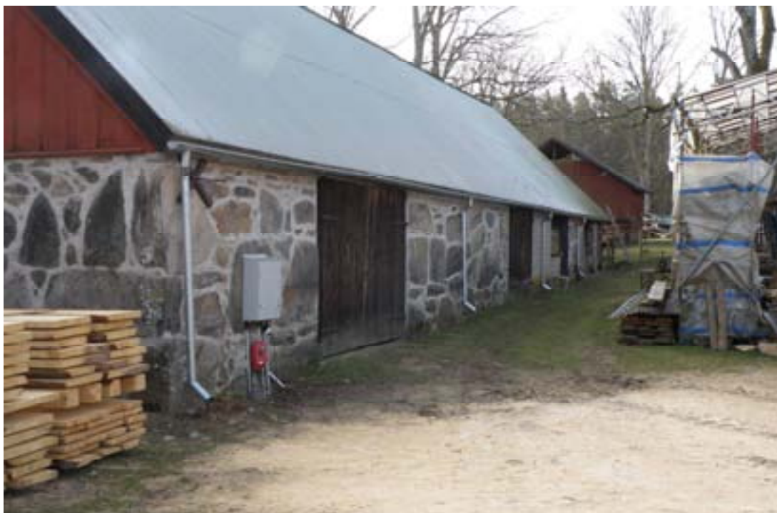
Fig. 15. Hängrännor och stuprör på Östra längans västra fasad.
