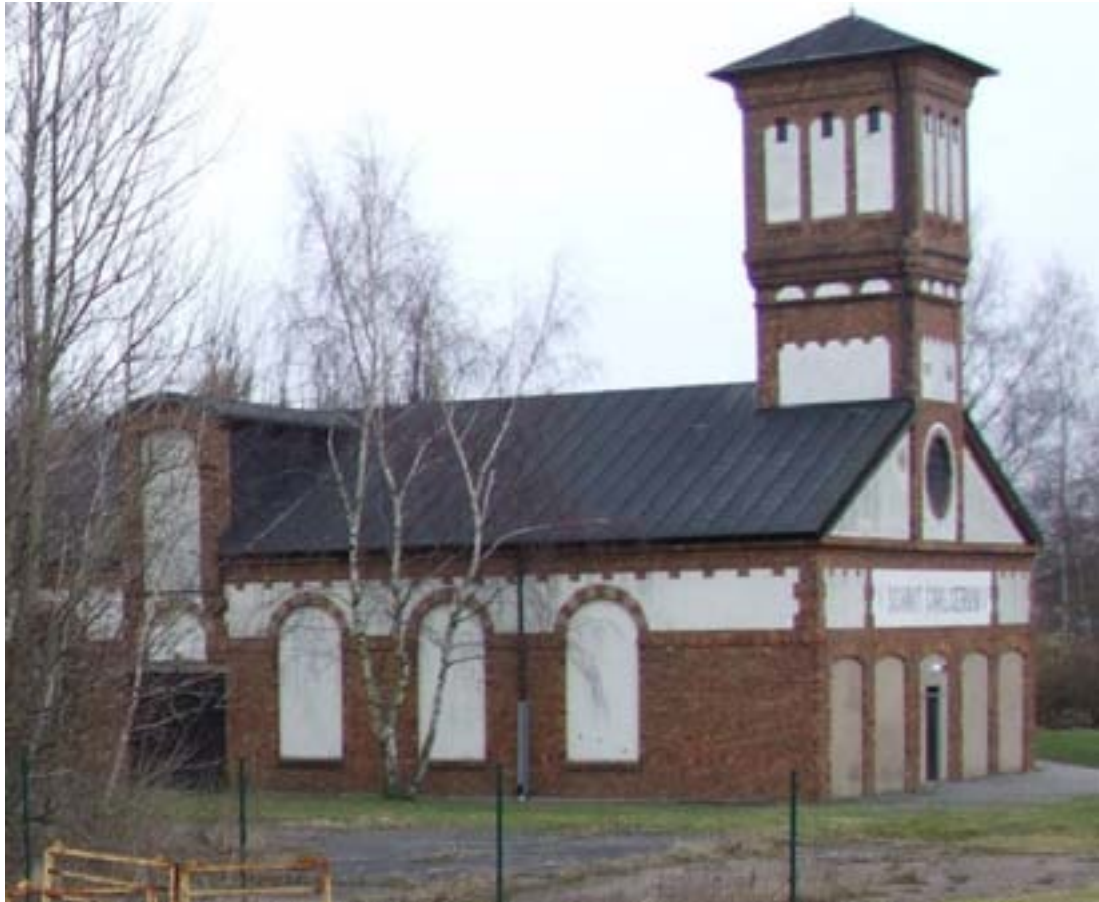
Schaktbyggnaden Foto Nyvångs gruvmuseum.
