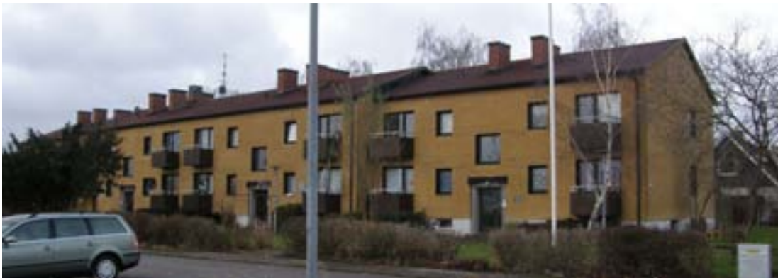
Nyvångs två flerbostadshus, från 1950-talet. Överst det på Kolgatan, underst det ombyggda pensionärshemmet på Svedbergsgatan.
