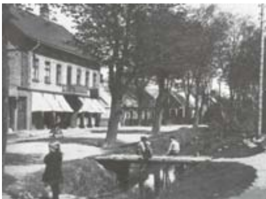
Höganäs, kanalen vid Brors backe, tidigt 1900-tal
