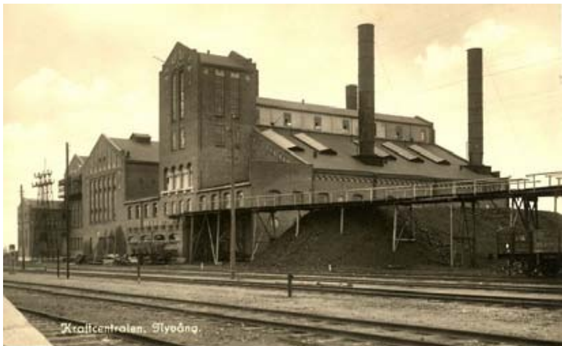
Kraftcentralen. Foto Nyvängs gruvmuseum.
