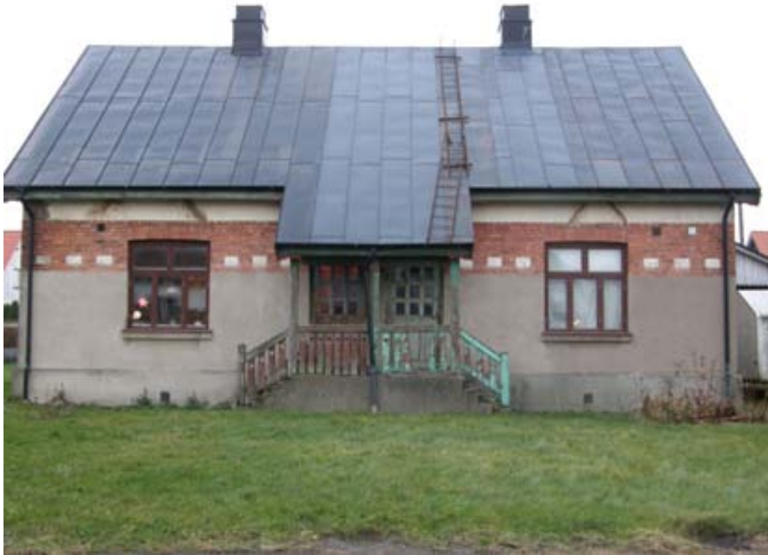
Humlagatan 3, originalskick med undantag av taket som lags om med bandplåt.
