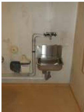
Den nya utslagsbacken på toaletten.
