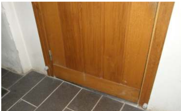
Dörrstoppare utanför teknikrummet.
