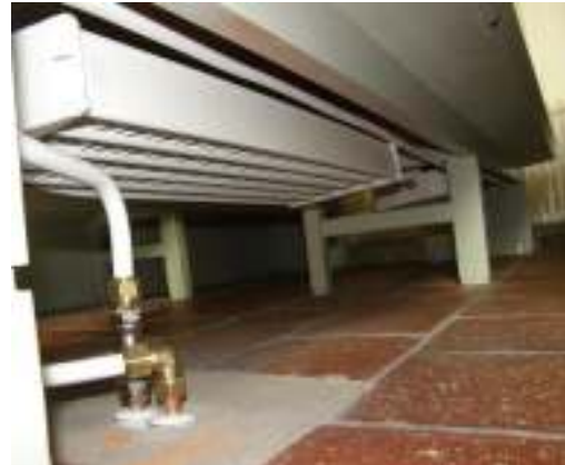
Bänkvärmarna monterade.
