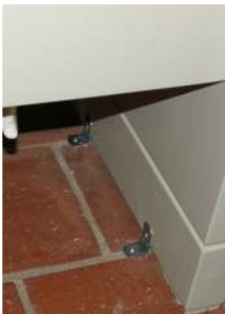
Exempel på vinkeljärn som bänkarna är fastskruvade i golvet med.
