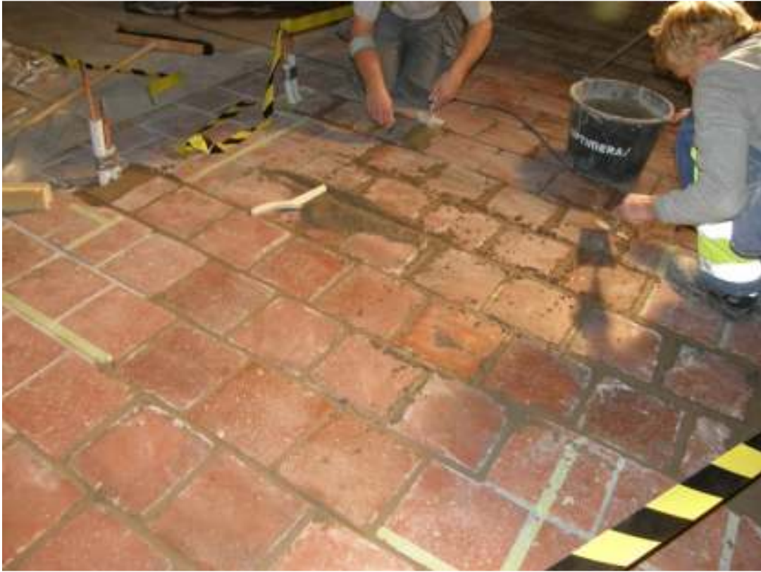
Murarna arbetar med att återlägga tegelgolvet.
