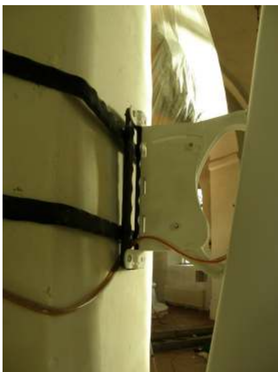
Uppfästningen av högtalaren på den fristående pelaren.
