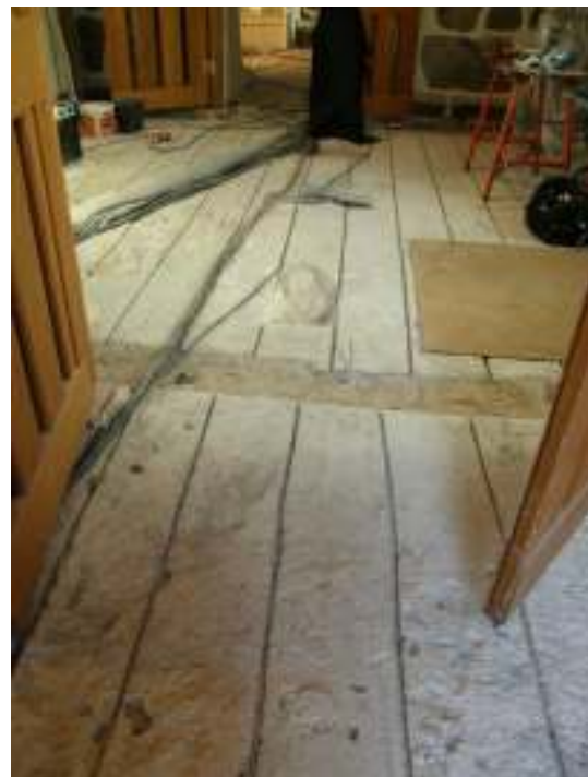
Betongplattan i vapenhuset efter att kanaler frästs upp.
