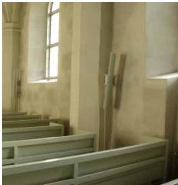
Högtalarna på den södra väggen, samt bänkinredningens nya färg.
