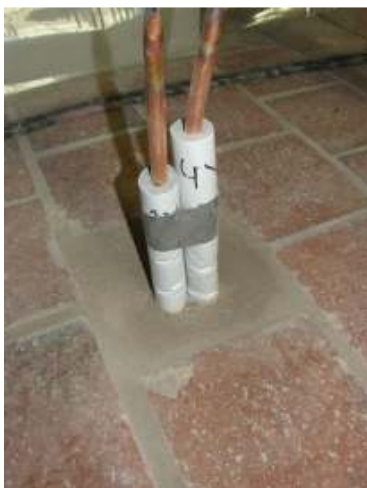
T.v. Den gjutna plattan där rören till bänkvärmen kommer upp. Mitten: golvet återlagt i dopkapellet. T.h. Golvfrisen i vapenhuset.
