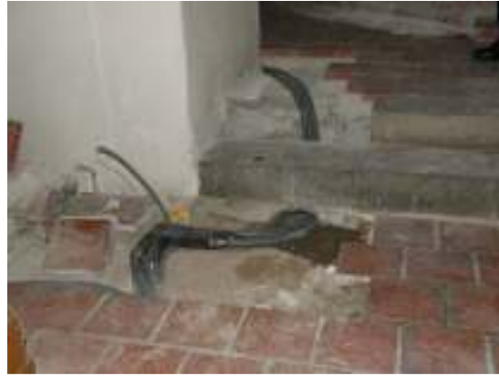
Rören dragna under korrtrappan.
