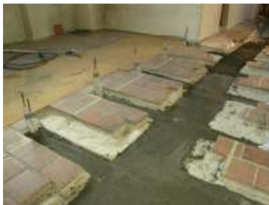
Återläggandet av huvudkulverten, gjutningen och rören till bänkvärmarna.
