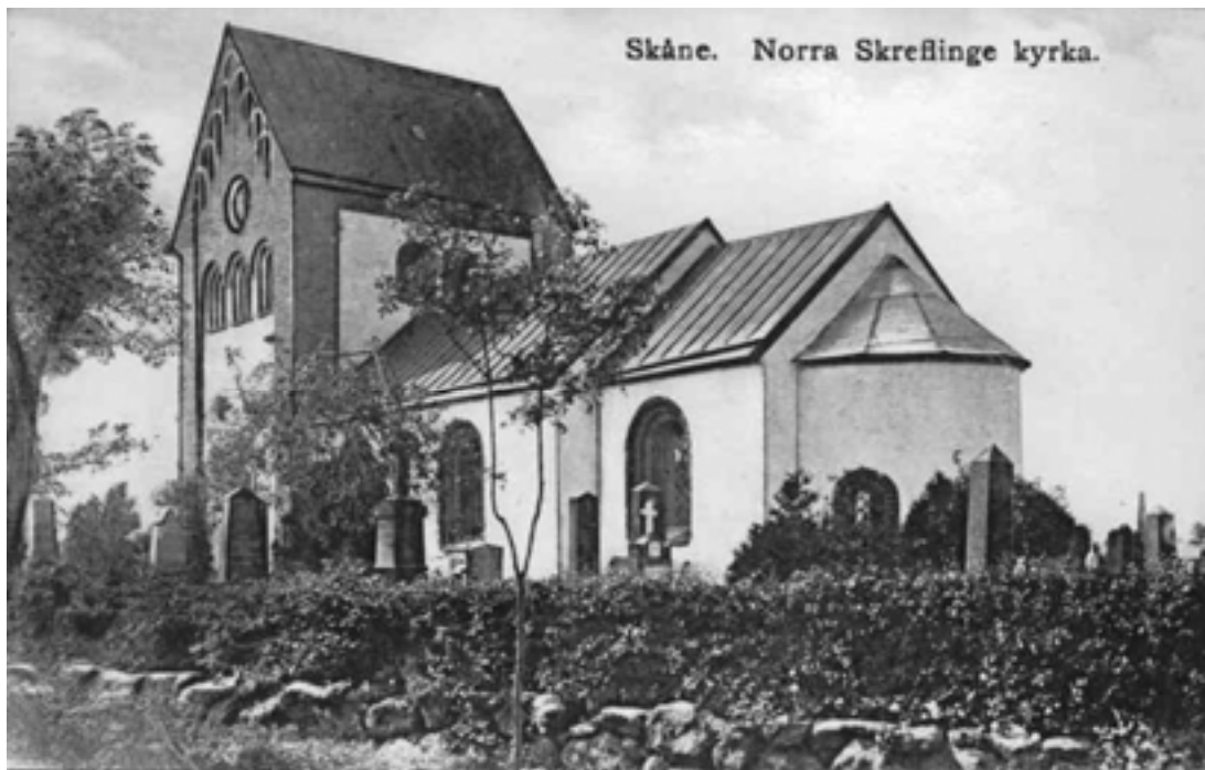
Fotografi av Norra Skrävlinge kyrka kring sekelskiftet 1900. Kulturmiljöbild, Riksantikvarieämbetet.
