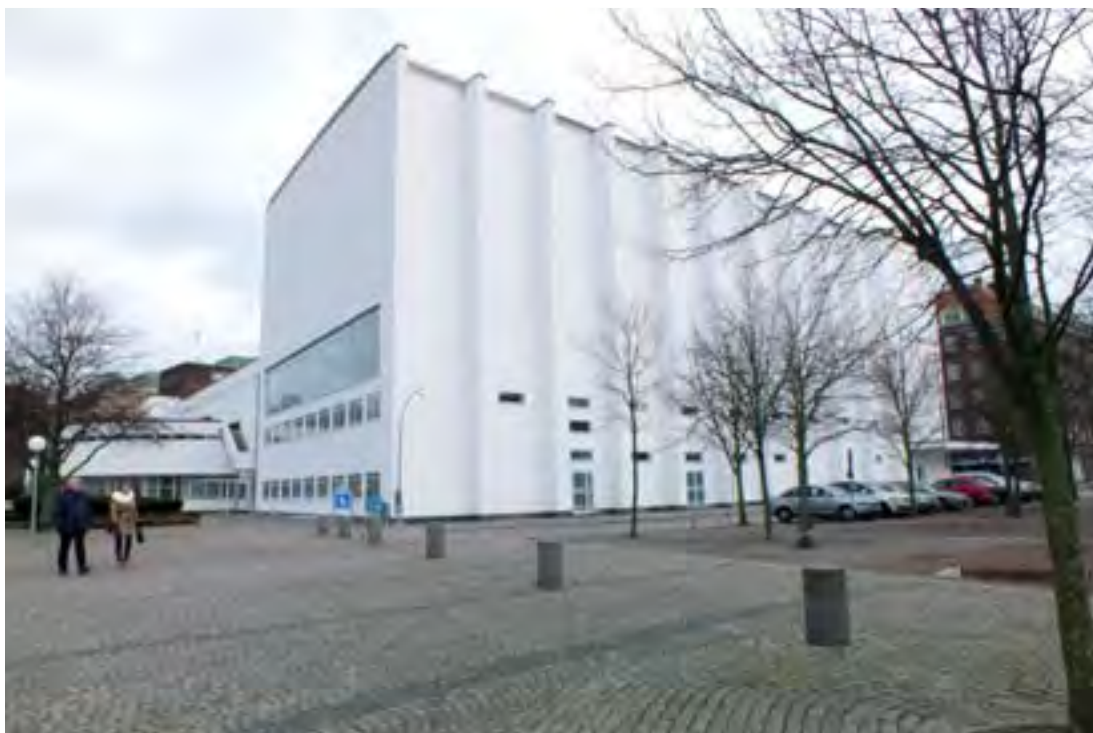
Västra fasaden efter renovering.
