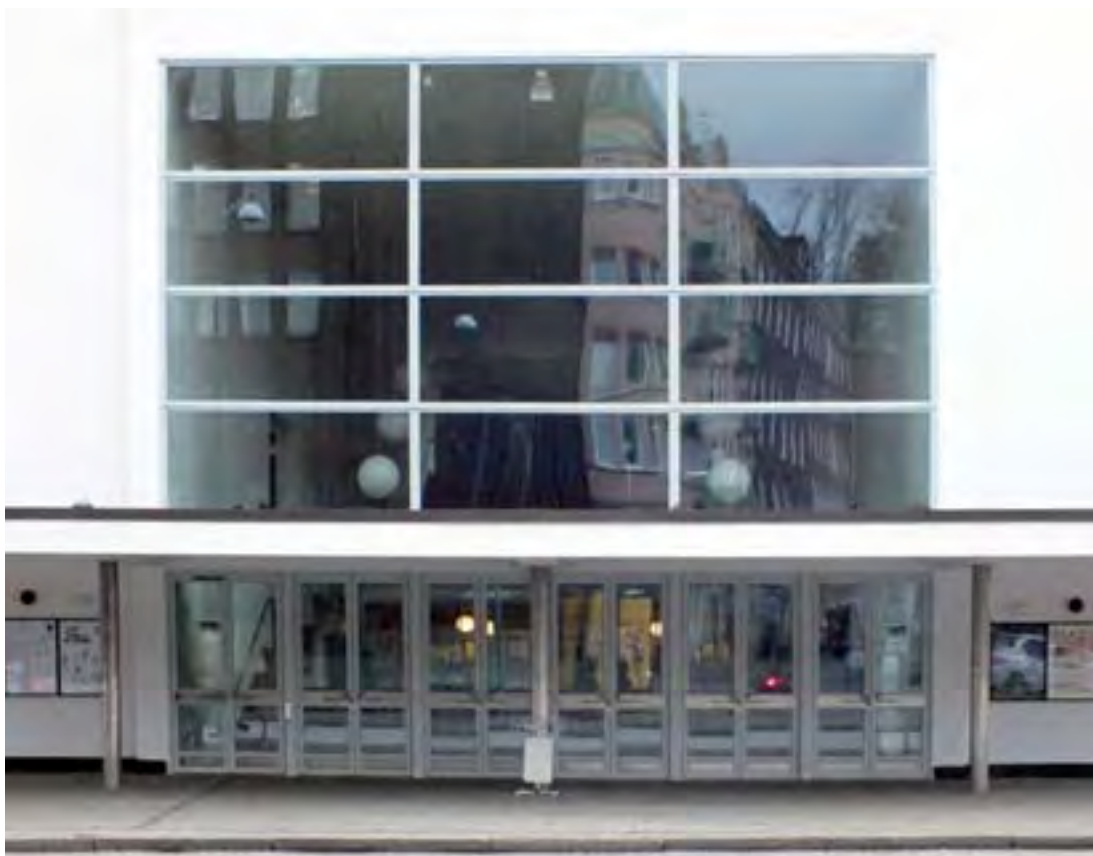
Stora fönsterpartiet ovan huvudentrén i sitt nya utförande som efterliknare det ursprungliga utförandet.
