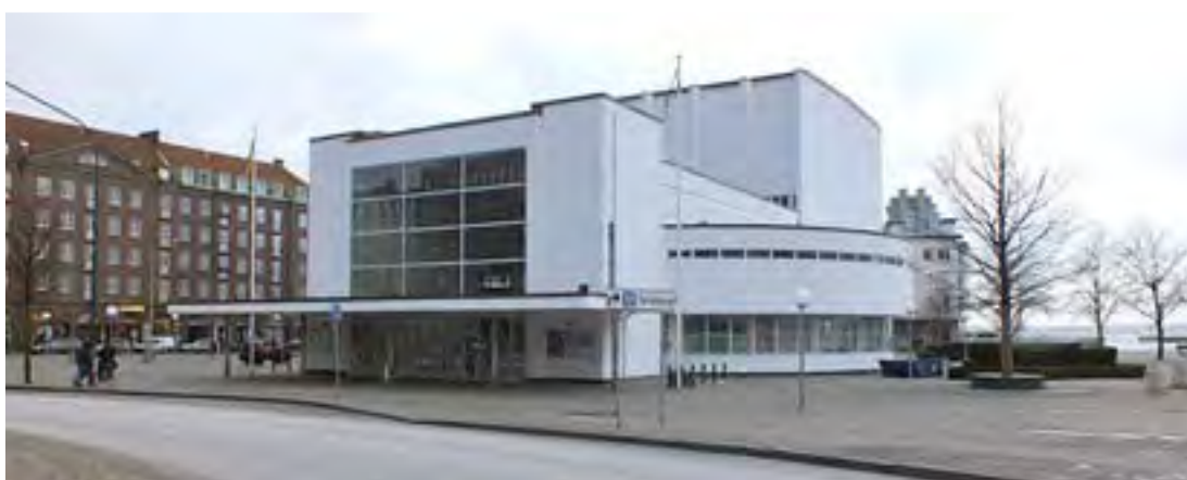
Vy från Hälsovägen med utsikt över Sundet mot det danska landet. Precis som Markelius önskade är numera konserthusets omgivningar "befriade" från "de fula och skrymmande magasinerna" (Nordabl 2007).
