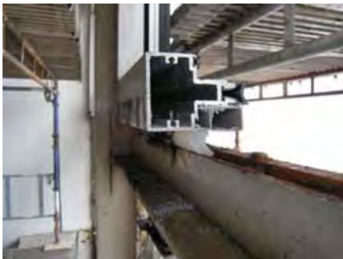
Till vänster: Profilen på åttitalets fönsterkassetter av aluminium. Till höger: I det ursprungliga stålpartiet satt glasrester kvar i glasningslisten.
