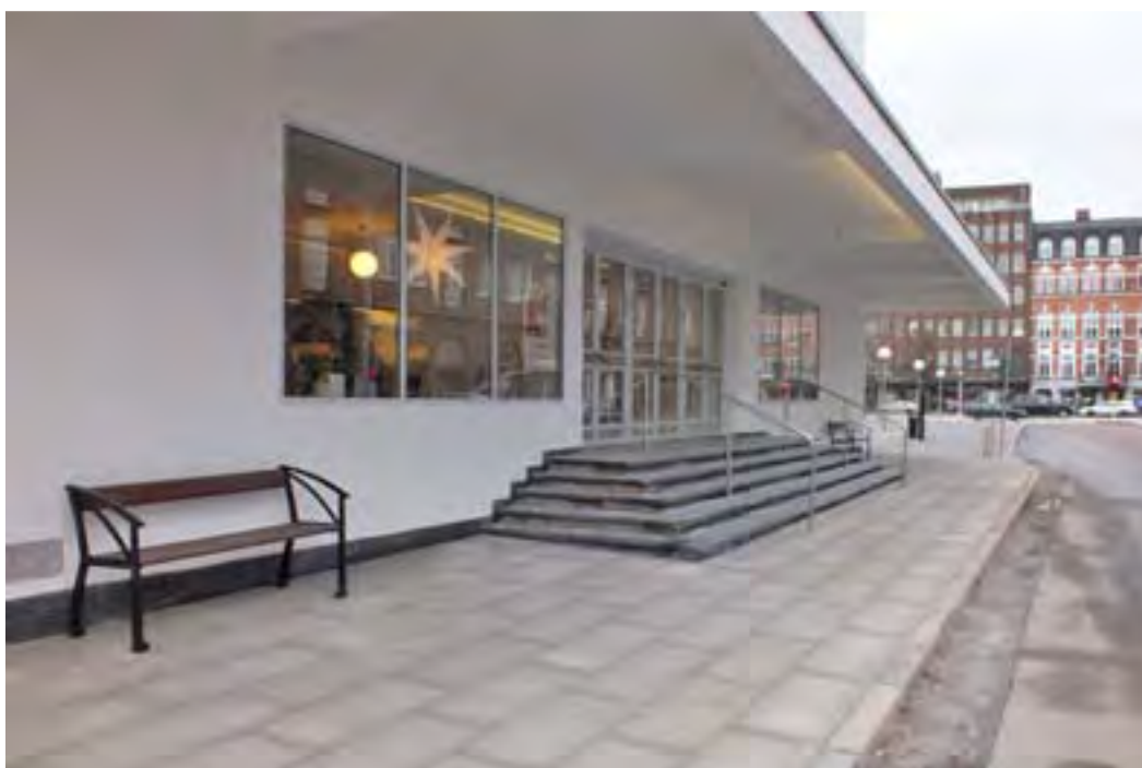
Skärmtaket byggdes upp likt befintligt efter rivning. Kanaler för elinstallationer byggdes in i konstruktionen.
