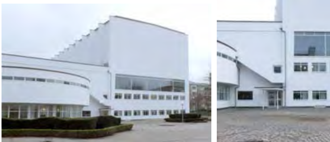
Fönsterpartiet på norra sidan har återfått ursprunglig fönsterindelning.
