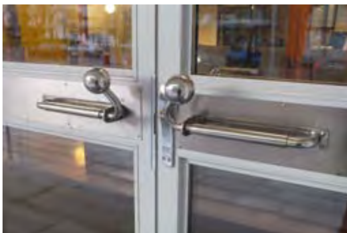
Dörrhandtag specialtillverkades efter ursprungliga ritningar.
