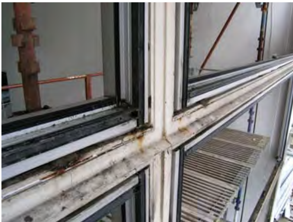
Åttitalets fönsterkassetter monterade inuti det ursprungliga stålpartiet. Skärmtaket vid södra entrén.
