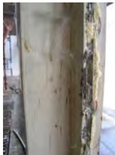
Till vänster: Profilen på åttitalets fönsterkassetter av aluminium. Till höger: I det ursprungliga stålpartiet satt glasrester kvar i glasningslisten.
