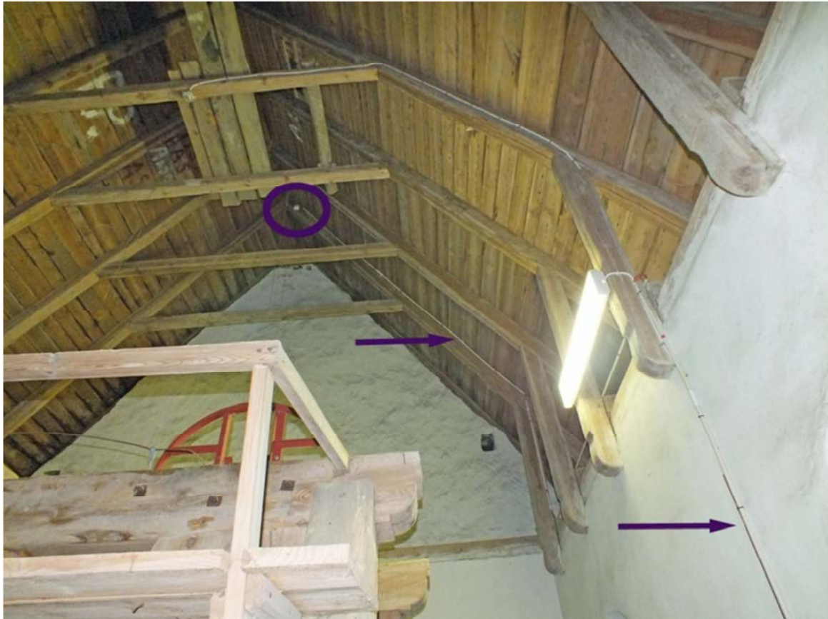
Övre tornvinden där ledningarna längs med muren har fästs i en befintlig elledning, se nedre pil. Den övre pilen visar dragningen utmed takstol där infästning gjorts med omkring en meters mellanrum. I nocken kan den hisssbara rökdetektorn ses.
