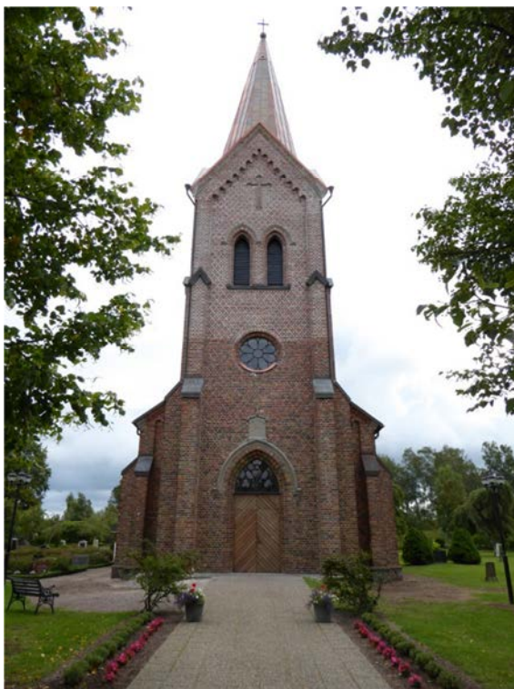
Taket och fogningsarbetet är färdigt. Här syns även de målade ljudluckorna.
