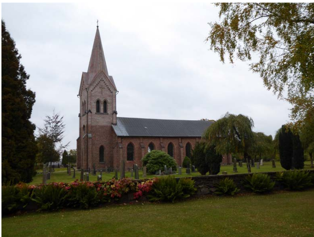
Det färdiga resultatet. Brytningen mellan tornets omfogade del och den icke åtgärdade delen är påtaglig, men kommer jämnas ut efter hand.
