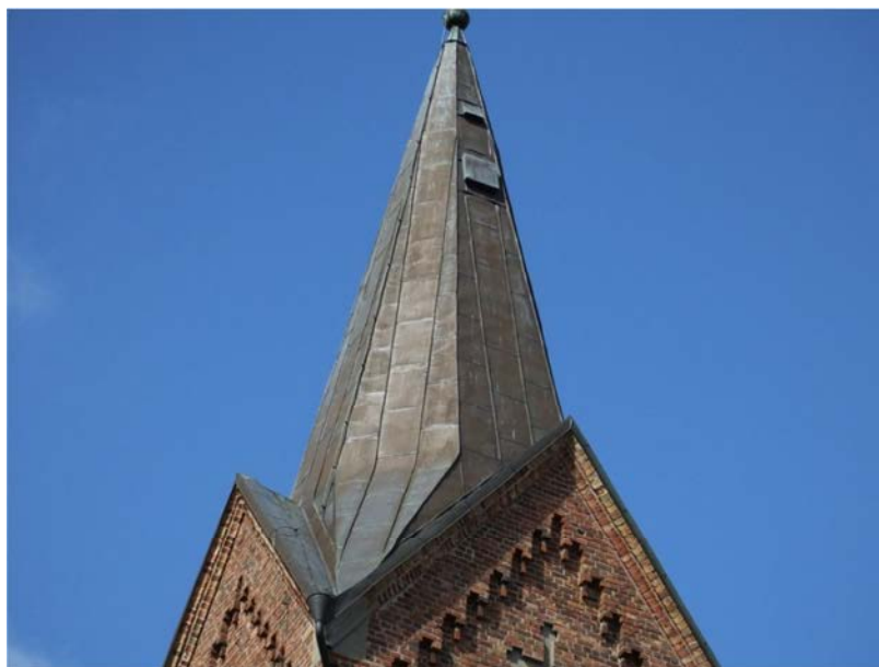
Taket innan omläggning.
