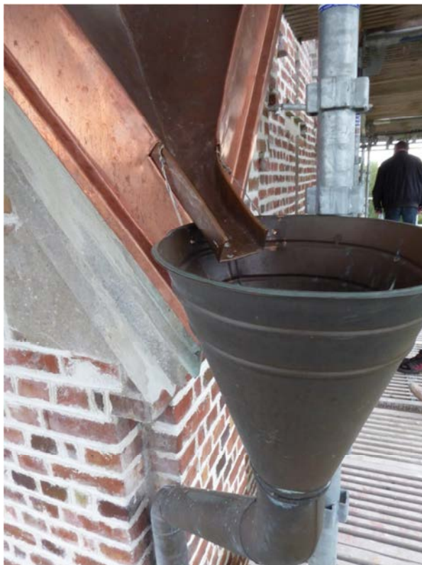
Anslutningen mellan det nylagda koppertaket och ett befintligt stuprör.
