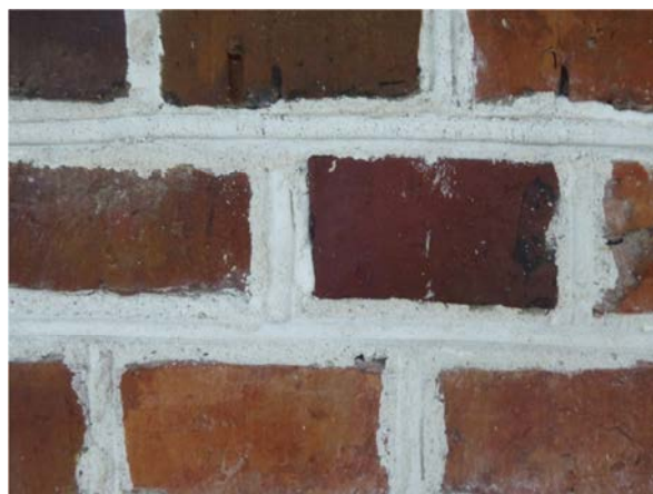
Teglet med tydliga åsfogar efter omfogning.
