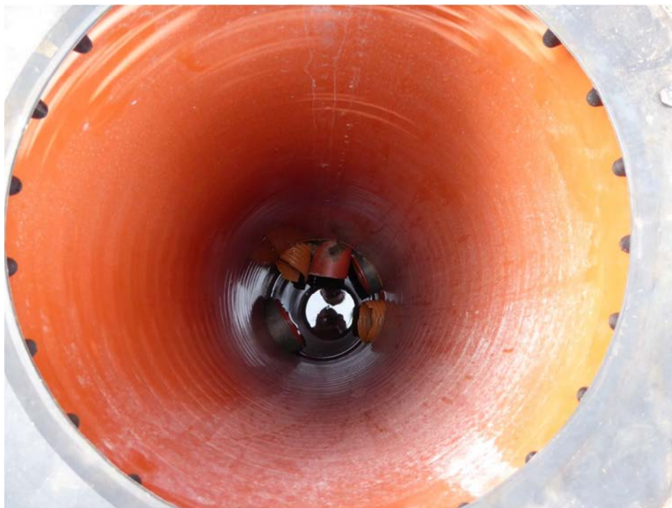
Brunnen där dräneringsrör och stuprör möts.
