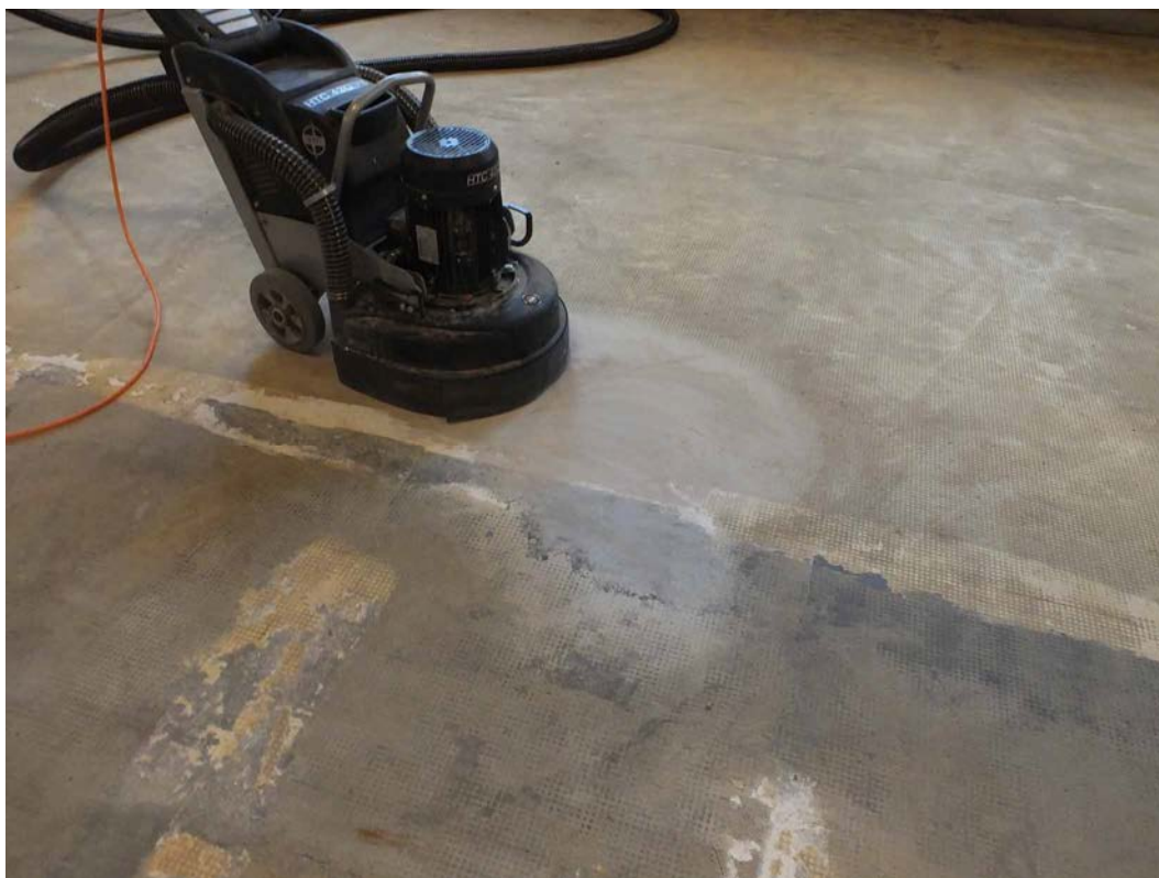
Golvet under pågående slipning.
