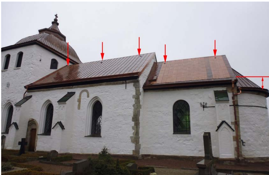
Fig. 1. Kyrkan efter arbetet. Pilarna markerar nya ventilstossar. Dubbelpilen och linjen vid absiden utvisar omfattningen av bytt underbrädning.
