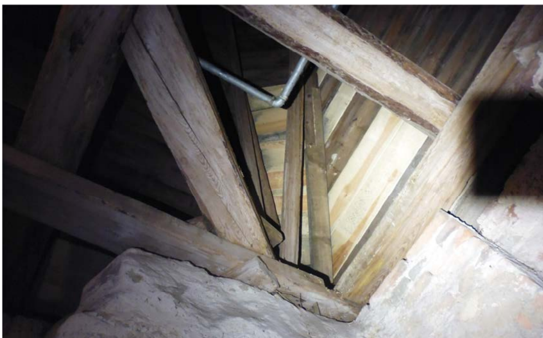
Fig. 2. Tornet, nordöstra vinkeln. Exempel på skarvad gradsparre och bytt underbrädning.
