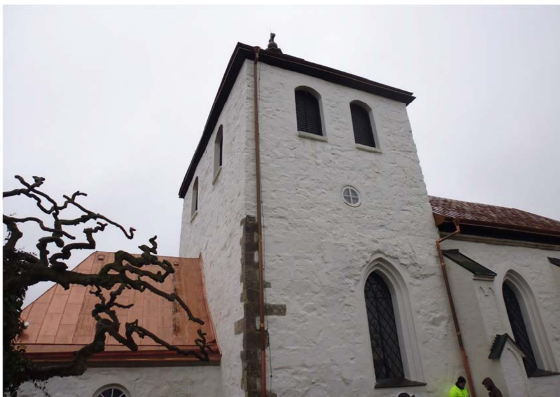
Fig. 5. Del av vapenhuset, tornet och långhuset efter arbetet. Notera det nytillverkade, runda fönstret.
