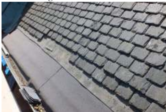
Nedblockning av skiffer inför plåtarbeten, det monterades ny papp innan skifferet återsattes.
