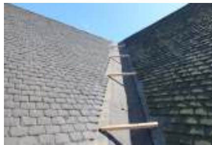
Bilden t.v visar vinkelrännan innan med bla. droppskador. Bilden t.h visar taket när vinkelrännan tagits bort i sin helhet.
