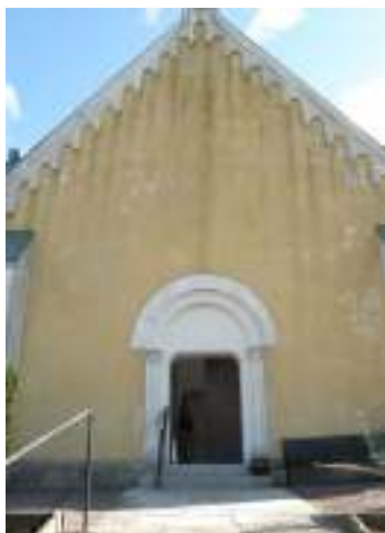
Kyrkans fasad var i behov av underhåll då fasaden var smutsig, färgen flagnade och det fanns sprickor samt algpåväxt. Det fanns även behov för underhåll av tak och avvattningssystemet.
