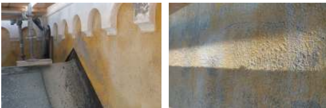
Bilder från arbete med att ta bort lös sprit- och slätputs på kyrkans fasad.
