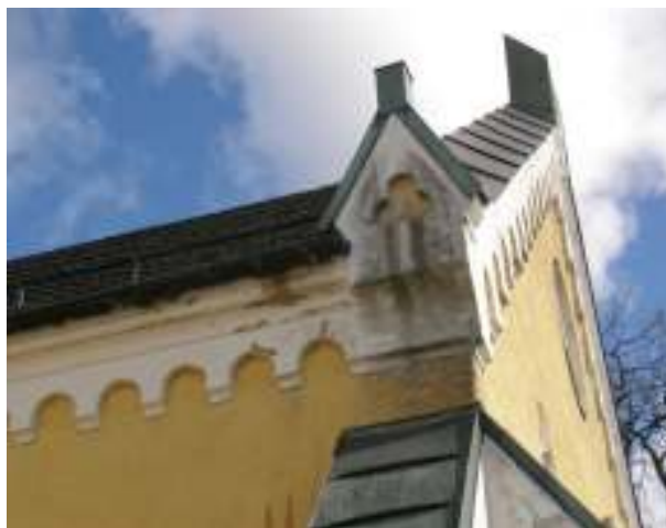
Kyrkans fasad var i behov av underhåll då fasaden var smutsig, färgen flagnade och det fanns sprickor samt algpåväxt. Det fanns även behov för underhåll av tak och avvattningssystemet.
