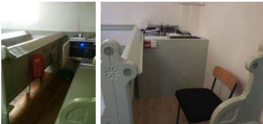
Bilden t.v visar vaktmästarplatsen innan renoveringen. Bilden t.h är platsen efter renoveringen med ny installation för ljudanläggning och med bortagen bänk.
