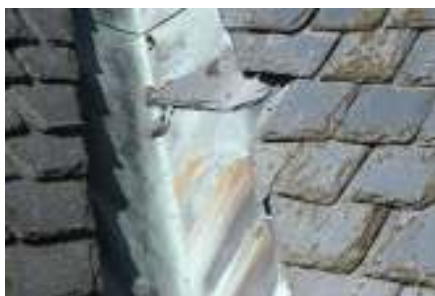
Bilden t.v visar vinkelrännan innan med bla. droppskador. Bilden t.h visar taket när vinkelrännan tagits bort i sin helhet.
