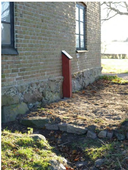
Ledningarna från vävkammaren drogs ut genom fasaden och doldes av en trälåda som anvärgades i röd slamsfärg och avtäcktes med pappklätt lock. Installationen grävdes ner i ett schakt norr om grishuset där utomhusdelen placerades invid den östra gaveln. Vid markarbetena passade man på att justera marknivån och gräva ut vid avloppsledningen från köket (bild t.h.).
