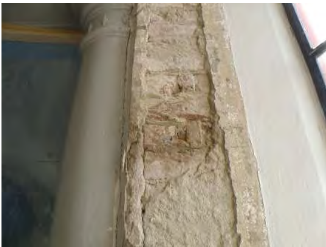
Återvänt tegel med färgspår i södra fönstervelvet.
