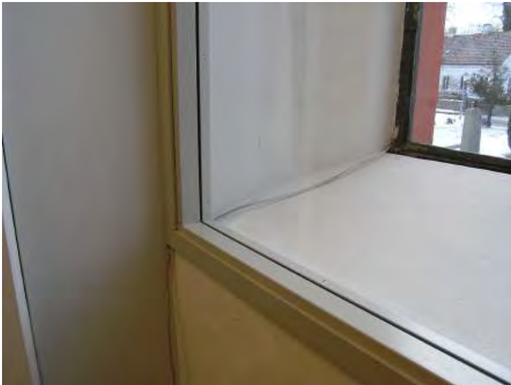
Detalj av fönster med innerglas monterat.
