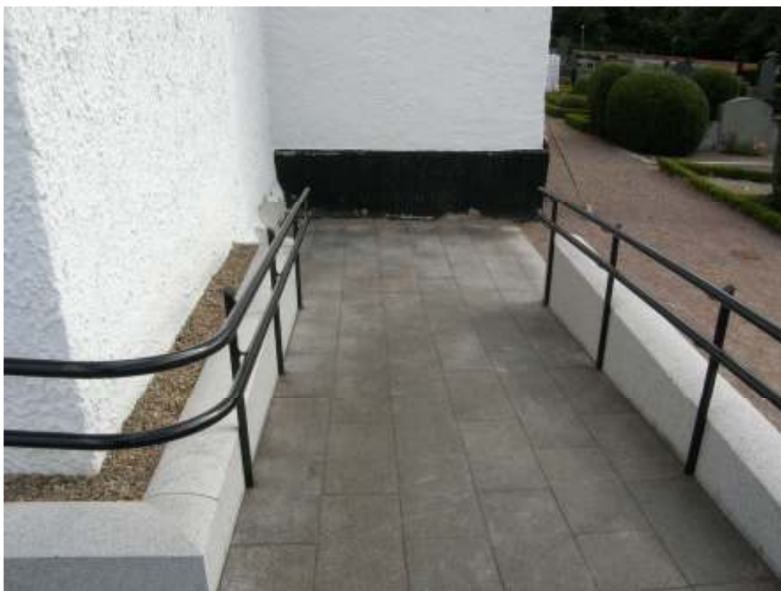
Rampen mot öster. Räckten utfördes med handikappvänliga dimensioner i två nivåer på båda sidor om rampen.
