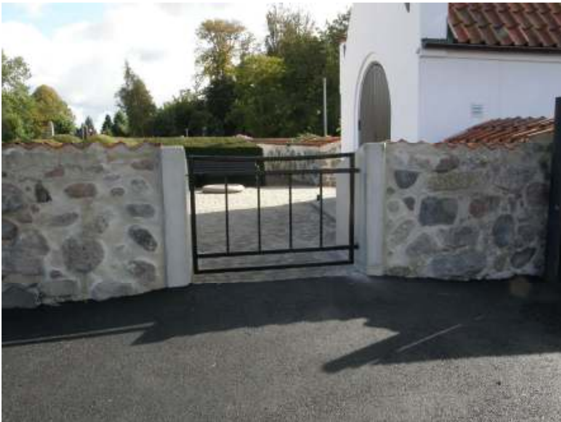
Ny handikappanpassad ingång vid Bårhuset med nytt grindparti.
