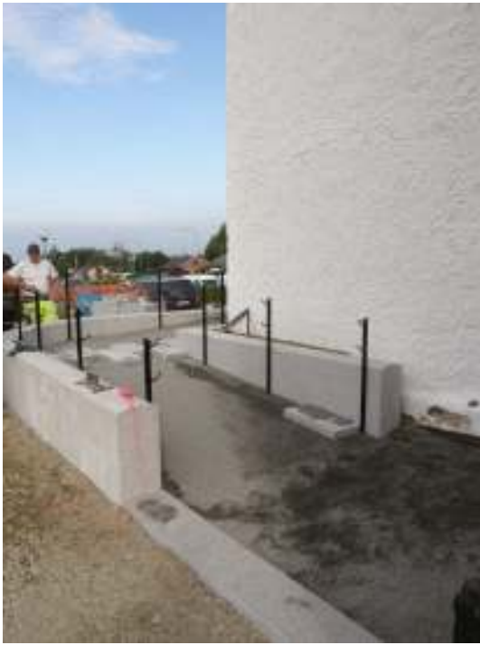
Rampen under uppförande. Sett från sydost.
