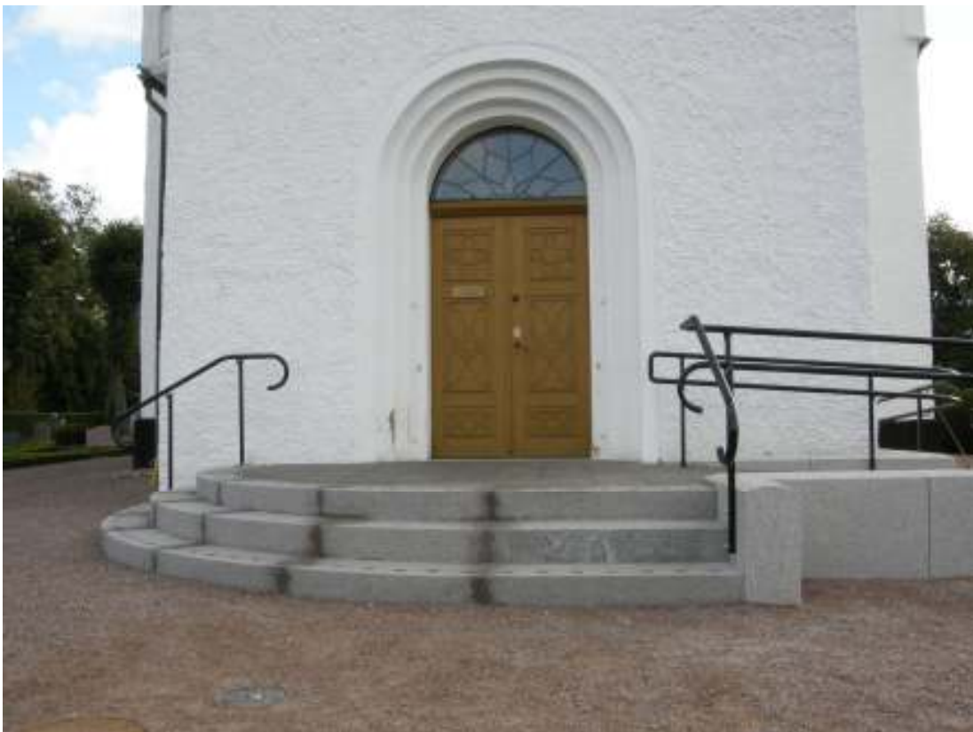
Färdig ramp sedd från väster. De mörkfärgade fogarna var nygjorda då bilden togs och kommer att ljusna.
