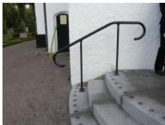
Detalj av rampens sidomur t.v. Till höger syns räckets montering till trappstegen på norra sidan om entrén.
