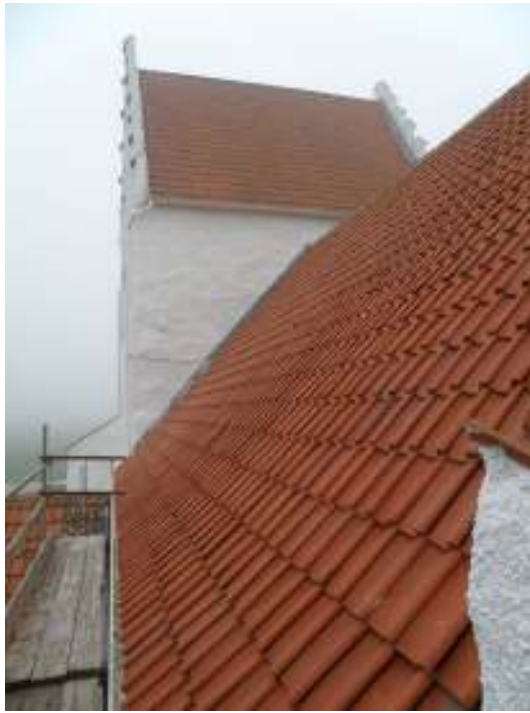
Långbustaket respektive kortaket efter utförd renovering.
