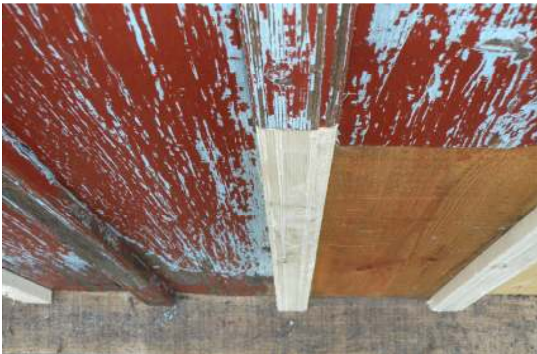
Detalj av bytt locklistpanel. Notera de handhyvlade profilerna.
