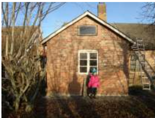
Samma fasad efter arbetet.
