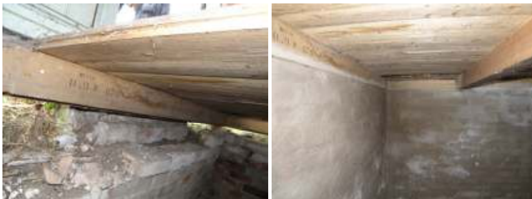
Källarmuren innan arbetet.
