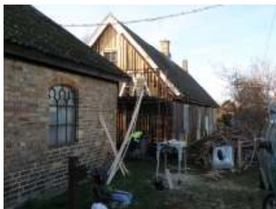
Vy mot östra fasaden och södra gaveln.
