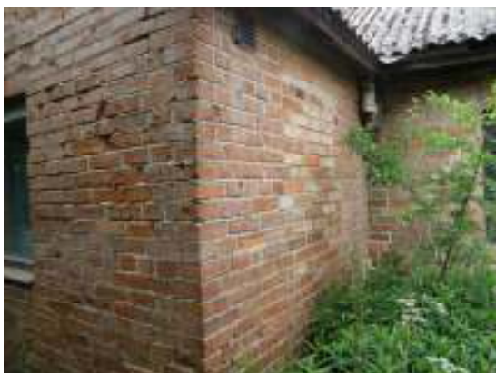
Platsen för det igensatta fönstret.
