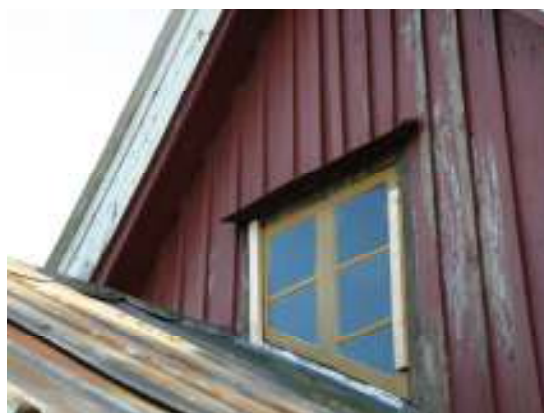
Fönstret på norra gavelröstet (utan foder)
