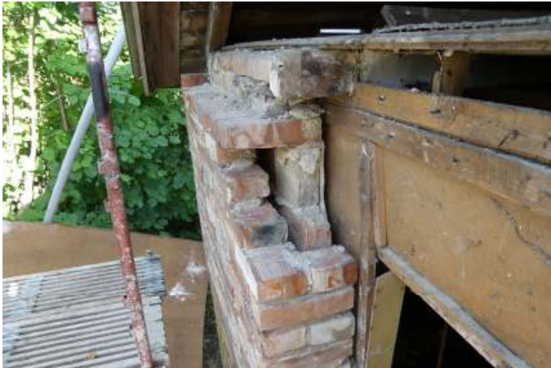
Smedkammaren. Västra gaveln under uppförandet. Notera den "tomma" skalmuren.
