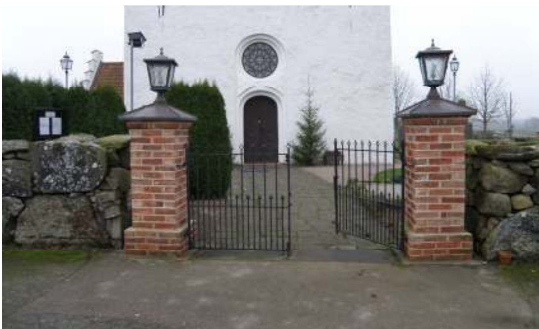
Fig. 2. Västra grindpartiet efter arbetet.
