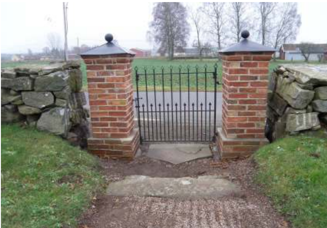
Fig. 8. Det östra grindpartiet.
