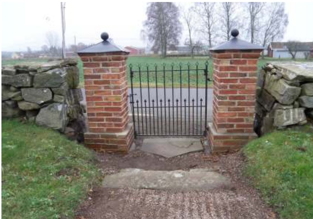
Fig. 8. Det östra grindpartiet.
