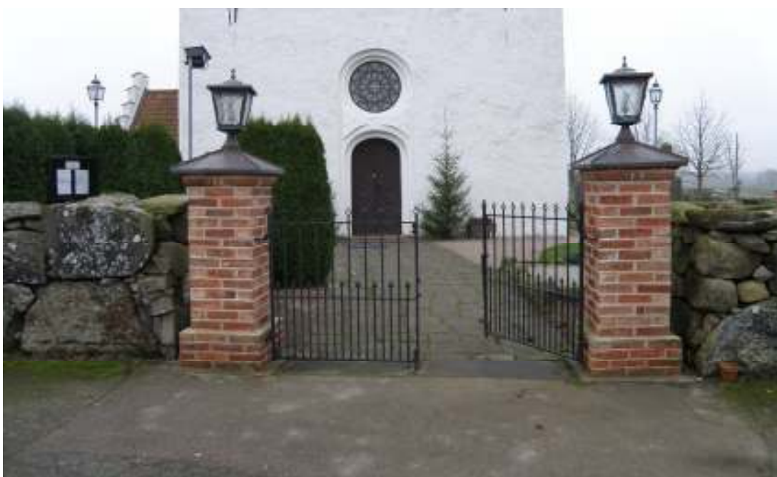
Fig. 2. Västra grindpartiet efter arbetet.
