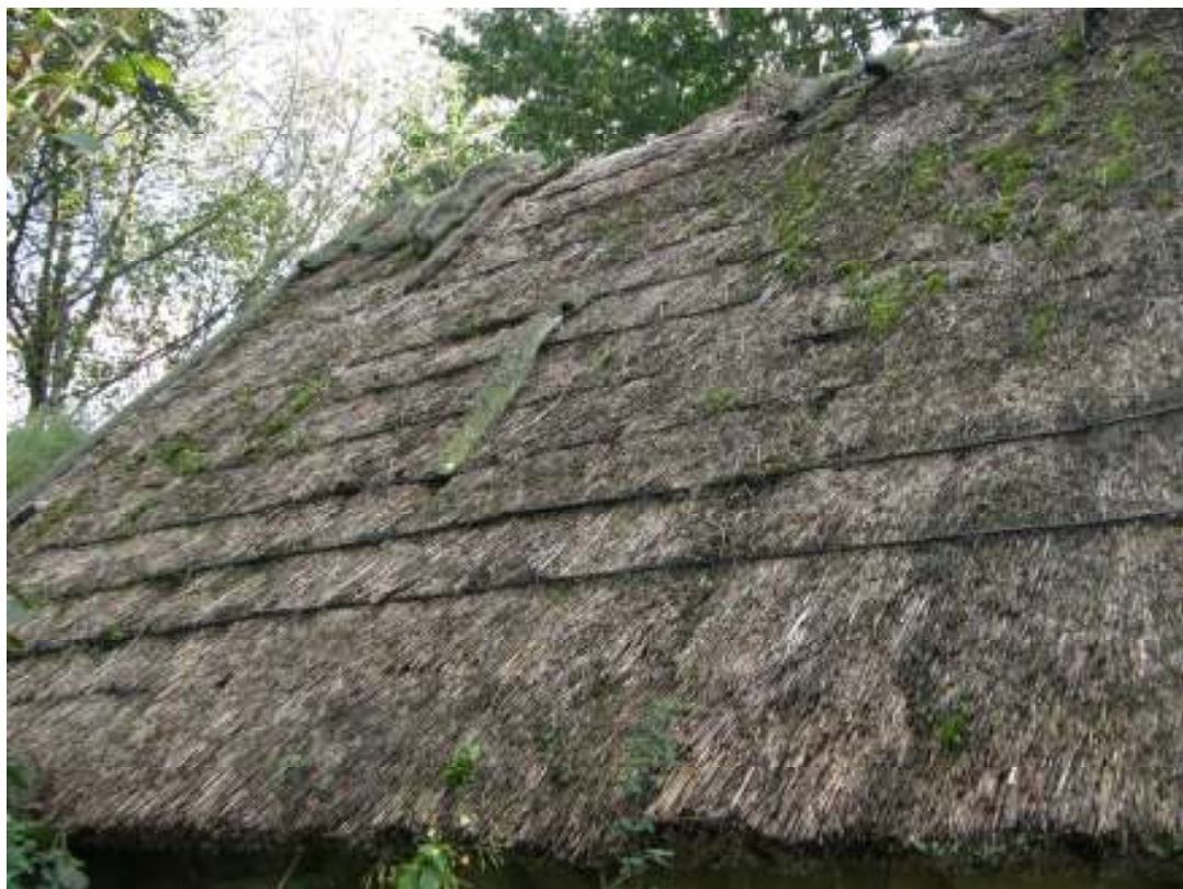
Taket innan lagningen. Notera avsaknaden av ryggning.
