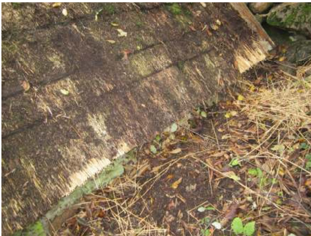
Lagningarna i vasstaket. Foto: Knadriks kulturbygg.
