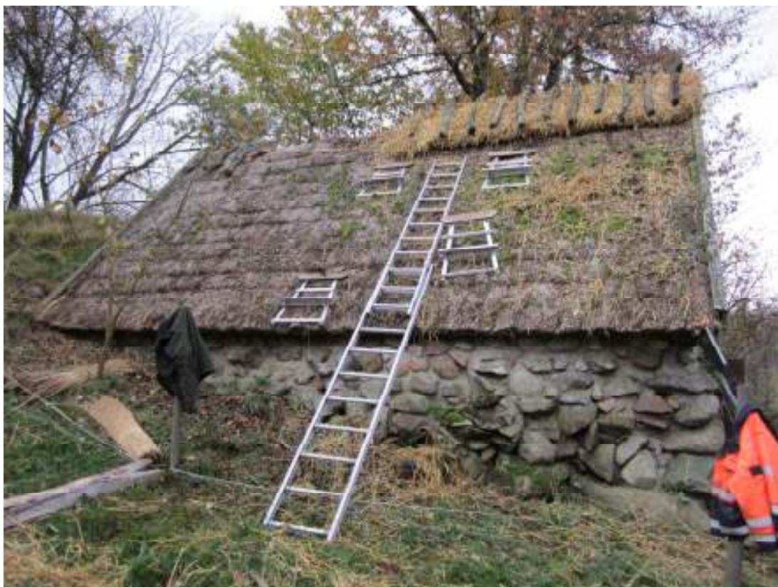
Brydestuan under arbetet. Notera även stenmurarna. Foto: Knadriks kulturbygg.
