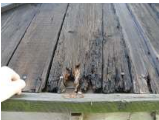
Fig. 11. Exempel på rötskada. Östra längan.
