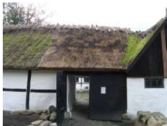
Fig. 2. Norra längan, norra takfallet.
