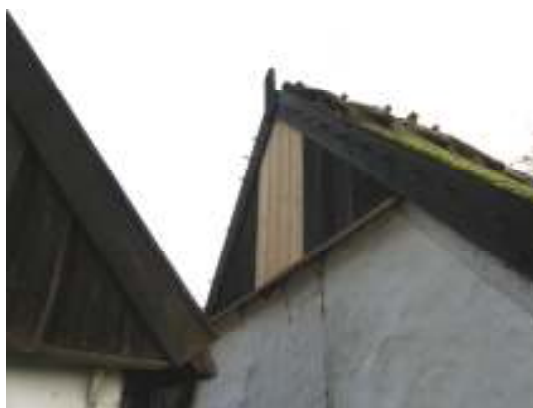
Fig. 11. Exempel på rötskada. Östra längan.
