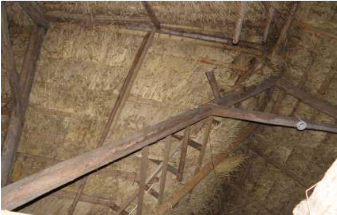
Fig. 3. Rännaldalen mellan norra och östra längan. Notera de nya läktbitarna i vinkeln.
