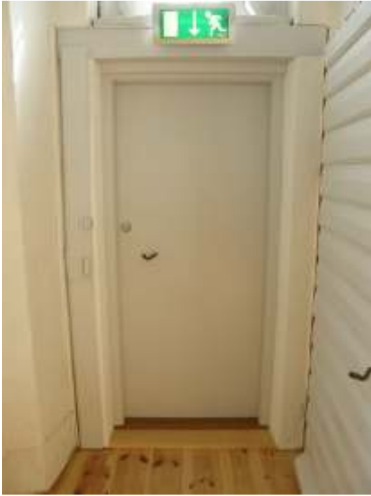
Ny ytterdörr efter renovering.
