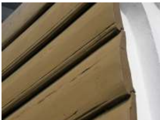
Till vänster syns den gamla dörrens brädprofil och till höger nya dörren som utfördes som en modern isolerad skivklädd dörr med utvändigt traditionell brädtäckning.
