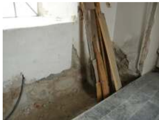
Gamla trappan från vapenhuset till tornvåningen. Vapenhusets södra sida efter borttagning av gammalt golv och golvfyllning.
