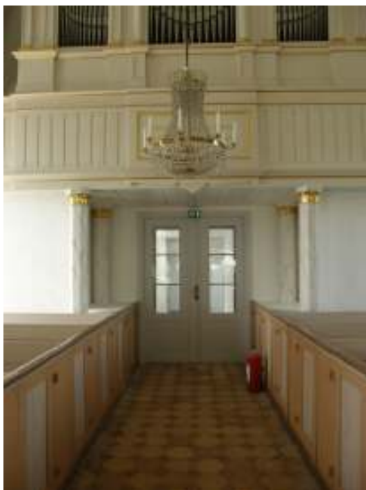
Nytt dörrparti förlades något indraget i en ny skiljevägg mot vapenhuset. Sett från öster.
