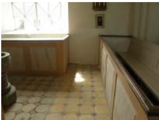
Klockarbänken fick kompletteras med nytt sidostycke. Till höger syns korgolvet före omläggning.
