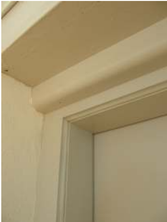
Karmens profilering ändrades från rundstav till karnisform. Till höger: Funktionen återställdes på en av luftventiler över östra dörren.
