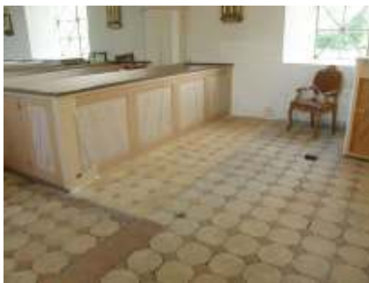
Till vänster syns uppgången till koret från mittgången, före omläggning av golvet. Till höger syns golvet efter omläggning med komplettering av nytt golv där den gamla bänken stod.
