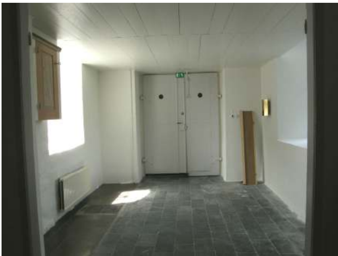
Vapenhuset sett från öster efter renoveringen.
