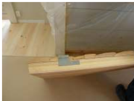
Till vänster syns den gamla dörrens brädprofil och till höger nya dörren som utfördes som en modern isolerad skivklädd dörr med utvändigt traditionell brädtäckning.
