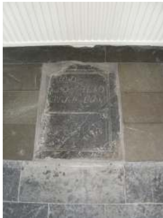
Äldre borttagna hällar och tegelsten som låg under trappan i vapenhuset. En av gravstenarna fogades in i det nya golvet i vapenhuset.
