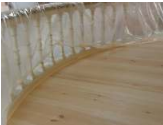
Korgolvet lades om med nya kilsågade furubrädor. Till höger syns golvet efter omläggning.
