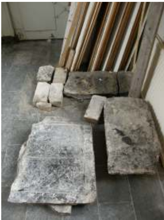
Äldre borttagna hällar och tegelsten som låg under trappan i vapenhuset. En av gravstenarna fogades in i det nya golvet i vapenhuset.
