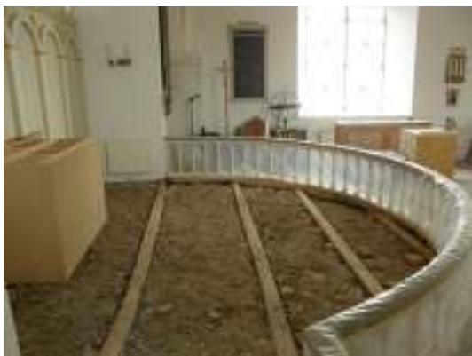
Korgolvet lades om med nya kilsågade furubrädor. Till höger syns golvet efter omläggning.
