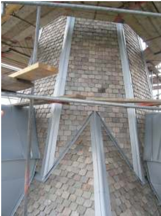
Taktäckningen efter renovering. Nockplåtar och takerännor är tillverkade av patinerad plåt av fabrikat Rheinzink. Längst upp på spiran, vid mötet mellan de nya nockplåtarna och spirans kröning med klot och kors, behövs en blyplåt. Understycket till klotet samt klotet målades om i samband med takrenoveringen.
