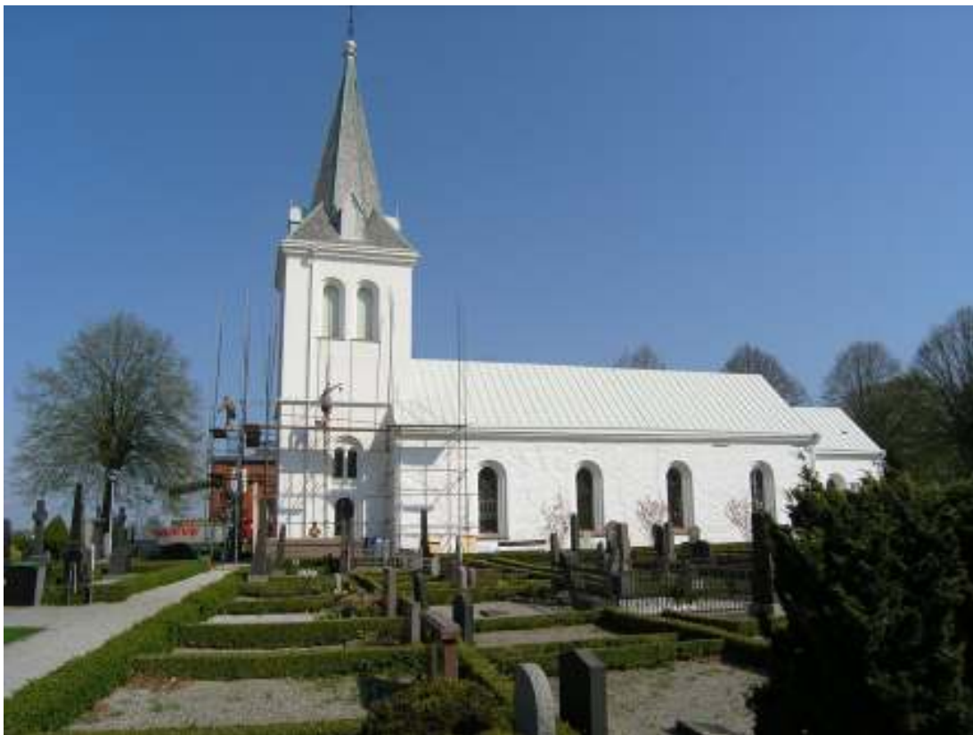
Lackalänga kyrka, ställningsbygget inför renoveringen av tornspirans tak.
