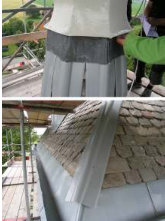
Taktäckningen efter renovering. Nockplåtar och takerännor är tillverkade av patinerad plåt av fabrikat Rheinzink. Längst upp på spiran, vid mötet mellan de nya nockplåtarna och spirans kröning med klot och kors, behövs en blyplåt. Understycket till klotet samt klotet målades om i samband med takrenoveringen.
