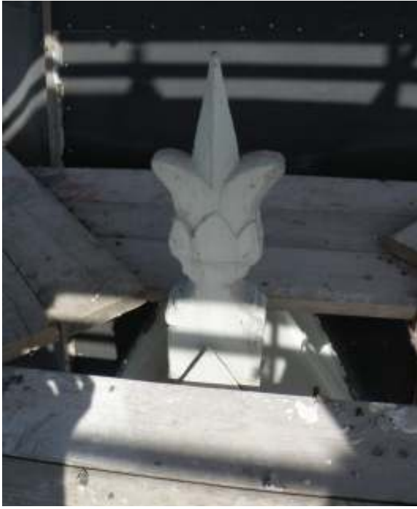
Kröningarna på takkuporna gjordes nya för att få samma material som kuporna i övrigt (patinerad plåt). Bild före och efter.
