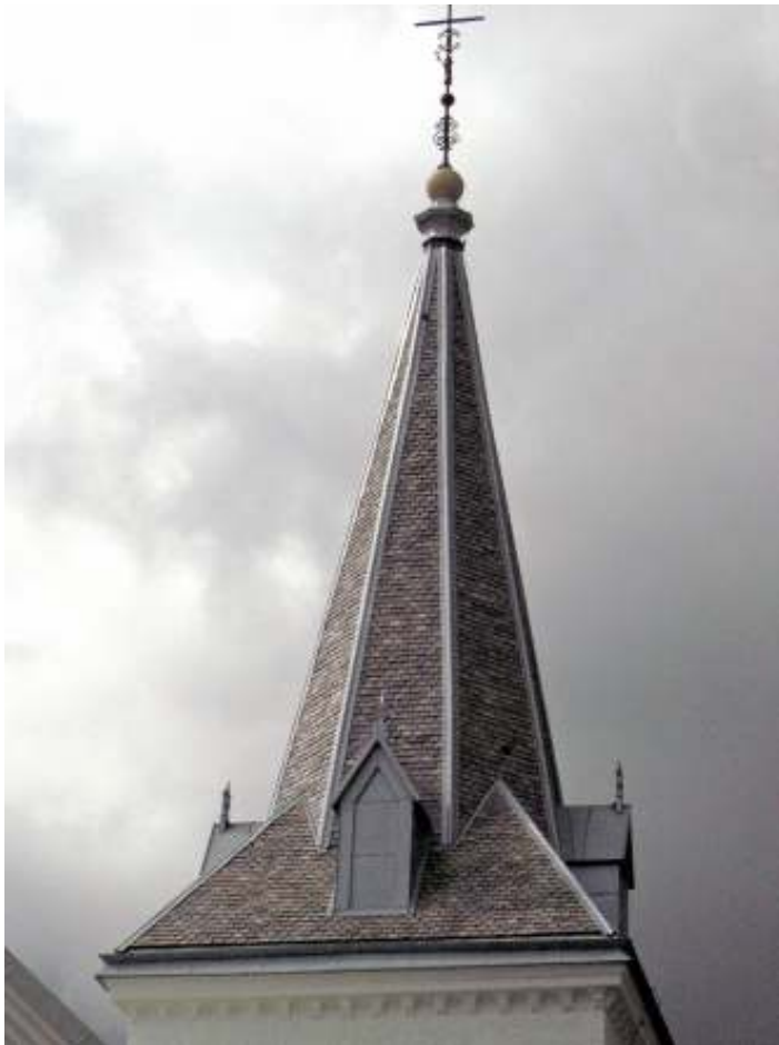
Taktäckningen efter renovering. Nockplåtar och takerännor är tillverkade av patinerad plåt av fabrikat Rheinzink. Längst upp på spiran, vid mötet mellan de nya nockplåtarna och spirans kröning med klot och kors, behövs en blyplåt. Understycket till klotet samt klotet målades om i samband med takrenoveringen.
