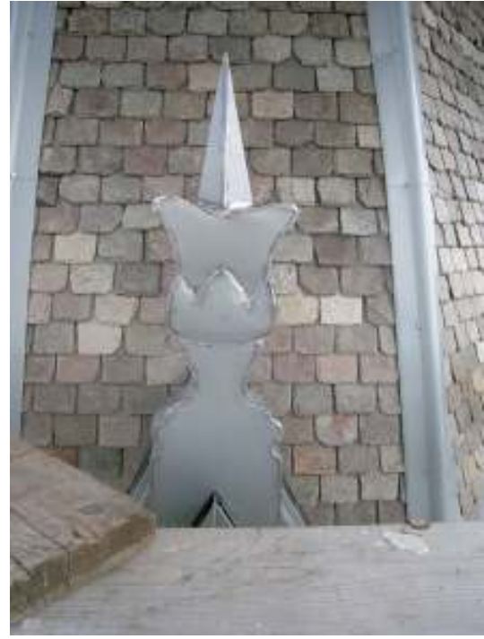
Kröningarna på takkuporna gjordes nya för att få samma material som kuporna i övrigt (patinerad plåt). Bild före och efter.
