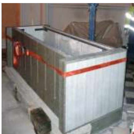
Demonteringen har påbörjats. Locket som ligger löst lyfts av och därefter tas skivorna på sidorna bort.
