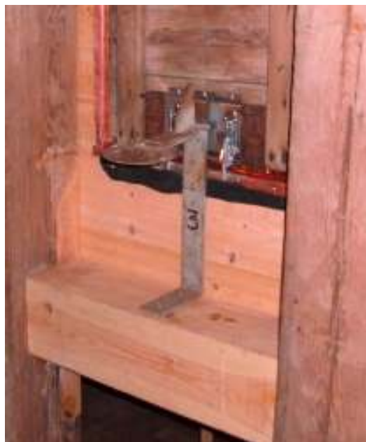
Foto 11 och 12. Klammer och falsspår från ursprunglig koppartäckning på lanternin och ett av de mystiska stativen i underkant av de större lanterninluckorna.
