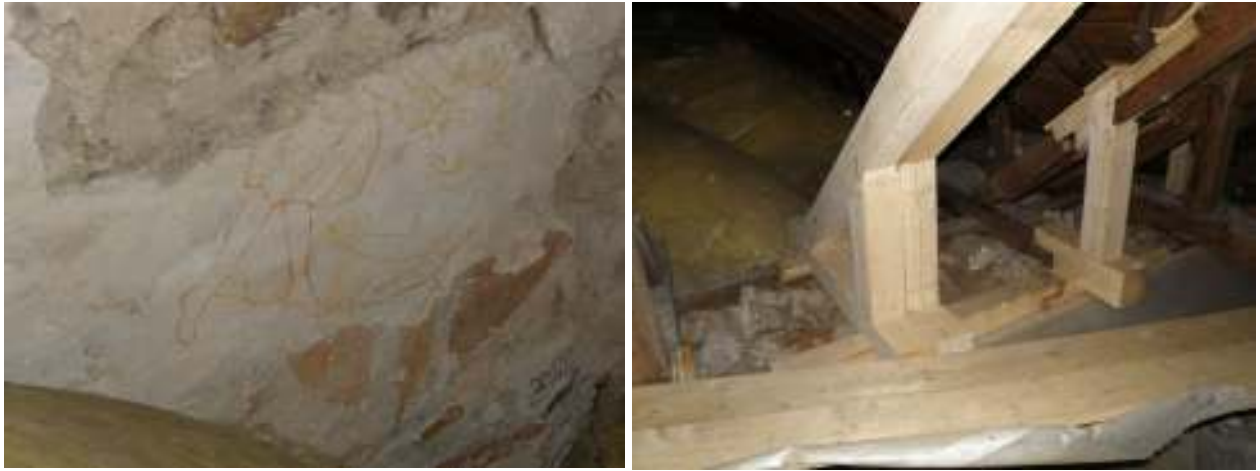
Foto 7 och 8. Kalkmålningar över långhusets valv och nylagade takstolar mot norra korsarmen.
