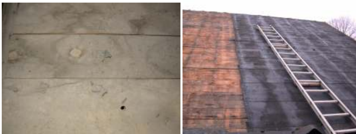
Foto 13 och 14. Ursprungliga kopparklammer på långhustak respektive masonitpapp på södra korsarmens tak.
