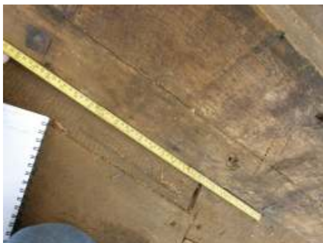
Foto 11 och 12. Klammer och falsspår från ursprunglig koppartäckning på lanternin och ett av de mystiska stativen i underkant av de större lanterninluckorna.
