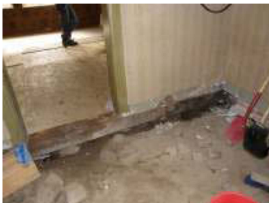
Golven borttagna och väggbolstret bytt.
