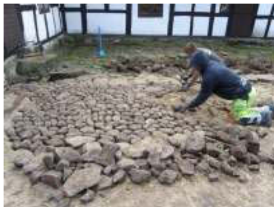
Omläggning av kullerstenen.
