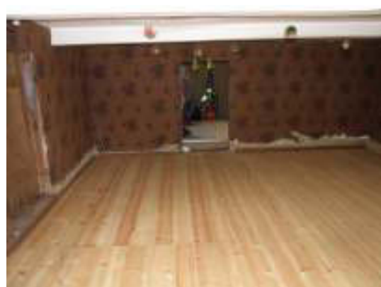
Nytt golv i huset.
