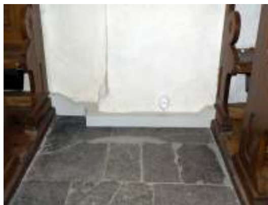
Golvsocklar eller kabellådor tillverkades för elen inne i kyrkorummet. Då väggarna var ojämna fick alla ovanbitarna formas efter väggarna.
