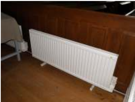
Ny radiator i norra korsarmen monterad på golvstativ. Till höger syns en radiator på orgelläktaren. I aluminiumlådan på bilden löper eldragningen från tornet.
