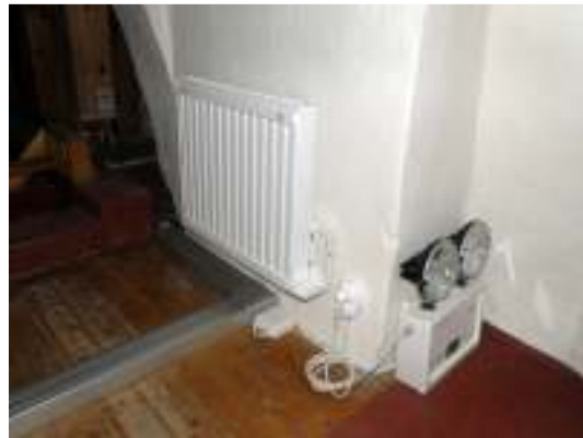
Ny radiator i norra korsarmen monterad på golvstativ. Till höger syns en radiator på orgelläktaren. I aluminiumlådan på bilden löper eldragningen från tornet.
