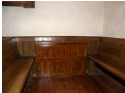
Ny radiator i norra korsarmen monterad på golvstativ. Till höger syns en radiator på orgelläktaren. I aluminiumlådan på bilden löper eldragningen från tornet.
