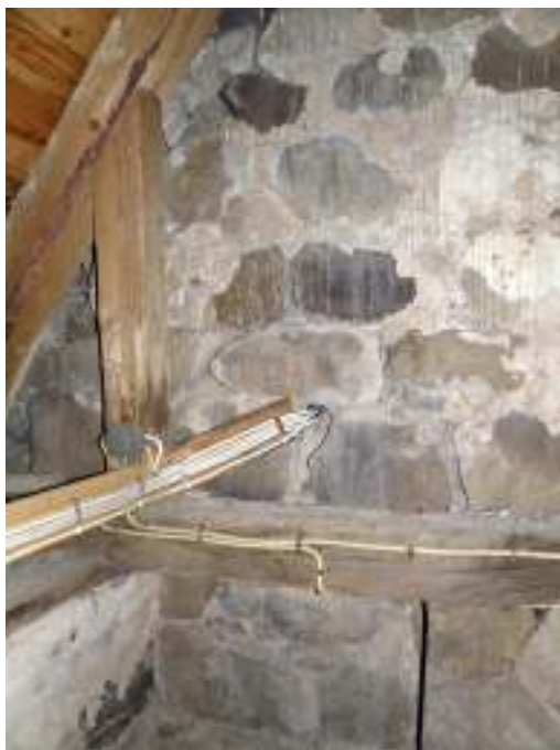
Dragning av el från tornets andra våning till kyrkvinden. Till höger syns eldragning till tornets andra våning.
