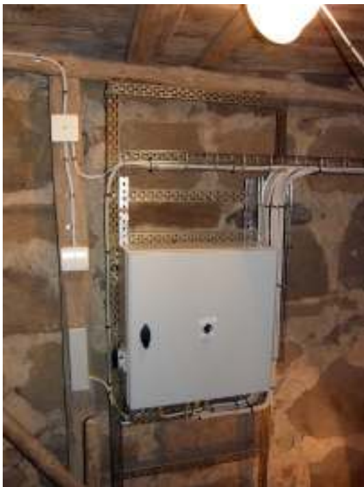
Klockringningens elcentral samt installationer på klockvåningen för lucköppning och klockringning.
