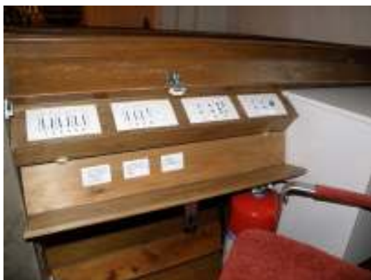
Ljus, klockor ljudanläggning regleras från en panel under läktaren. Ett lock tillverkades till denna. Till höger syns klockringingcentralen med placering under läktaren. En skåpslucka tillverkades till denna.
