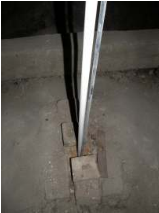
Ledningsdragning till ljuskronornas hissar drogs i befintliga hål. Till höger syns elcentral på vinden.
