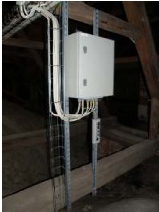
Ledningsdragning till ljuskronornas hissar drogs i befintliga hål. Till höger syns elcentral på vinden.
