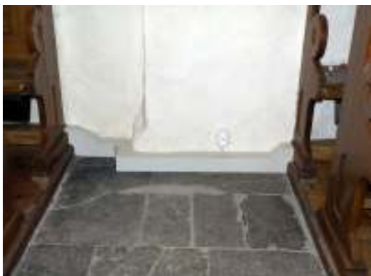
Elkablarna lades i träsocklar eller kabelldådor längs väggarna. I bänkquarteren laserades träet i ekfärg medan övriga socklar i koret och i vapenhuset målades grå.
