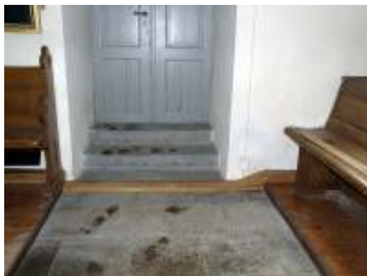
Elkablarna lades i träsocklar eller kabelldådor längs väggarna. I bänkquarteren laserades träet i ekfärg medan övriga socklar i koret och i vapenhuset målades grå.
