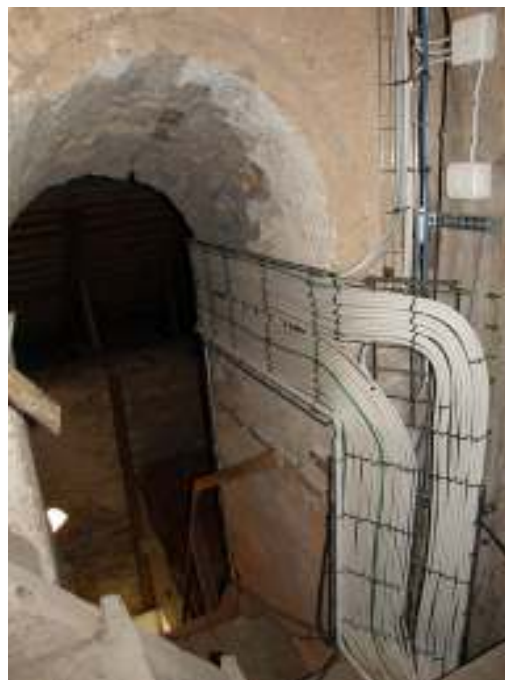
Dragning av el från tornets andra våning till kyrkvinden. Till höger syns eldragning till tornets andra våning.
