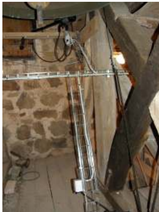
Klockringningens elcentral samt installationer på klockvåningen för lucköppning och klockringning.
