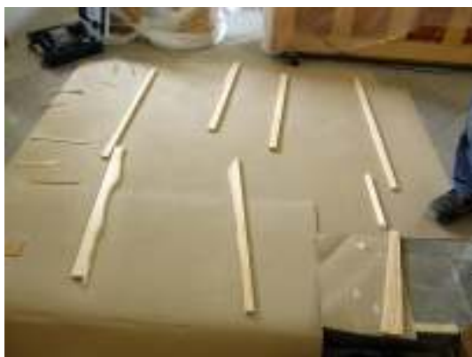
Golvsocklar eller kabellådor tillverkades för elen inne i kyrkorummet. Då väggarna var ojämna fick alla ovanbitarna formas efter väggarna.
