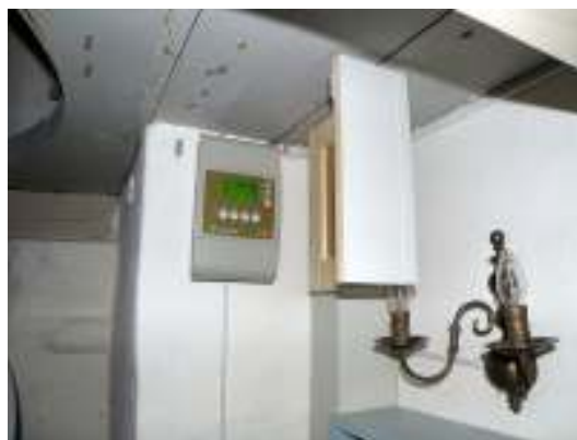
Ljus, klockor ljudanläggning regleras från en panel under läktaren. Ett lock tillverkades till denna. Till höger syns klockringingcentralen med placering under läktaren. En skåpslucka tillverkades till denna.
