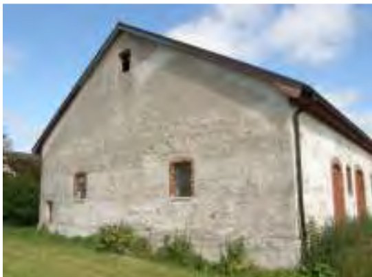
Den södra gaveln innan åtgärderna.
