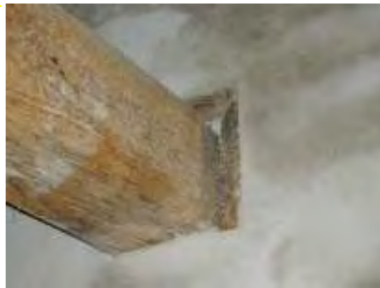
Bindbjälkens uttag i väggen.
