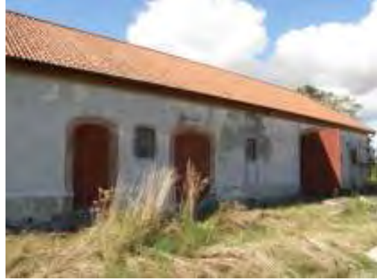
Samma fasad under åtgärderna.
