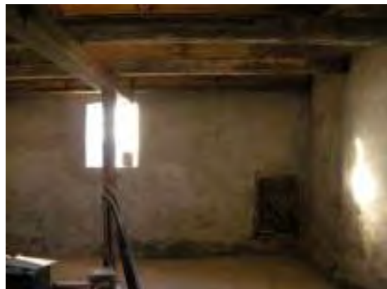
... och efter åtgärderna.
