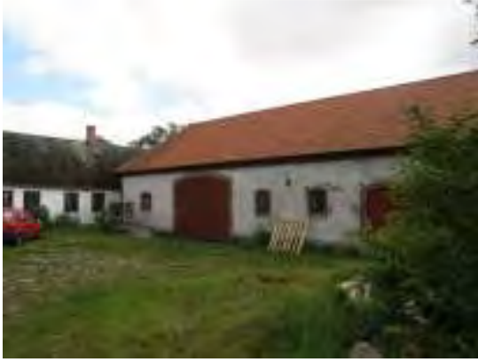
Ekonomibyggnaden från innergården före åtgärder- na, med skymten av bostadslängan till vänster.
