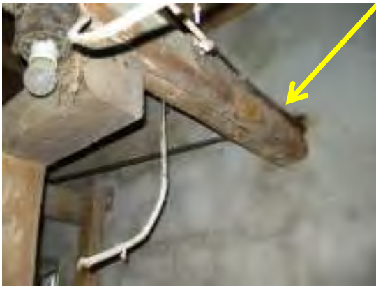
Järnets förankring i bindbjälken.
