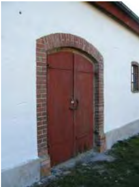
Västra fasadens södra port där basen på tegelom- fattningarna är helt omgjord.
