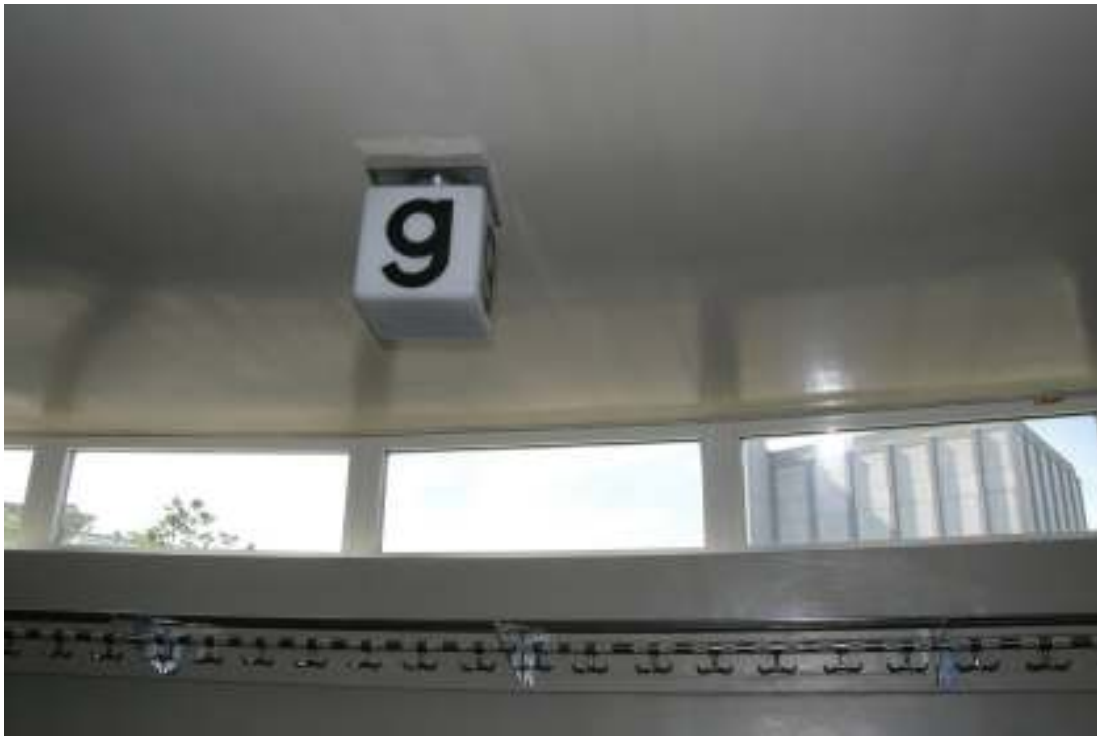
Hatthyla och fönsterrad i norra garderoben, utan sprinkler.
