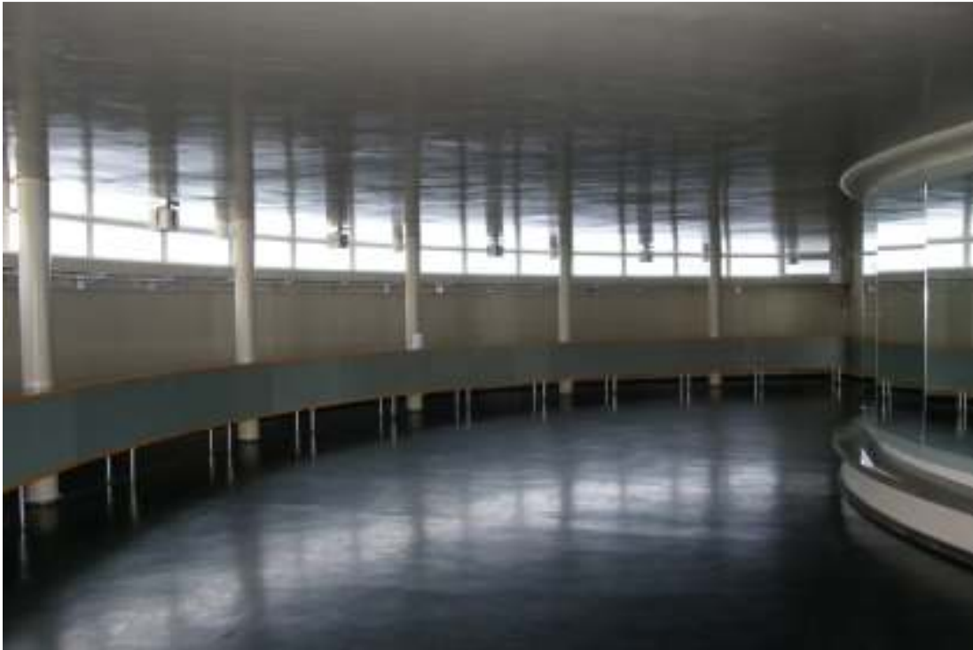
Översikt norra garderoben utan sprinkler.
