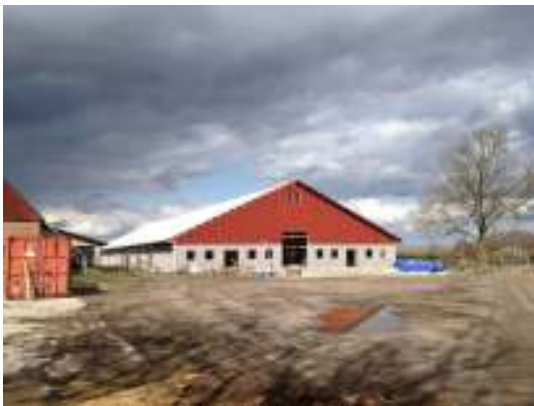
Byggnaden från söder med gavelröstets falurödfärgade panel på plats.
