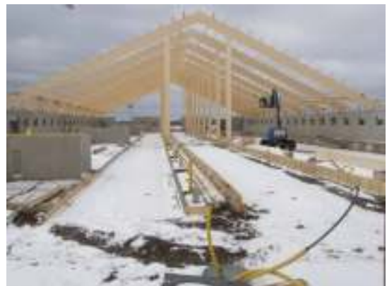
Arbetet med takstolarna försenas på grund av hård blåst under vintern 2011.
