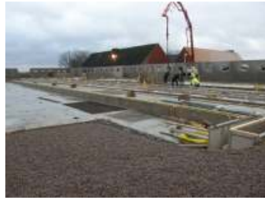
Inifrån djurstallet under den tidiga gjutningen av golv och inredning.
