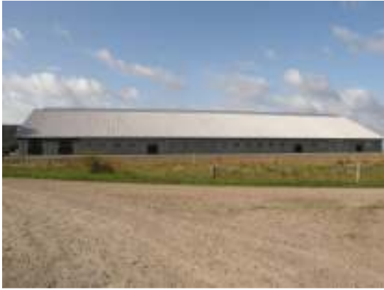
Byggnadens nordöstra fasad vid slutbesiktningen.
