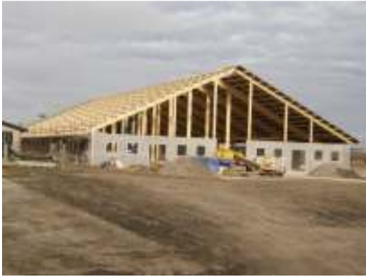
Byggnaden från söder. Alla takstolar på plats och Sembonittaket på väg upp.
