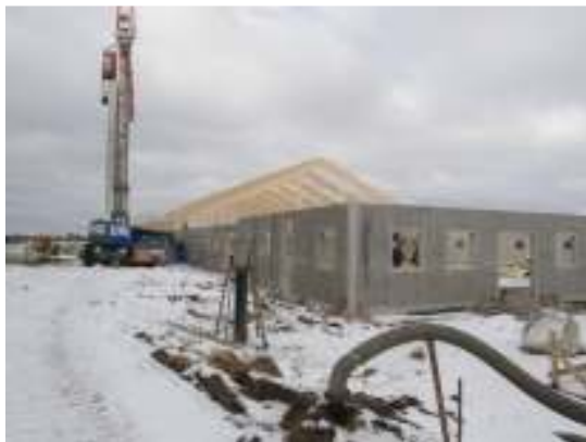
Från söder, under monteringen av takstolarna.
