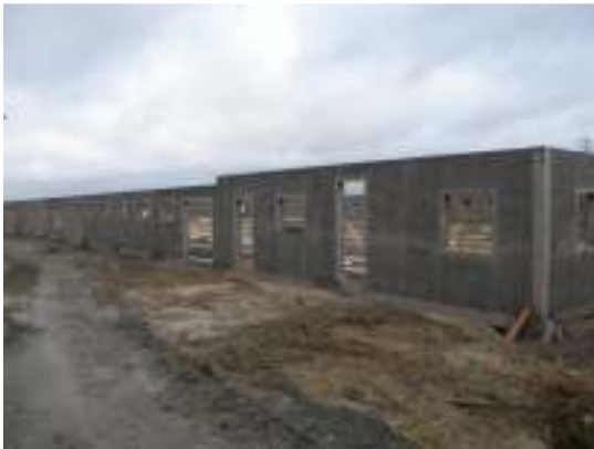
Byggnaden från söder under uppsättandet av väggarna.
