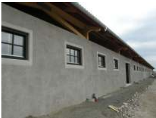
Fönstren på den nordöstra fasaden.
