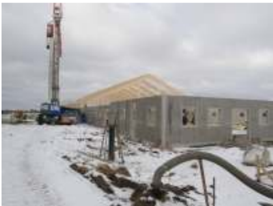
Från söder, under monteringen av takstolarna.
