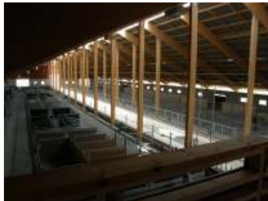
Från läktaren på hela byggnaden inifrån. Notera ljusläppet frånnocken.
