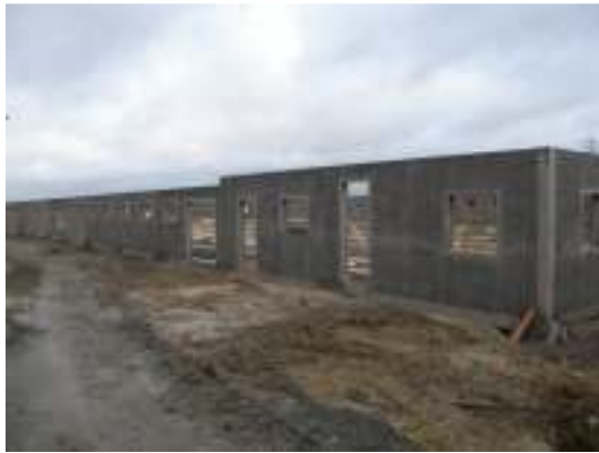
Byggnaden från söder under uppsättandet av väggarna.
