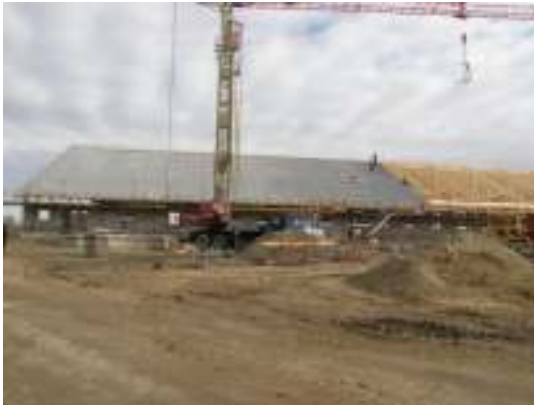
Byggnaden från sydväst.
