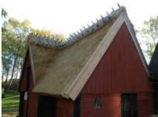
Fig. 3. Norra takfallet efter arbetet.
