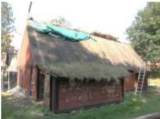
Fig. 6. Före arbetet. Notera trätaket.
