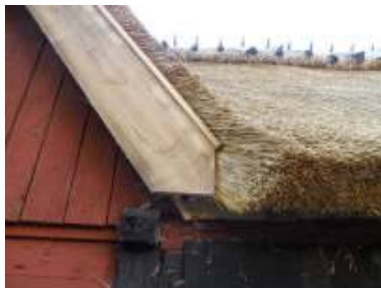
Fig. 4. Detalj av vindskiva vid rännaldalen.
