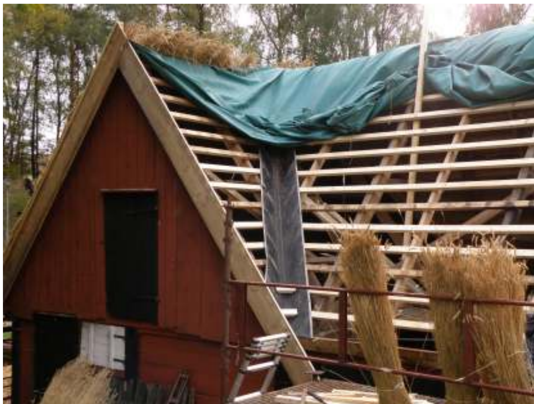
Fig. 2. Uthusets norra takfall, inkl. rännaldalen, under arbetet. Notera de små korta, vinkelställda läkterna som börjat monteras i rännaldalen.
