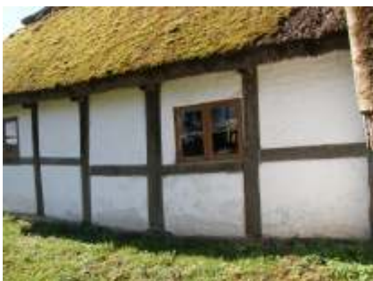
Fasaden på norra längan vid stuan innan åtgärderna.
