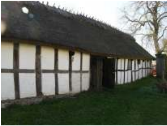
Västra längan före åtgärderna.
