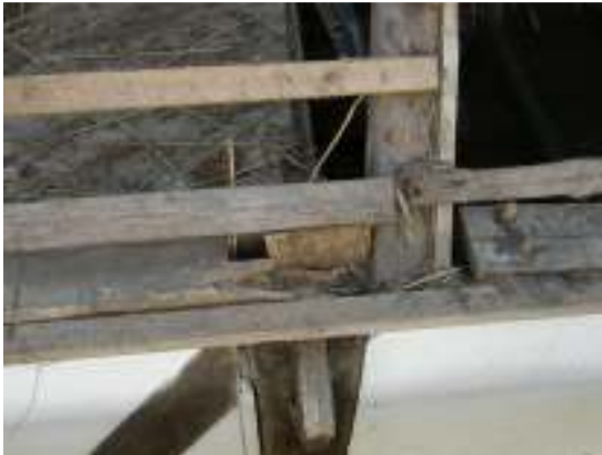
Lejden på östra längan frilagd under åtgärderna.
