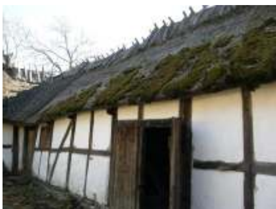
Taket på östra längan före avtäckning.
