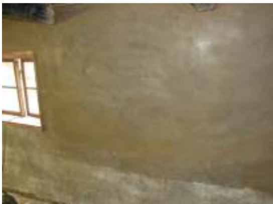
Väggen efter att den är återuppbyggd och lerklinad.
