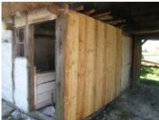
Porten på den södra längan med den nya träpanelen.
