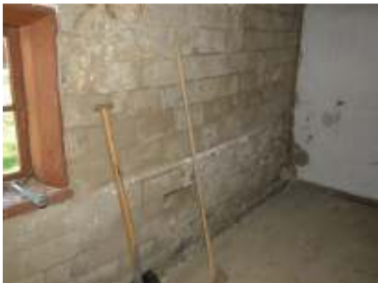
Den blottlagda lerstensväggen i stuan.
