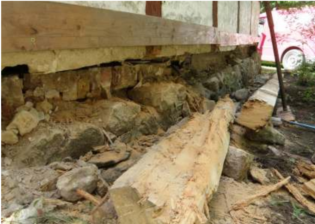
Det gamla fotträet urtaget. Notera fixeringen av sackfyllningarna.
