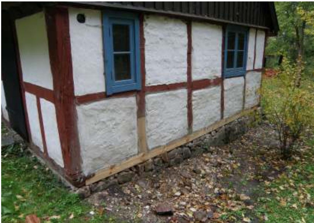
Efter arbetet. Notera den lagade stolpen.
