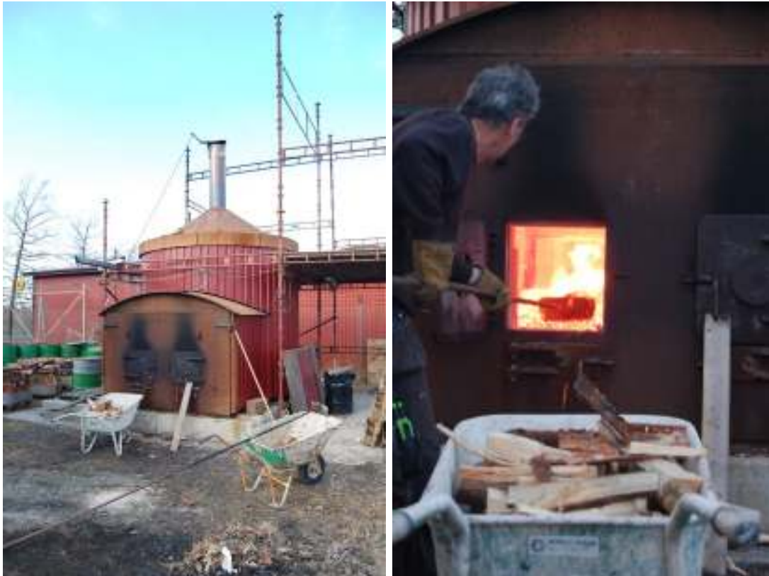
T.v. Kalkugnen i Mariestad. T.h. Eldning i kalkugnen, notera de två eldstadsöppningarna. Foto Henrik Nilsson
