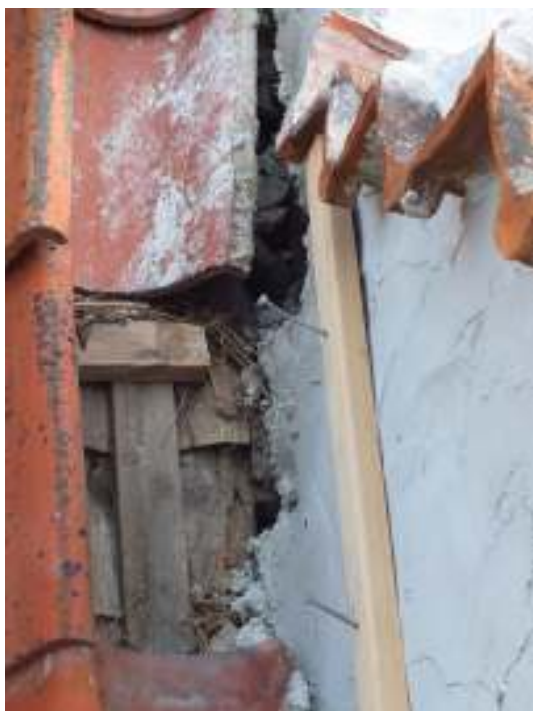
På korets anslutning mellan tak och gavel gjordes en plåtanslutning av bly. Plåten utfördes enligt samma teknik som på vapenhuset och långhusets blyplåt. Korgaveln putslagades och tegelavtäckningen på tinnarna murades om.
