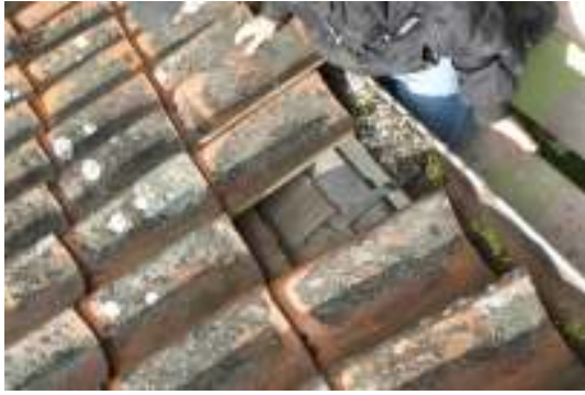
Ny fotplåt stacks in under stickepånen och nya hängrännor av zink monterades på långhus, vapenhus och kor.
