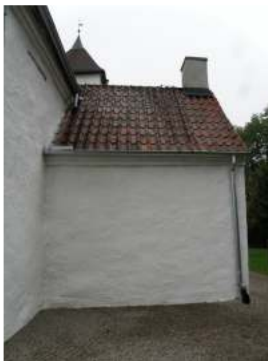
Sakerstians norra och östra sida efter färdig renovering. Stuprör och hängrännor tillverkades för hand av plåtslagaren.
