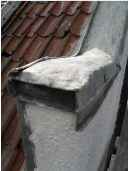
Till vänster: detaljbild av plåtavtäckningen på långhusets västra gavel. Till höger visar färdiga plåtarbeten vid långhusets nordvästra hörn. Anslagsplåten mellan tornets östra mur och långhustaket fästes på nytt till en träribba spikad i långhusmuren.
