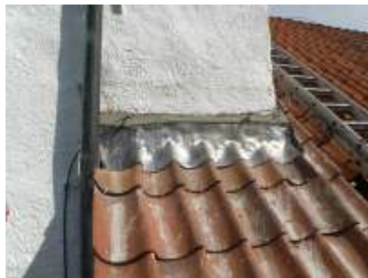
Ståndplåten vid tornets södra sida var otät och utförd av plåttisol. Plåten byttes till blyplåt som tätades med en putskant på traditionellt sätt. Även ståndplåten mot tornet vid långhusets södra takfall byttes till blyplåt.
