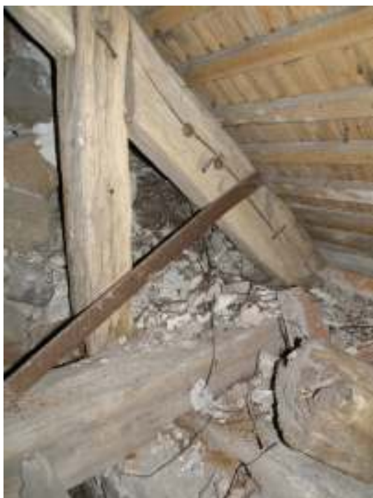
Södra delen av korets östra takstol hade rötskador vid takfoten och i stödbenets nedre del.
