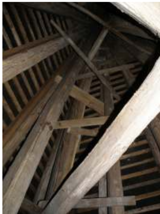
En sparre i torntaklaget påsalades och förstärktes med nytt virke. Att byta ut de skadade delarna hade varit ett stor ingrepp och kan endast göras i samband med att yttertaket tas ned. Bilden till vänster visar taklaget före renoveringen. Lagningen ses i bögra bildens mitt.
