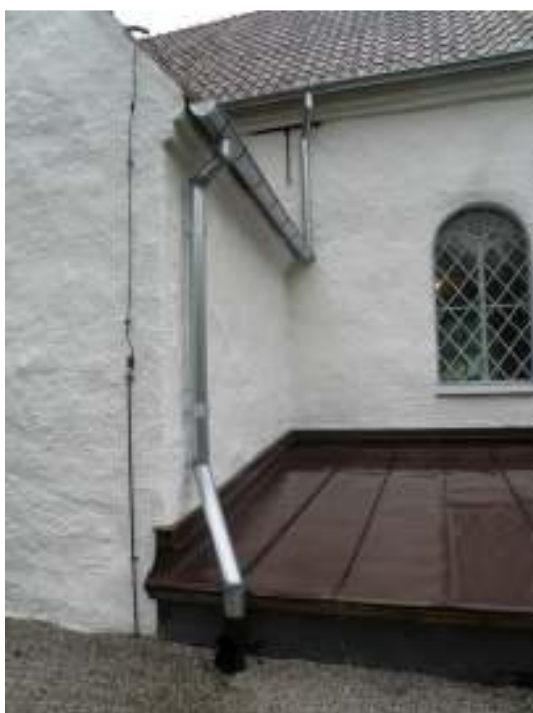
Sakerstians norra och östra sida efter färdig renovering. Stuprör och hängrännor tillverkades för hand av plåtslagaren.
