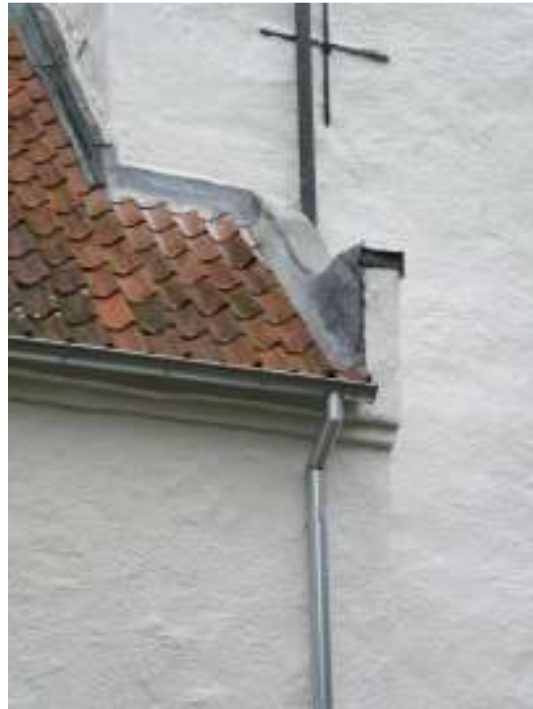
Till vänster: detaljbild av plåtavtäckningen på långhusets västra gavel. Till höger visar färdiga plåtarbeten vid långhusets nordvästra hörn. Anslagsplåten mellan tornets östra mur och långhustaket fästes på nytt till en träribba spikad i långhusmuren.
