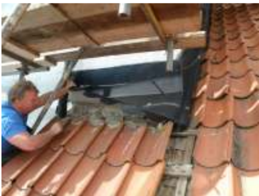
Ståndplåten vid tornets södra sida var otät och utförd av plåttisol. Plåten byttes till blyplåt som tätades med en putskant på traditionellt sätt. Även ståndplåten mot tornet vid långhusets södra takfall byttes till blyplåt.
