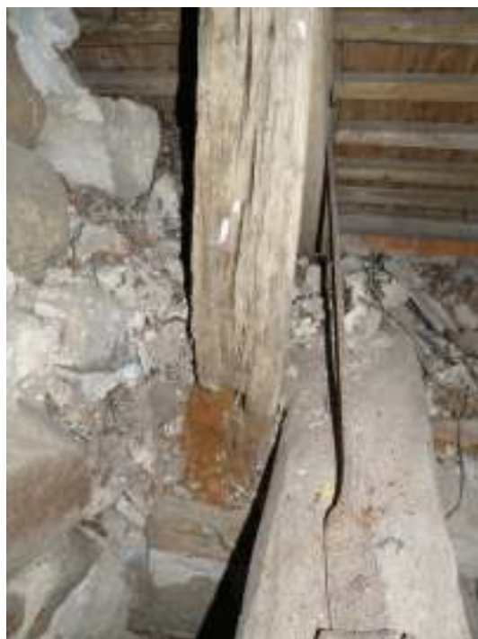
Södra delen av korets östra takstol hade rötskador vid takfoten och i stödbenets nedre del.
