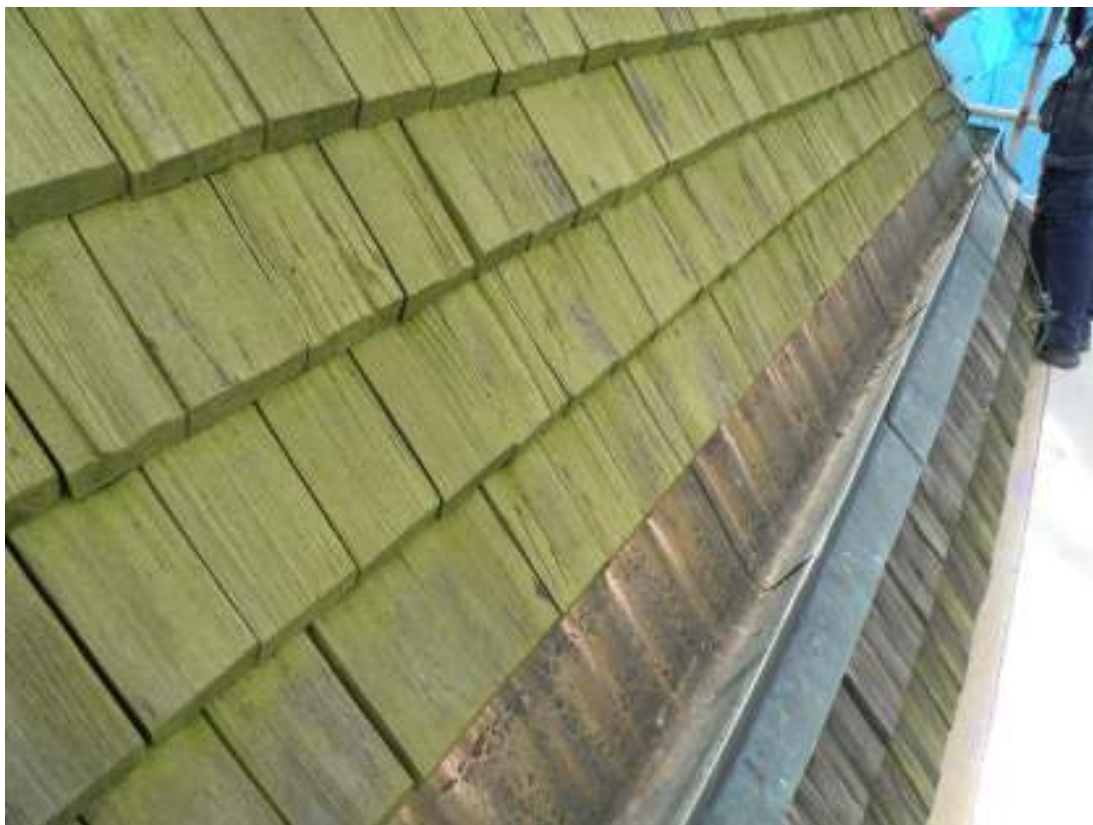
Tornets spåntak före rengöring och ommålning med tjära. Trästickorna var gröna av alger och mycket uttorkade av den tidigare anfärgningen med slipersolja.
