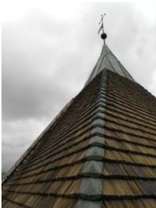
Tornets spåntak efter tjärning i två omgångar och till böger efter tjärning i tre omgångar.
