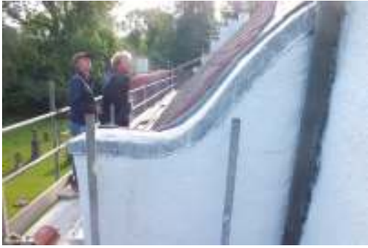
Västra gavelns avtäckning (t.v.) kompletterades med ny blyplåt och anslagsplåten av plåttisol vid tornets norra sida ersattes med blyplåt.
