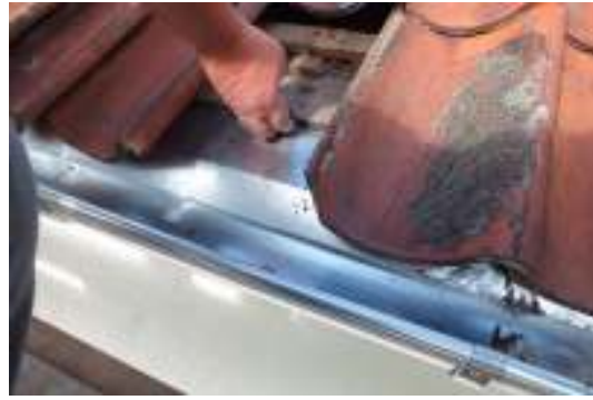
Ny fotplåt stacks in under stickepånen och nya hängrännor av zink monterades på långhus, vapenhus och kor.
