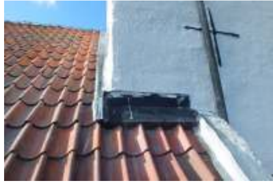
Västra gavelns avtäckning (t.v.) kompletterades med ny blyplåt och anslagsplåten av plåttisol vid tornets norra sida ersattes med blyplåt.
