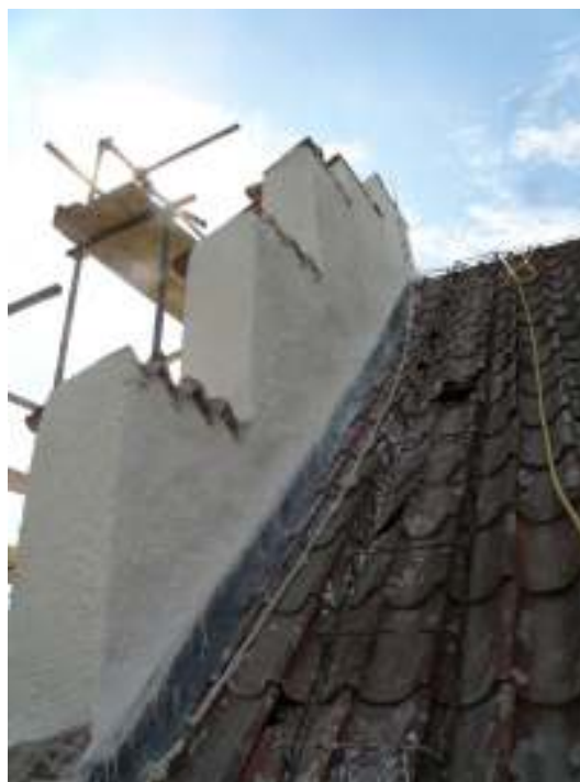
På korets anslutning mellan tak och gavel gjordes en plåtanslutning av bly. Plåten utfördes enligt samma teknik som på vapenhuset och långhusets blyplåt. Korgaveln putslagades och tegelavtäckningen på tinnarna murades om.
