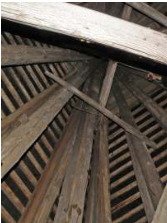
En sparre i torntaklaget påsalades och förstärktes med nytt virke. Att byta ut de skadade delarna hade varit ett stor ingrepp och kan endast göras i samband med att yttertaket tas ned. Bilden till vänster visar taklaget före renoveringen. Lagningen ses i bögra bildens mitt.
