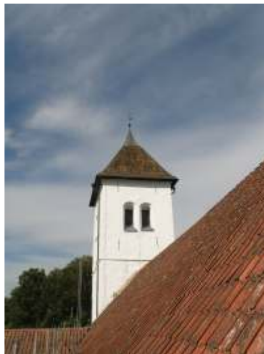
Tornets spåntak efter tjärning i två omgångar och till böger efter tjärning i tre omgångar.
