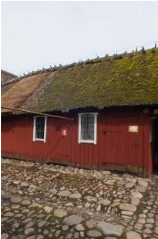
Taket över byggeboden i undantagslängan lades om under årets arbeten, t v före och t h under taktäckningen.
