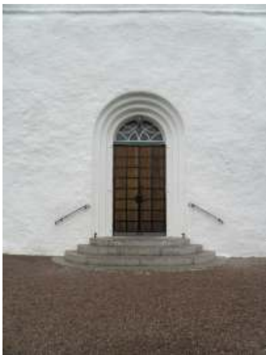
Kyrkans huvudingång i tornets västra fasad, efter renoveringen. Dörrbladen oljades och smidet svartmålades. Till höger syns en öppning i korets södra sida. Öppningens nättäckning kompletterades med finmaskigt nät.
