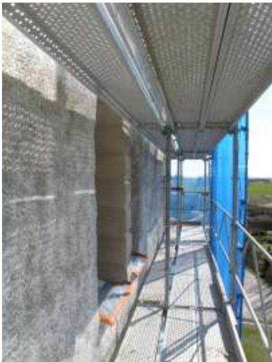
En del mindre puts-skador lagades. Bland annat putsades pelarna i ljudöppningarna om.
