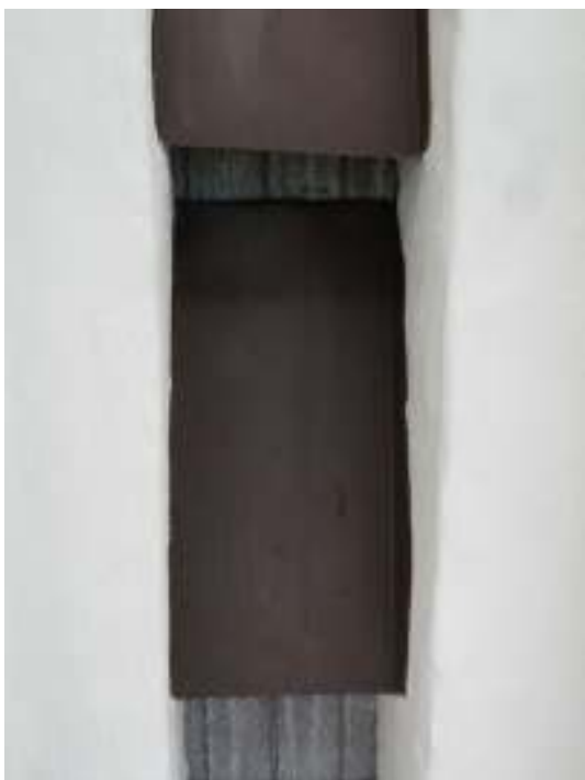
Plåtdetaljer brunmålades. Bilden visar en plåttäckning i en av korsarmens gavelöppningar. I fönsternischer och blinderingar sattes fågelbinder. Dessa är nästintill osynliga från mark.
