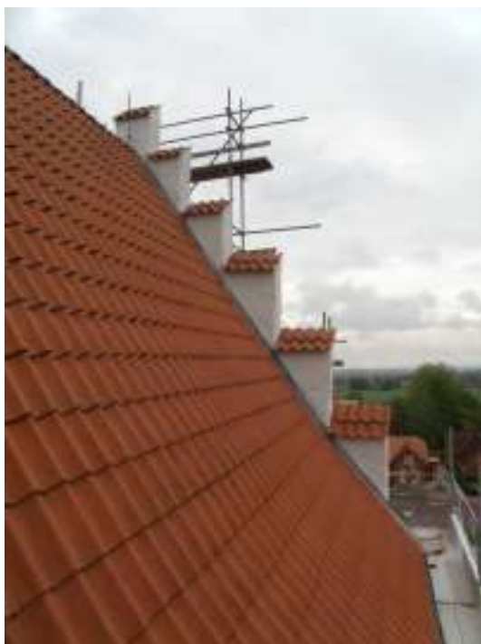
Tornets södra takfall efter renoveringen. Tinnarna på tornet putsades om. Takfotsbrädning och tassar till tornet målades om i vit linoljefärg
