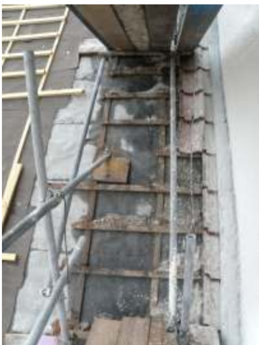
Takpappen och läkt närmast tornet på kyrkans norra takfall skulle bytas. Vid närmare undersökning beslöts att all takpapp och läkten på kor, långhus och korsarmens norra takfall skulle bytas. Renoveringen utfördes på samma sätt som på kyrkans södra delar vilka täcktes om under 2001. I de takfall som lades om med ny papp och läkten monterades luftningsventiler.
