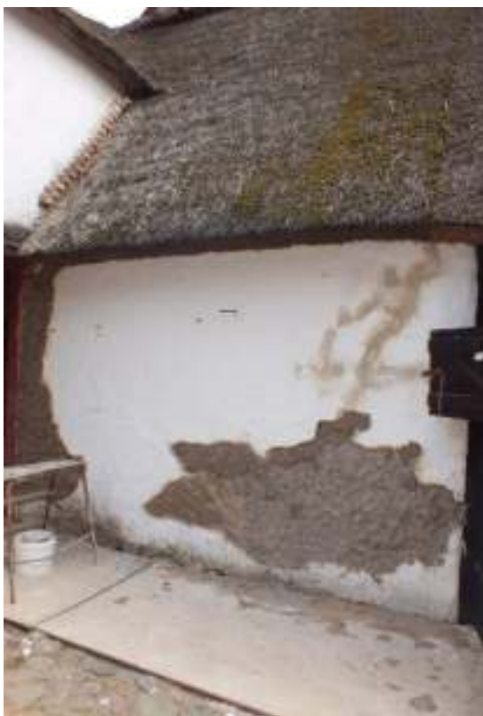
Den putsade lerstensväggen på Gammel Boels gårdssida mellan portgången och den svartmålade dubbelporten lagades både in- och utvändigt. T h är väggen färdigputsad med kalkbruk och avfärgad med kalkmjölk.
