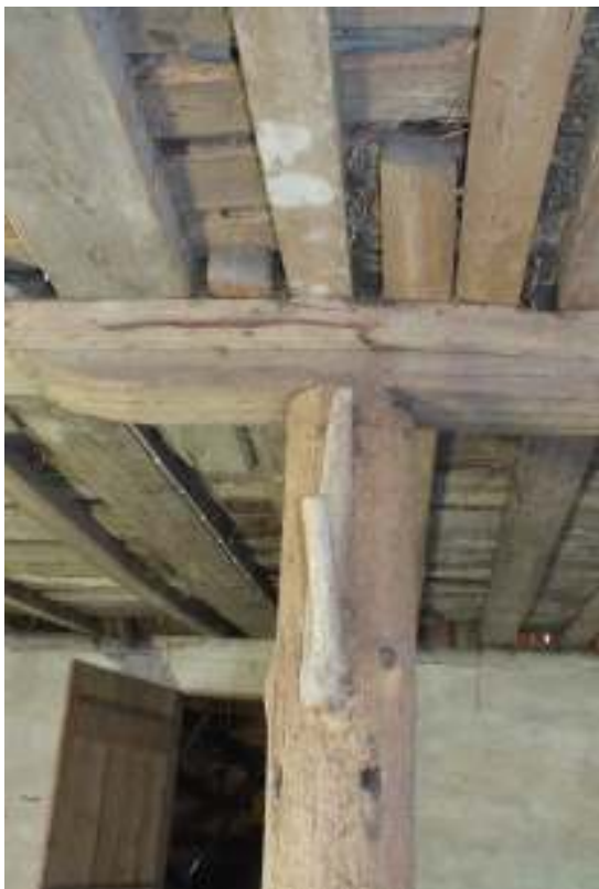
I vagnshuset intill porten har takbjälken ovanför mittstolpen knäckt. Konstruktionen som orsakat skevheter i ytterväggen förstärktes med ytterligare en stolpe som placerades på grundmuren intill ytterväggen.
