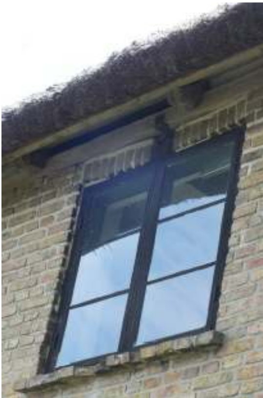
Gästrummets fönster, före (t v) och efter (t h) lagningen och ommurningen ovan- och nedanför fönstret.
