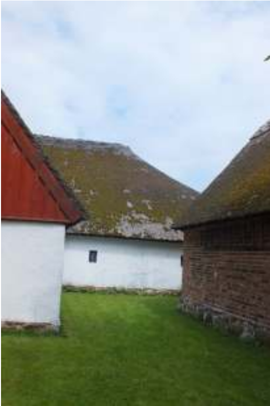
Vasstaket på höglogens södra takfall före (t v) och efter (t h) borttagning av mossa.
