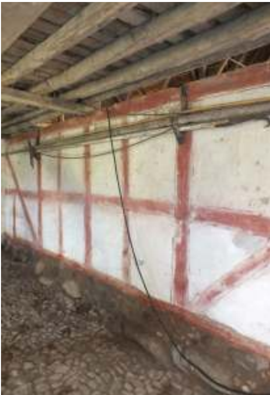
Korsvirkesväggen i vagnsuset mot Gammel Boels hus hade inte avfärgats på länge varför man passade på att måla medan huset var tomt. Den röda slamfärgen koktes enligt traditionellt recept på plats av lägerdeltagarna.
