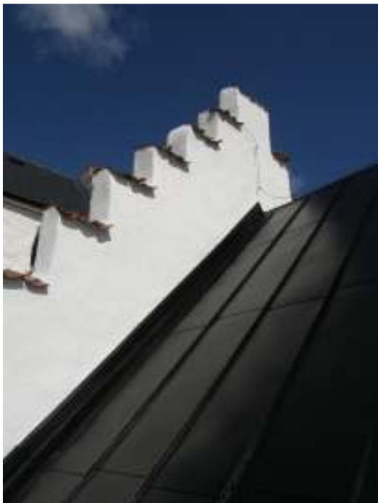
Kortaket efter åtgärderna.
