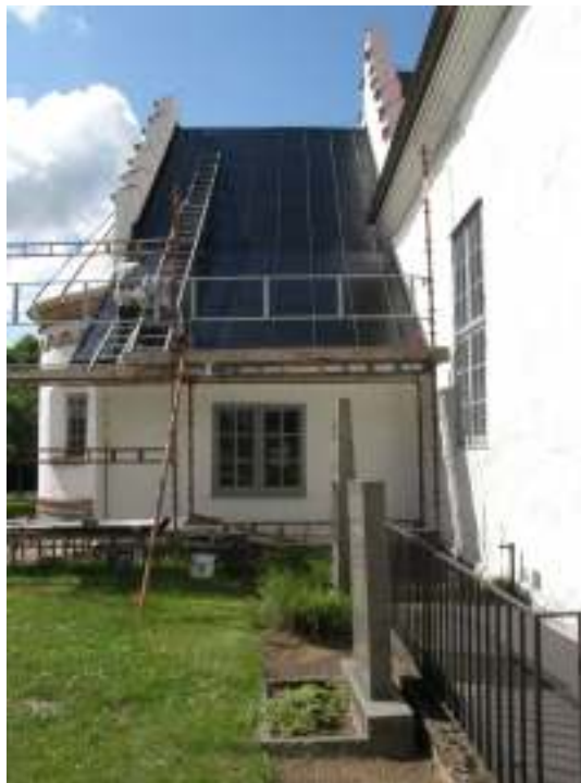
Det norra takfallet över koret, samt sakristian efter åtgärderna.
