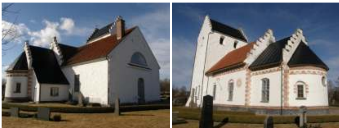
Kyrkans nordöstra och södra fasad innan åtgärderna.
