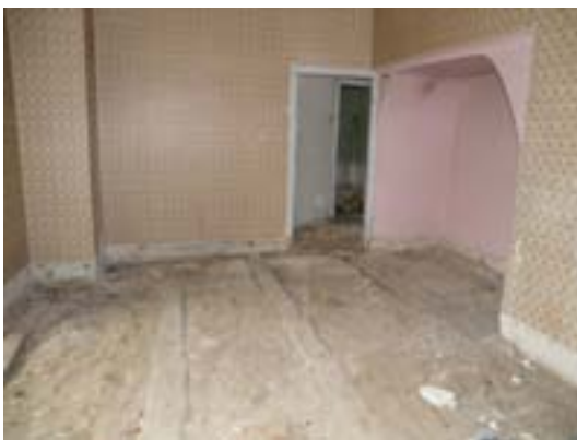
Rum 10 efter borttagning av golvplanken. Golvbjälkarna låg i djup fyllning av sand. Till böger har sanden delvis sugits bort. Nya ledningar till radiatorer i fönsternischen har installerats.
