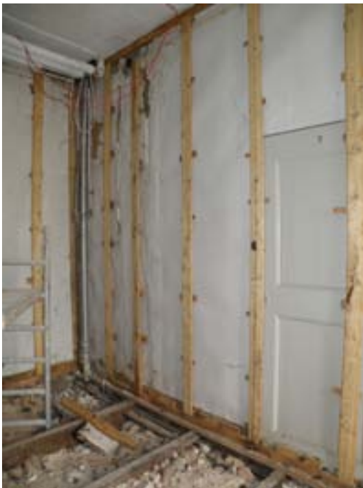
Korsvirkesväggen mot väster i rum 4 var klädd med ett skivmaterial på reglar. Under denna fanns flera tapetlager.
