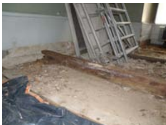
Golvhjälkar i rum 8 med förtagningar från äldre konstruktion. Till höger syns rum 7 efter borttagning av befintligt golv. Bjälkarna läg här på ett gjutet betonggolv.
