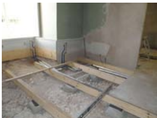
Till vänster syns rum 8 under renovering. Nya golvhjälkar lades på gjutna betongplintar. Till höger syns tapetlager i rum 7.
