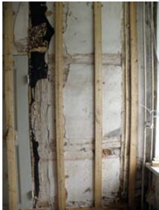
Korsvirkesväggen mot väster i rum 4 var klädd med ett skivmaterial på reglar. Under denna fanns flera tapetlager.
