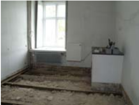
Rum 4 under renovering och efter borttagning av den där belägna skorstenen.
