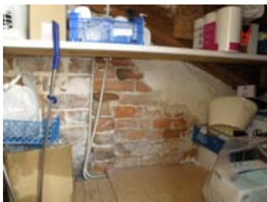
Muröppningen till nischen är delvis synlig från östra sidan om muren, från en städskrubb under trappan i rum 9. Öppningen är igenmurad med renässansförband (t.h.) och tegel i ett mindre format än omgivande murverk (t.v.).
