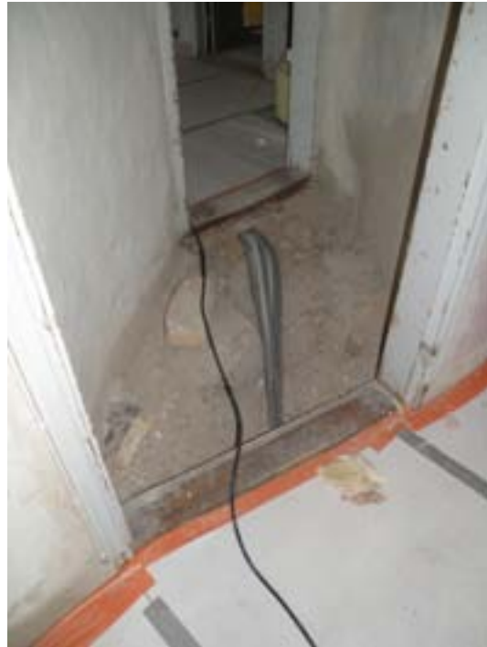
Invid murarna i rum 10 syntes ett hårt kalkbrukslager delvis. Eventuellt rester av ett kalkbruksgolv. Till höger syns muröppningen till tornet i norr. Elledningar drogs under nytt golv.
