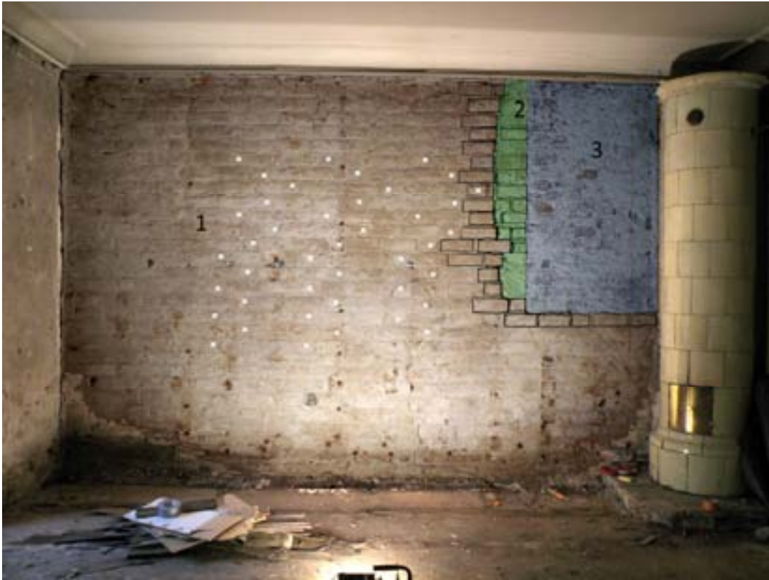
I rum 7 blev murverket i den ursprungliga norra muren synligt. Murverket var murat i jämna skift med koppstenarna lagda i sicksackmönster (illustrerat med kryss). En tunn slammad puts fanns ovanpå. En sekundär muröppning (2) med däri uppmurad fönsteromfattning (3) mättes upp.
