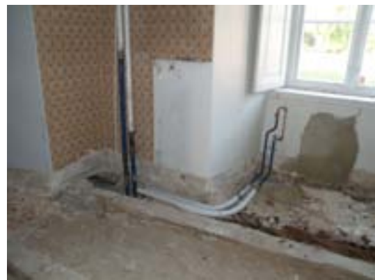
Rum 10 efter borttagning av golvplanken. Golvbjälkarna låg i djup fyllning av sand. Till böger har sanden delvis sugits bort. Nya ledningar till radiatorer i fönsternischen har installerats.
