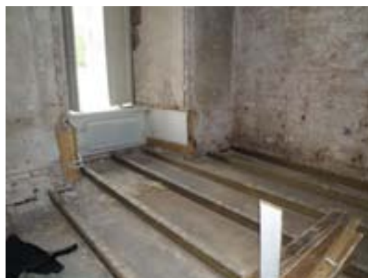
Golvhjälkar i rum 8 med förtagningar från äldre konstruktion. Till höger syns rum 7 efter borttagning av befintligt golv. Bjälkarna läg här på ett gjutet betonggolv.
