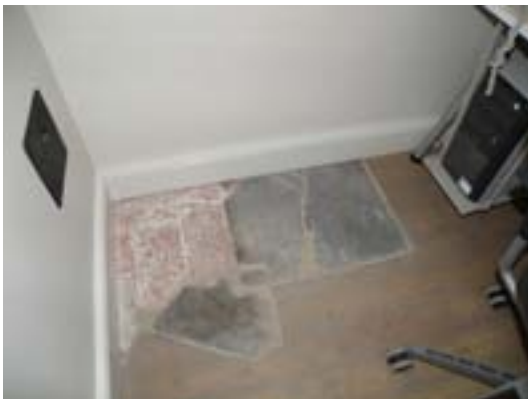
Golvet i rum 4 med det tillvaratagna kakelugnsfundamentet. Taket i rum 6 vänspändes och målades.
