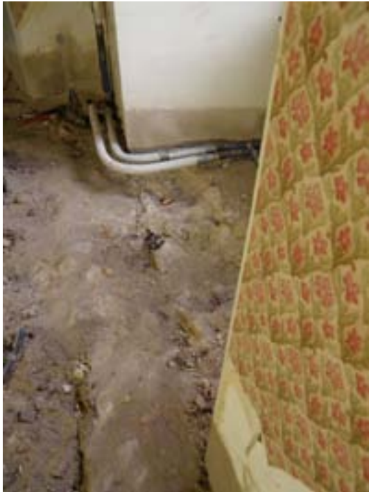
Invid murarna i rum 10 syntes ett hårt kalkbrukslager delvis. Eventuellt rester av ett kalkbruksgolv. Till höger syns muröppningen till tornet i norr. Elledningar drogs under nytt golv.
