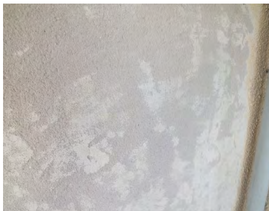
Bild på fasaden under arbetet med att skrapa och rengöra.
