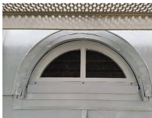
Ramarna ersattes och byggdes upp efter gamla förlagan, den målades i samma kulör som taket.
