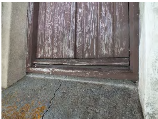
Tornluckor och solbänk före.
