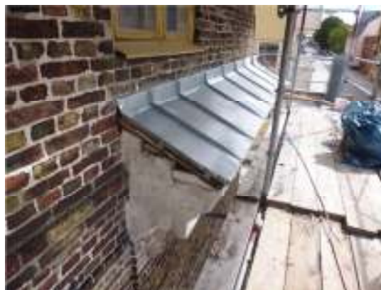
Fig. 12. Utdragen gesims efter plåttäckning.
