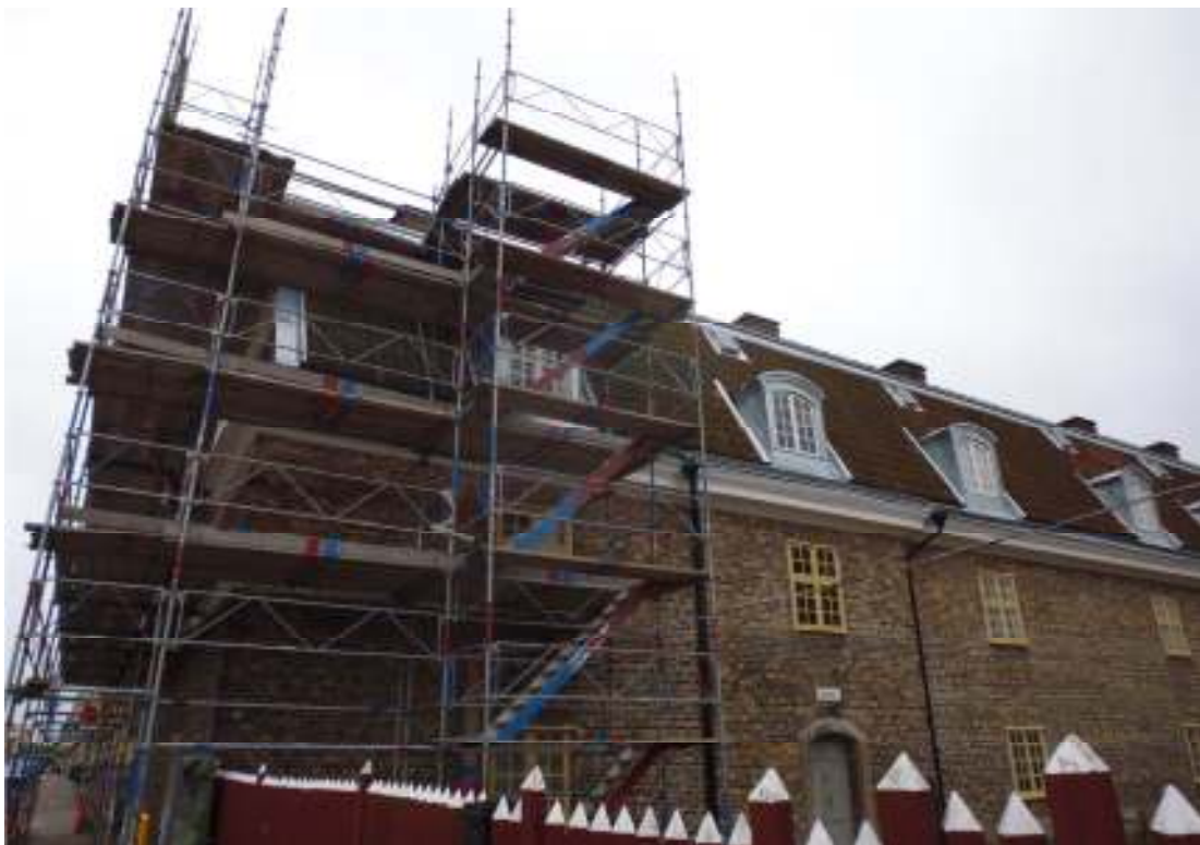
Fig. 14. Norra långsidan färdig. Notera de ommålade fasadfönstren.
