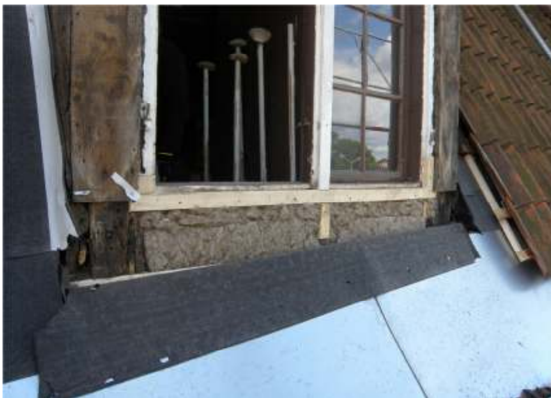
Fig. 10. Isoleringsmaterial under fönster. Isoleringen sträcker sig ca 1 meter under fönstret.
