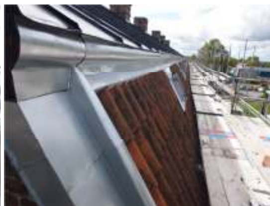
Fig. 4. Vy över omklädd mansardtaksvinkel.
