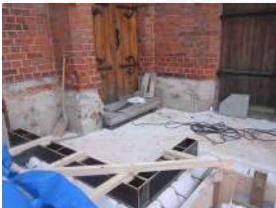
Grundplatta under gjutningsarbeten.
