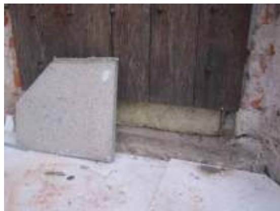
Dörren till pannrummet kapades i nederkant.
