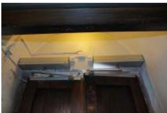
Nya dörröppnare monterade på den gamla ytterdörrens dörrblad. Bilden till höger visar varmluftsfläkten som monterades i det befintliga vindfånget till södra korsarmen.
