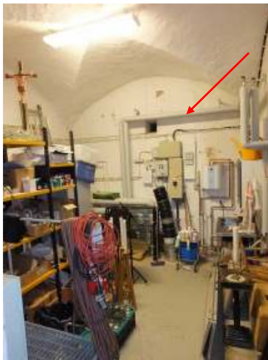
I pannrummet tillkom ledningsdragnig för värme till vindfånget. Bilden till vänster är före och till höger är efter installationerna. Pilarna visar ledning för värme som drogs genom den gamla dörröppningen till den nya entrébyggnaden.
