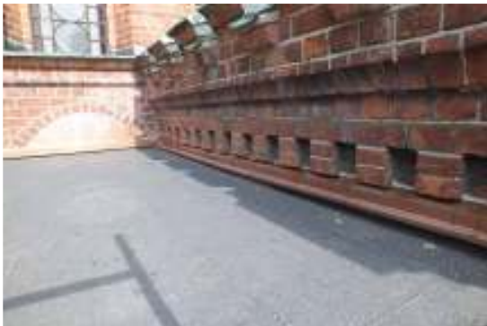
Yttertaketets oavsida av takpapp och anslutningsplåt av koppar.
