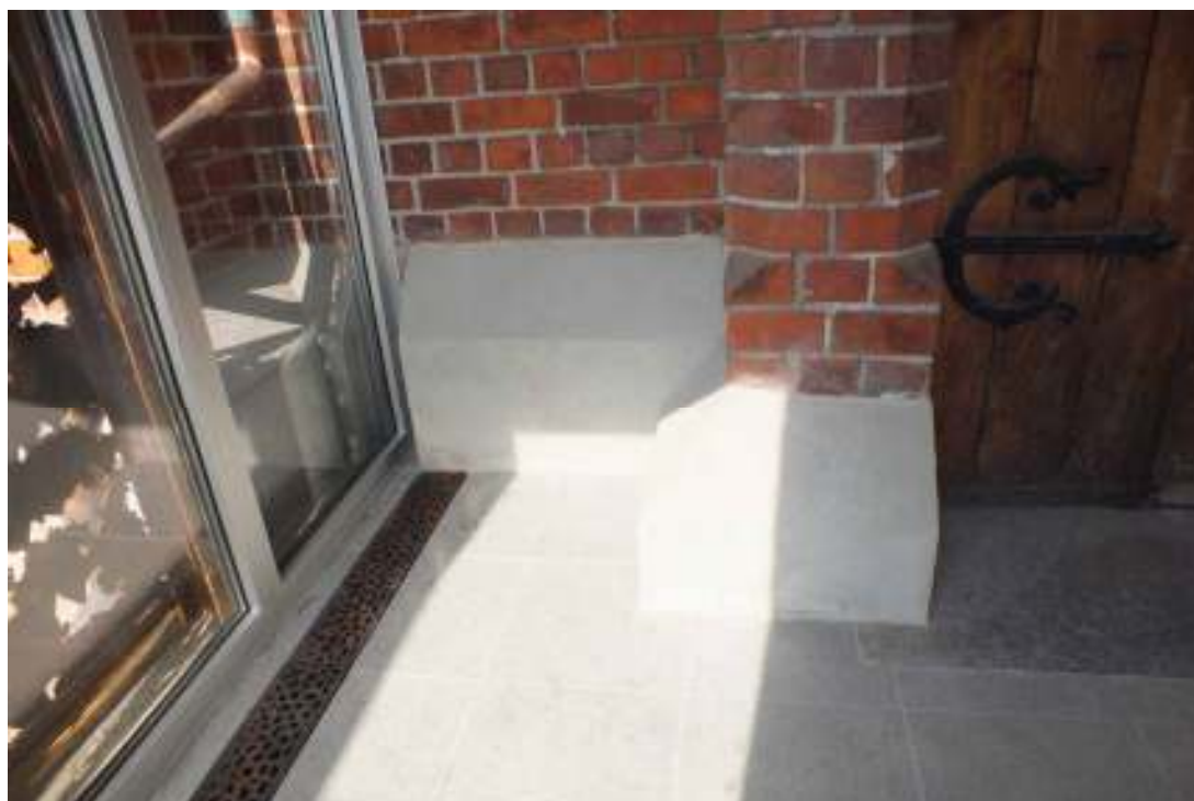
Sockelpartiet i den nya entrébyggnaden gjordes om. Den sentida beklädnaden med skåffer togs bort och sockeln putsades med en slätputsad yta i samma profil som den befintliga beklädnadsmuren.
