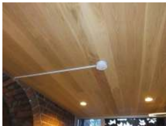
En brandvarnare monterades i innertaket i den nya entrébyggnaden.
