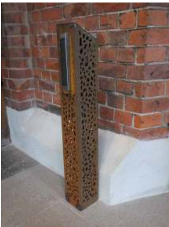
Bilden till vänster visar armbågskontakten till dörröppningen för vilken en pollare av corténstål tillverkades. Kontakten inne i kyrkan och utvändigt utfördes på samma sätt.
