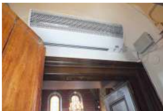
Nya dörröppnare monterade på den gamla ytterdörrens dörrblad. Bilden till höger visar varmluftsfläkten som monterades i det befintliga vindfånget till södra korsarmen.
