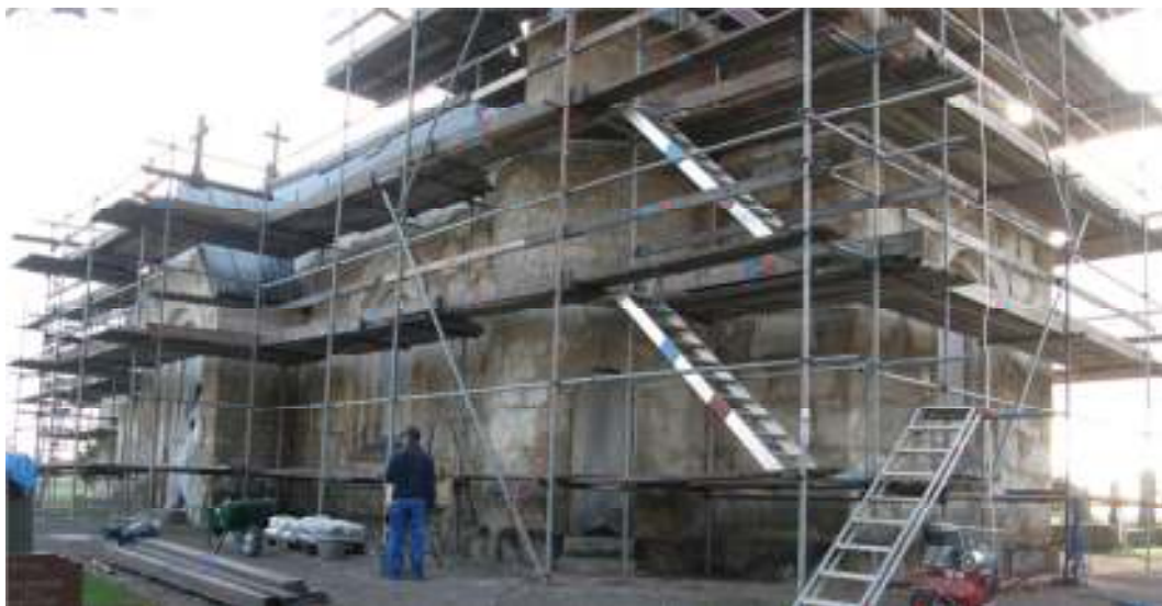
Kyrkan från nordväst under renoveringen. Så snart ställningarna kom på plats undersöktes fasaden och man kunde snabbt konstatera att renoveringen skulle komma att bli mer omfattande än vad som angavs i handlingarna.
