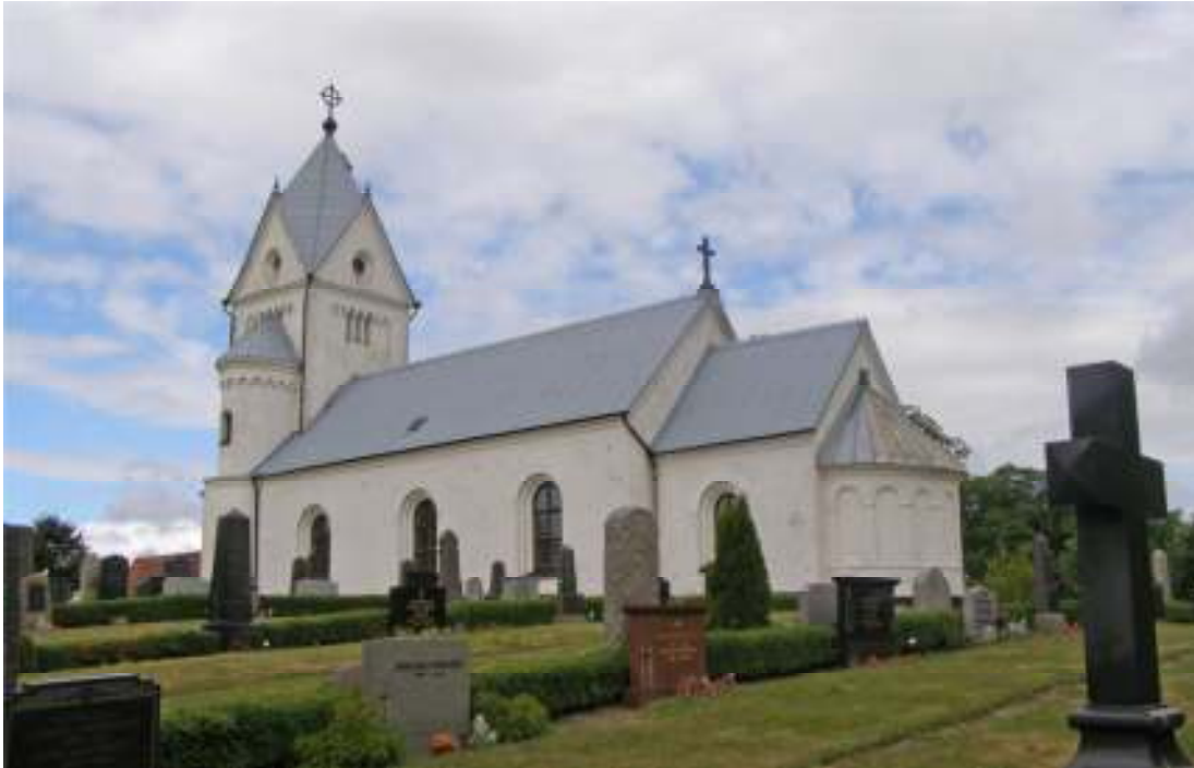
Kyrkan mot söder före renoveringen.
