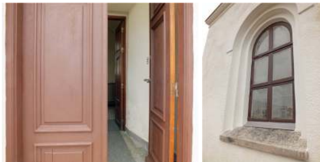
Dörrar och fönster har målats om med linoljefärg i den befintliga brunröda kulören. Ommålning av solbänkarna återstår.
