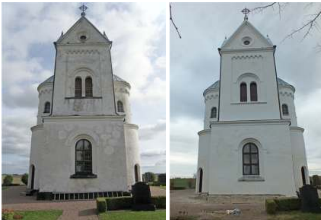
Västra fasaden med tornet före och efter fasadrenoveringen. Utmed hela grunden återstår lagning, putsning och målning. Även målning, svart färg, av solbänkarna återstår.
