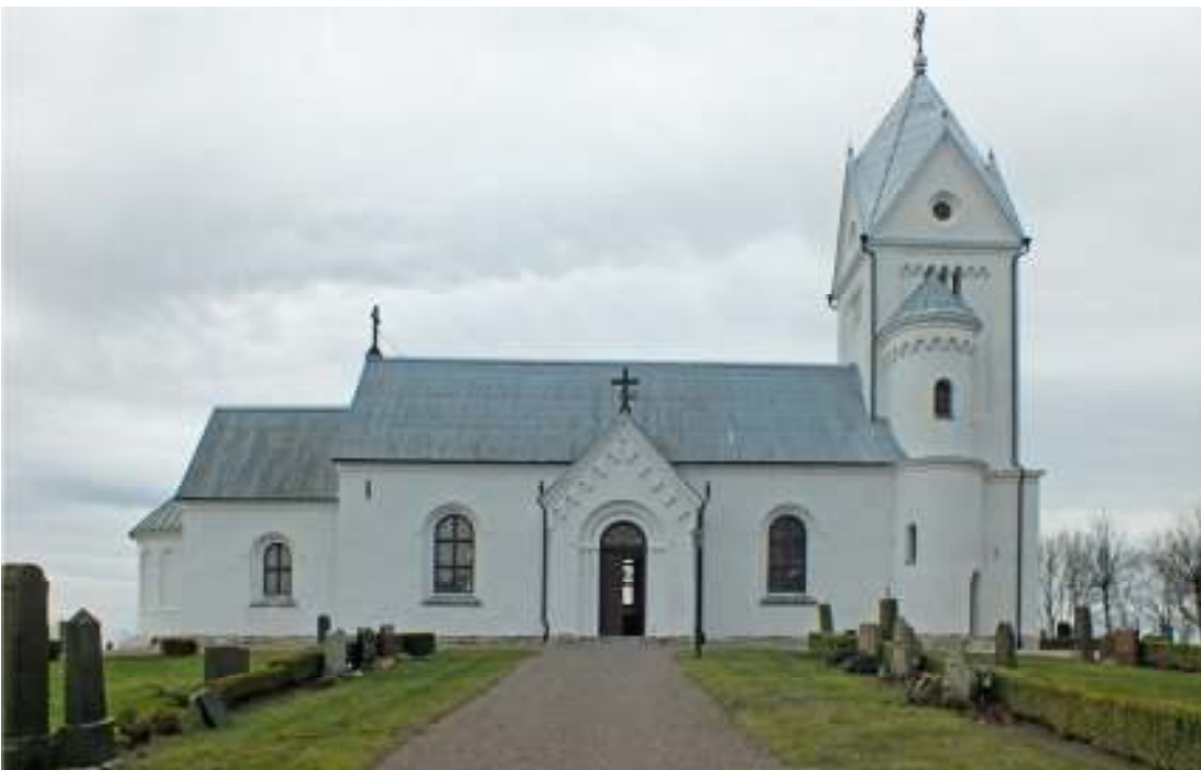
Kyrkan från norr med huvudentrén efter renoveringen.
