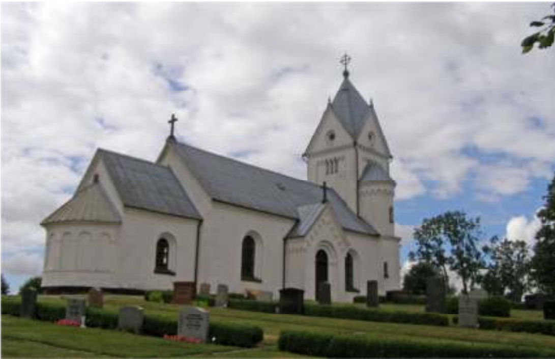
Kyrkan sedd från nordost före renoveringen.
